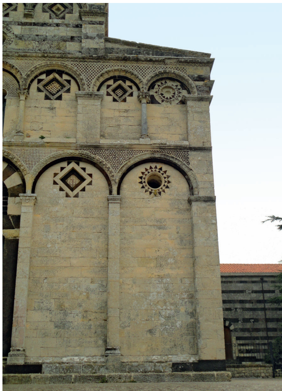
Fig. 7.—Borutta (Sassari), iglesia de San Pietro di Sorres, detalle de la fachada.
