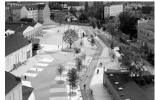
BIG-Topotek1-Superflex, progetto del parco urbano Superkilen. In ordine: vista dall'alto sulla "Red square", vista aerea sulla "Black square"; Copenhagen, 2011
