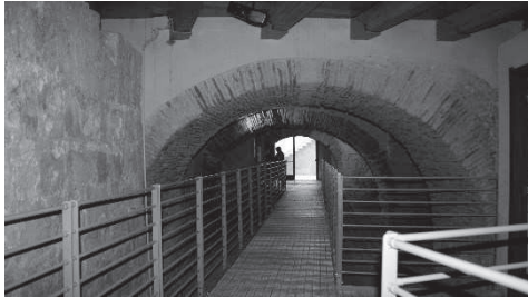
Fig. 11- Ammorsamento delle strutture settecentesche ad elementi appartenenti alla linea di difesa tre-quattrocentesca (Mattana, Schirru 2003)
