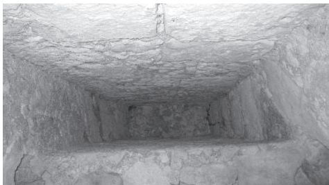
Fig. 14- Locale voltato nell'area dell'ex Caserma: apertura per la ventilazione
