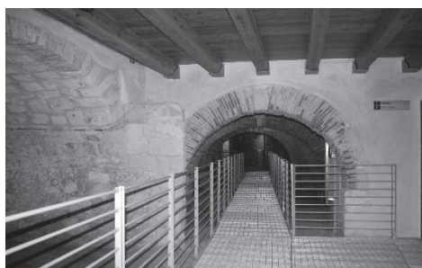
Fig. 9- Porta di soccorso e conservazione dell'apertura funzionale alla ventilazione dei locali. Dal punto di vista costruttivo si osserva l'impiego di un manto di canne per la realizzazione della volta; si tratta di una tecnica costruttiva storica impiegata anche in altri segmenti del percorso
