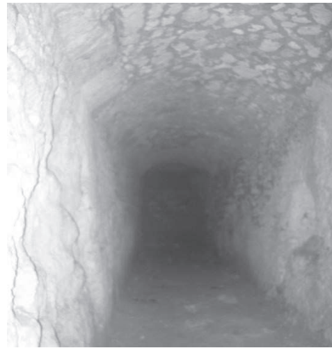
Fig. 15- Tunnel voltato conservato nei sotterranei della Scuola di Architettura
