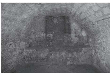
Fig. 10- Ambienti voltati conservati nelle cosiddette "segrete". Lo spazio presenta segmenti murari di matrice tre-quattrocentesca, setti murari cinquecenteschi e strutture voltate riconducibili alle trasformazioni di epoca sabauda
