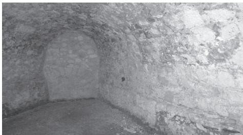
Fig. 13- Locale voltato nell'area dell'ex Caserma; si osserva l'impiego di un manto di canne per la realizzazione della volta
