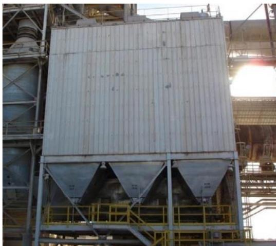
Figura 3.4. Dispositivo di controllo polveri (Haynes e Kramer 1982).
