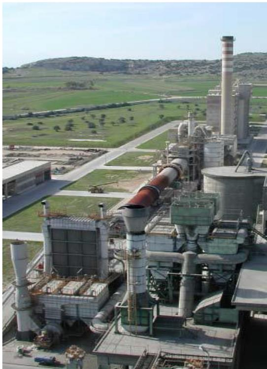
Figura 3.3. Impianto di produzione del cemento (Italcementi Group, 2015)
