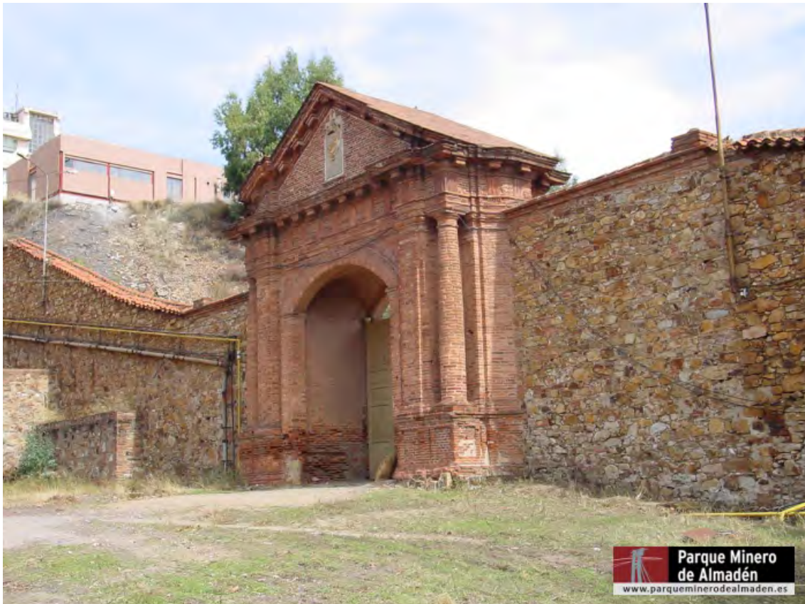
Figure 31. Interior sight of Puerta de Carlos IV . Source: Parque Minero de Almadén.
