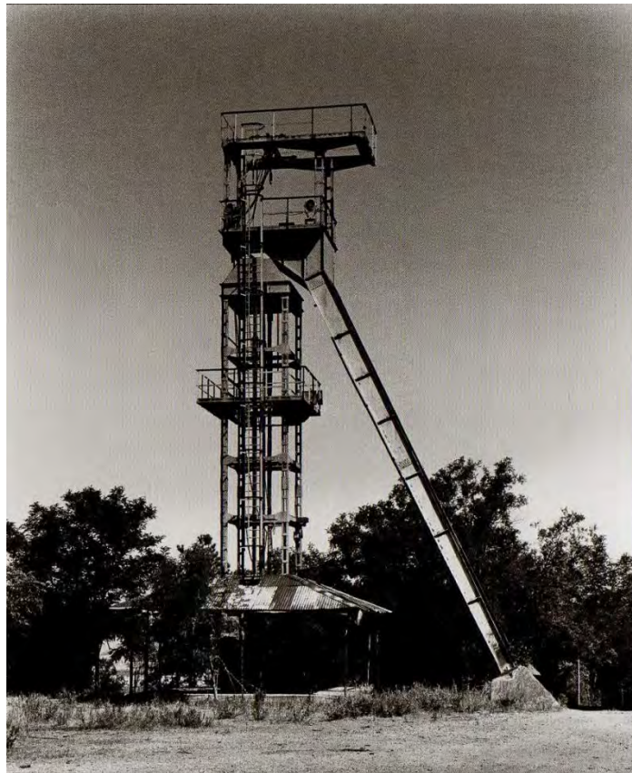
Figure 1. Shaft n.2 of Rigoloccio. Source: Preite, M. Paesaggi industriali del Novecento , 2006.
