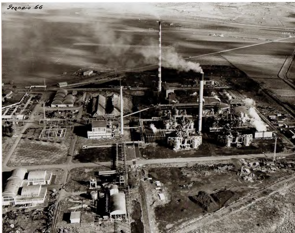
Figure 15. The plant of the sulphuric acid of Casone (Scarlino). Source: Preite, Paesaggi industriali del Novecento , 2006.
