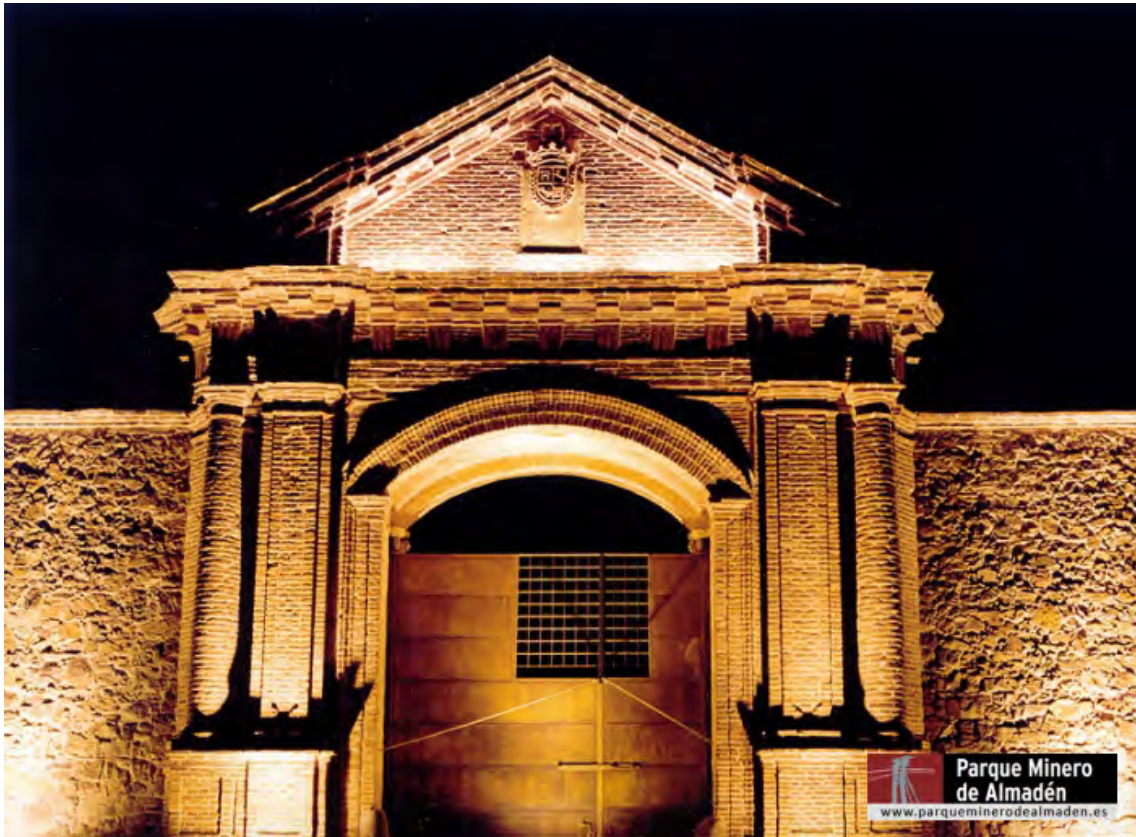
Figure 30. The exterior of the Puerta de Carlos IV . Source: Parque Minero de Almadén.
