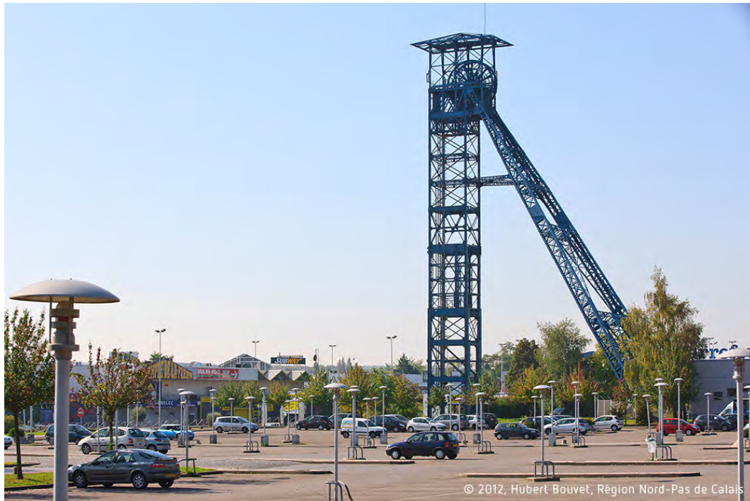
Figure 18. Chevalement of the shaft 1a in Liévin. Source: www.bassinminier-patrimoine mondial.org
