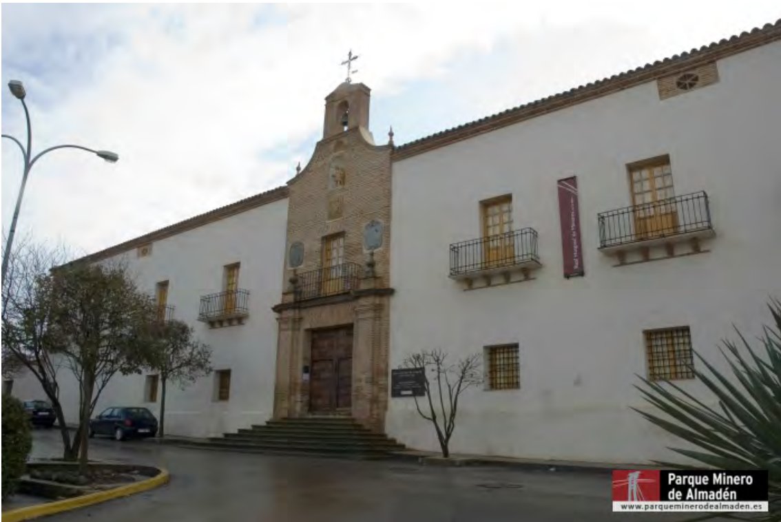
Figure 22. The actual Mining History Archive. Source: Parque Minero de Almadén.
