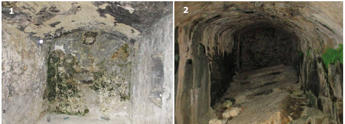
Fig. 5 Tunnel voltato nel fianco sud del bastione di Santa Croce a Cagliari (1) e a Peñíscola in Spagna (2). (Foto A.Pirinu)
