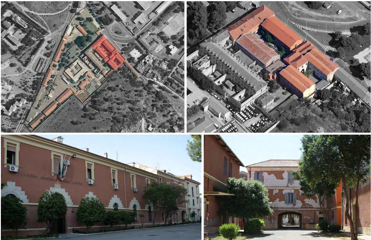
Fig. 1 - Localizzazione del complesso militare con evidenziata l'area oggetto di studio relativa alla Caserma Livio Duce e vedute dei piazzali interni.
