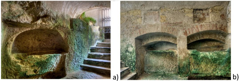
Figura 2.6 Particolari degli interventi di restauro condotti sul cubicolo; a) Volta di rinforzo intonacata; visibile la nuova imposta dell'arco. b) Arcosoli in laterizi.
