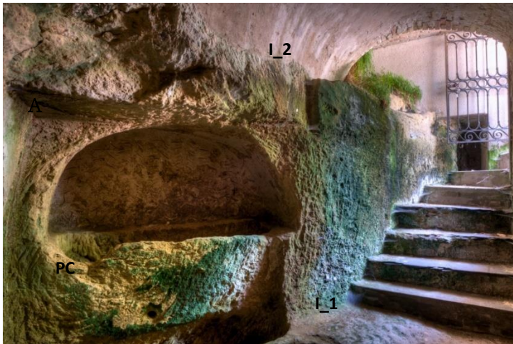
Figura 2.8 Parete B: intonaco originario a base di cocchiopesto (I_1); malta da restauro I_2 nella volta ricostruita, è visibile la nuova imposta della volta che si appoggia sulla roccia.
