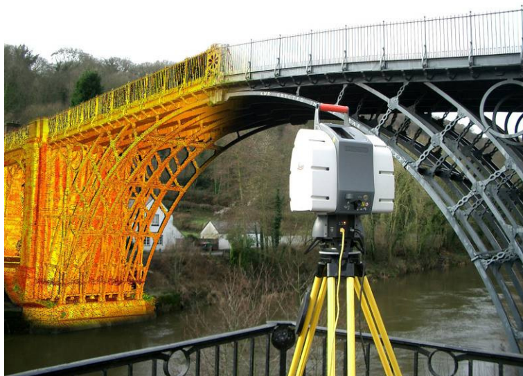
Fig. 35 – Rilievo con laser scanner e modello BIM di un ponte in acciaio
