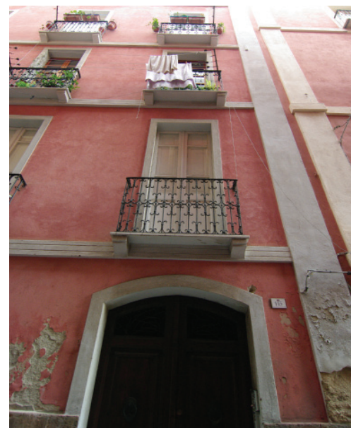
Fig. 112: Prospetto dell'edificio sito in via Lamarmora 115.
