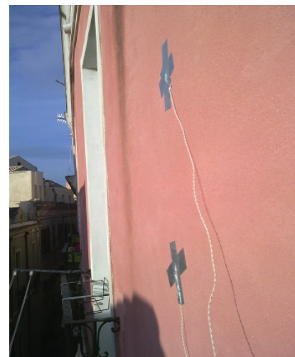
Fig. 73: Misura termoflussimetrica della parete: sensori.
