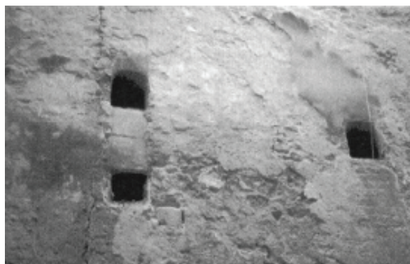
Fig. 97: Canne fumarie con uscita sul fronte di un edificio.
