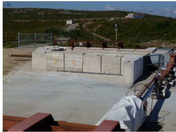
b). Fixed left caisson.
