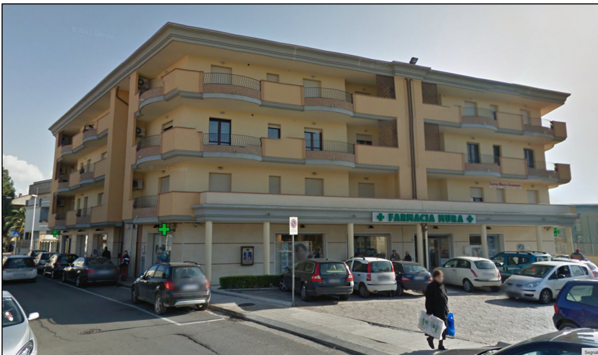
Fig. 101 – Vista del fronte principale della palazzina.
