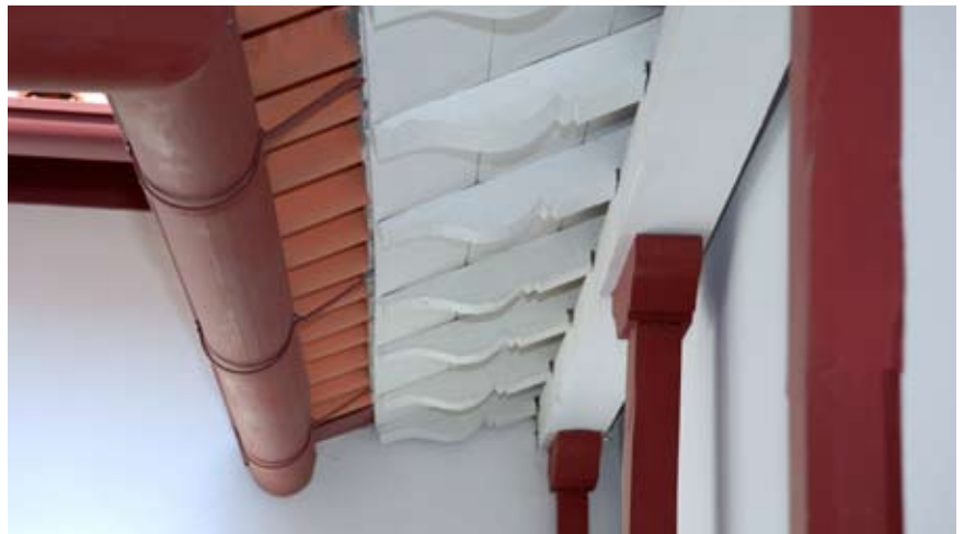
Fig. 9. Particolare della sporgenza della copertura.
