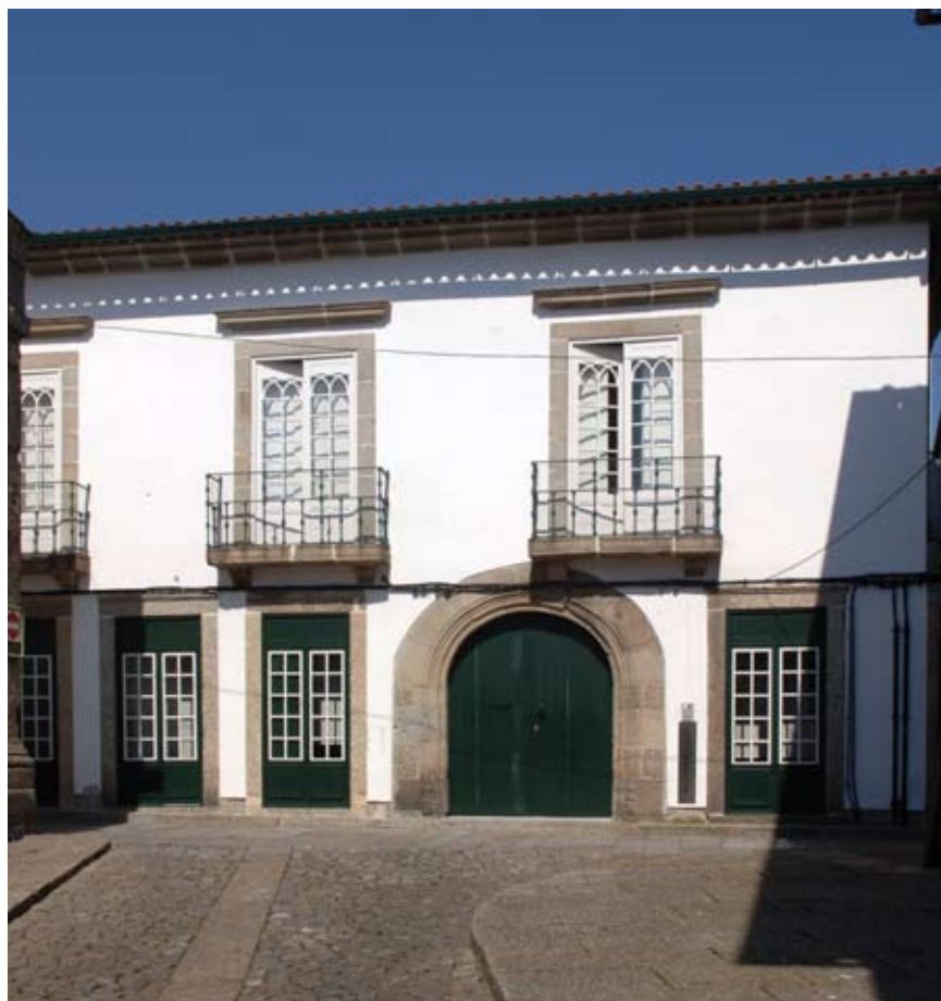
Fig. 3. Vista del fabbricato post intervento.
