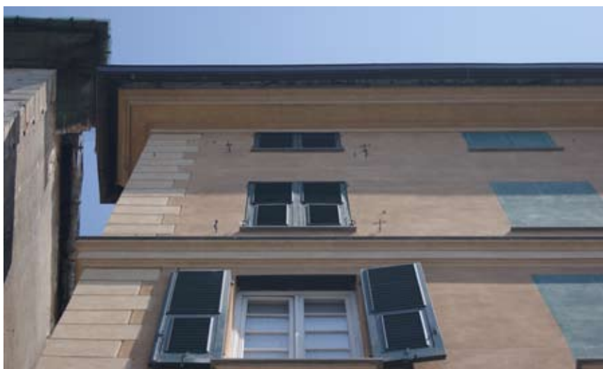
Fig. 13. Vista degli infissi dall'esterno dopo intervento.
