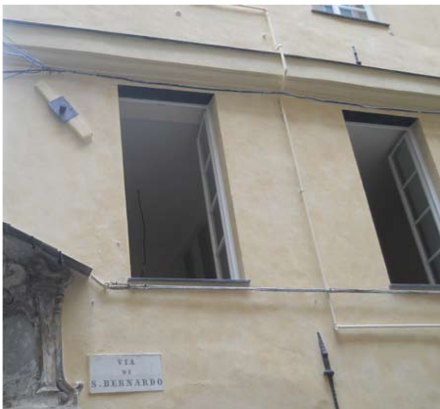
Fig. 14. Vista degli infissi dopo l'intervento.
