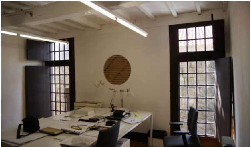
Fig. 20. Infissi appartenenti al tipo 3.
