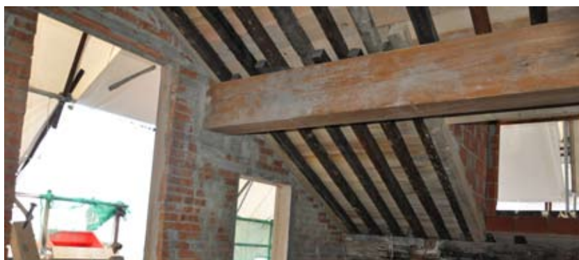
Fig. 112. Genova, Via Gramsci 9 , elementi storici ed elementi nuovi convivono in questa copertura.
