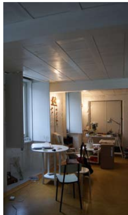
Fig. 94. Aspetto innovativo dei solai.
