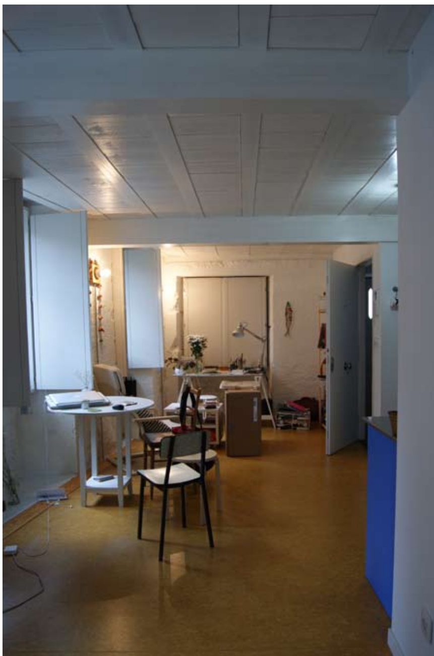
Fig. 7. Vista dell'intradosso e del pavimento in linoleum.
