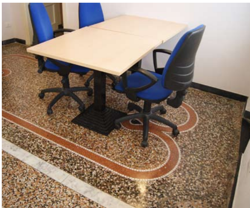
Fig. 7. Pavimentazione in graniglia.
