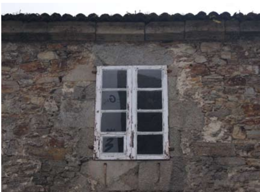
Fig. 85. Esterno infisso complanare.
