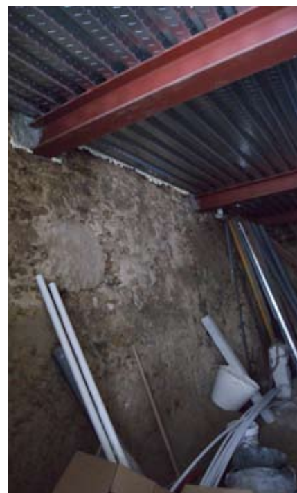
Fig. 91. Solaio in acciaio.
