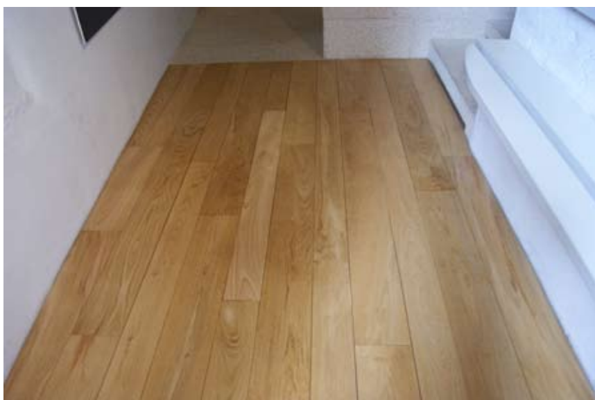
Fig. 8. Particolare del pavimento post intervento.
