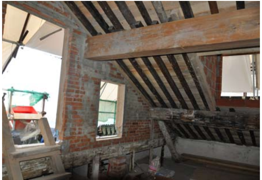
Fig. 12. Vista dell'unica trave sostituita.
