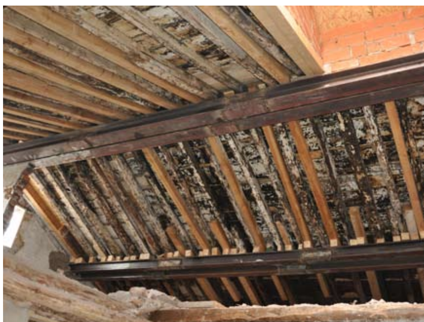
Fig. 23. Componenti storiche conservate con ausilio di profilati metallici.
