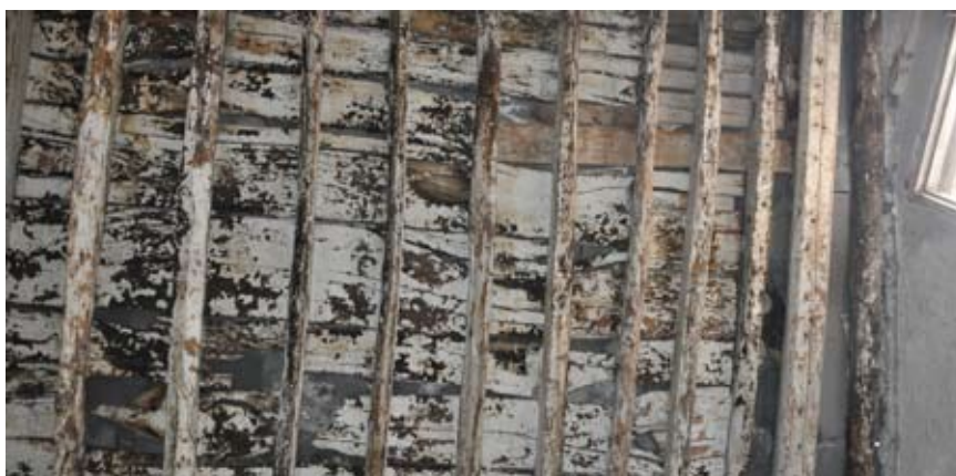
Fig. 8. Vista della copertura prima dell'intervento.
