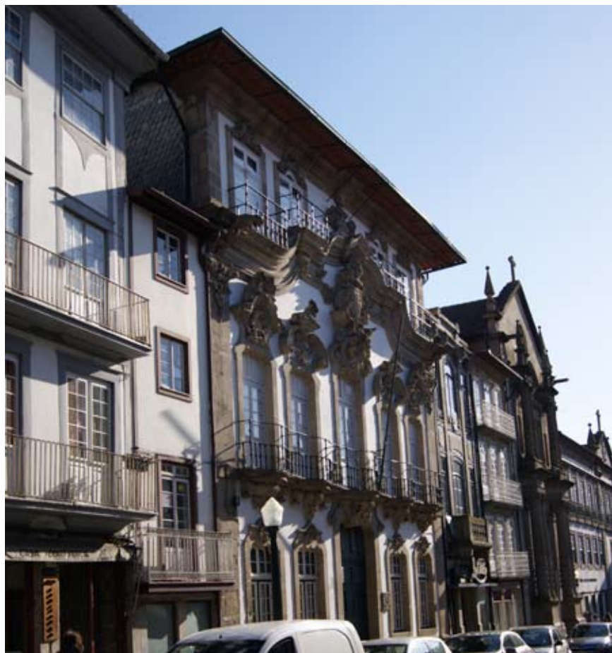
Fig. 3. Vista del fabbricato post intervento.
