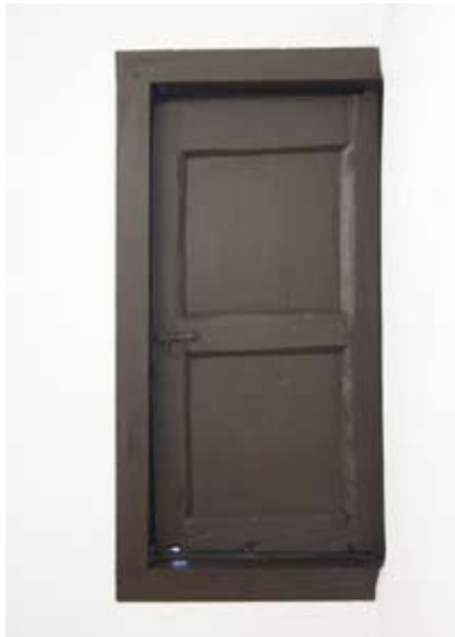
Figg. 18, 19. Vista di uno degli infissi e relativo scurino del prospetto principale.
