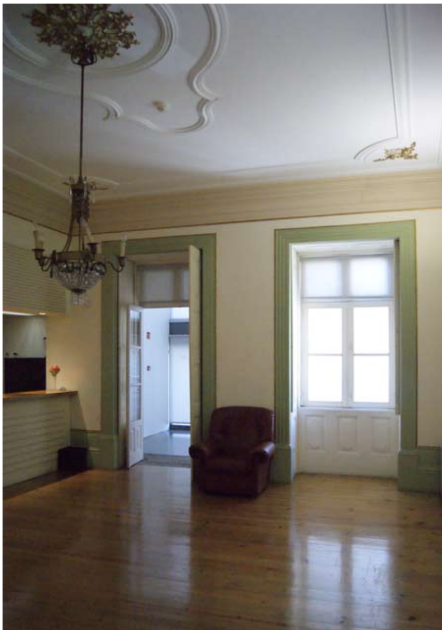
Fig. 5. Vista del pavimento e del controsoffitto.
