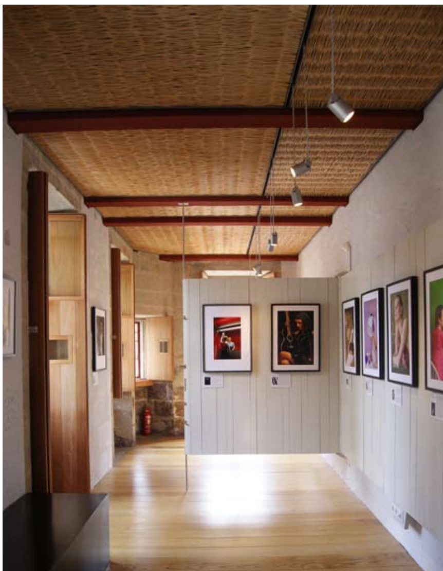
Fig. 6. Vista del controsoffitto in incanniccato e pavimentazione in pannelli.
