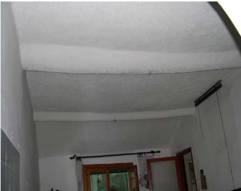
Fig. 10. Controsoffitto a seguire il profilo delle travi.
