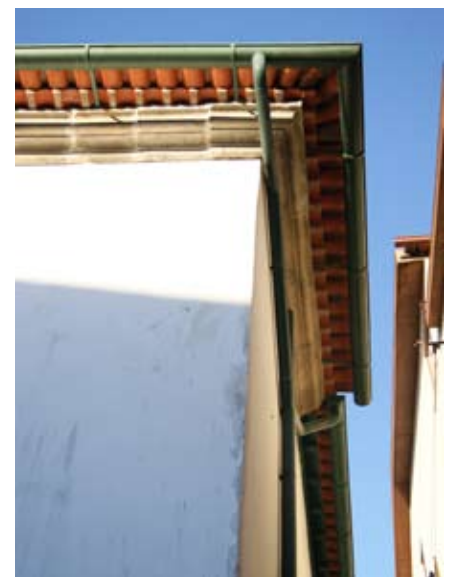
Figg. 49,50. Varianti di cornicioni: sinistra, parete in taipa; destra, parete in granito.
