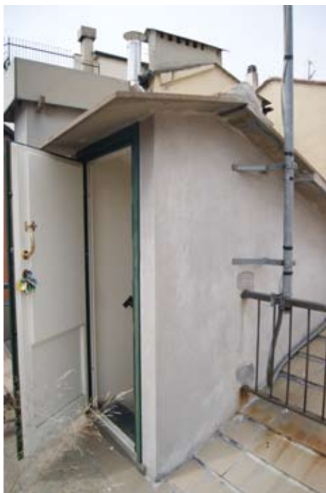
Fig. 13 Vista dell'accesso alla copertura.
