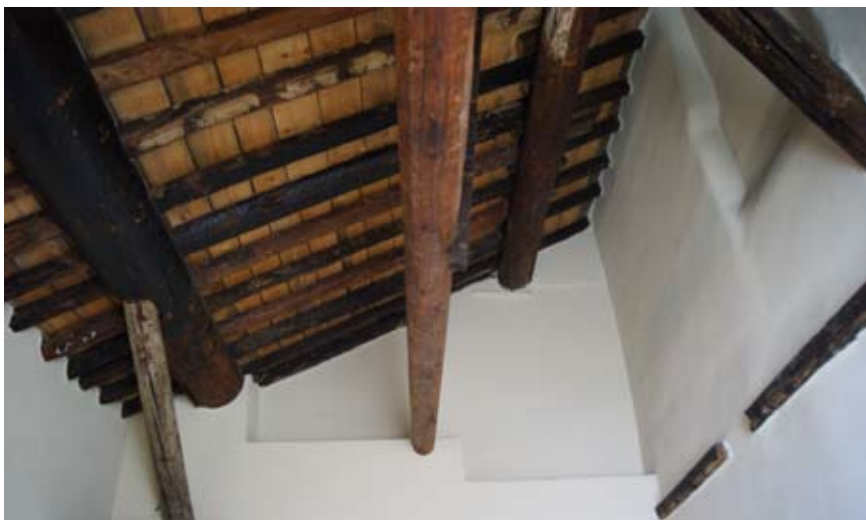
Fig. 10. Vista della copertura dopo l'intervento.
