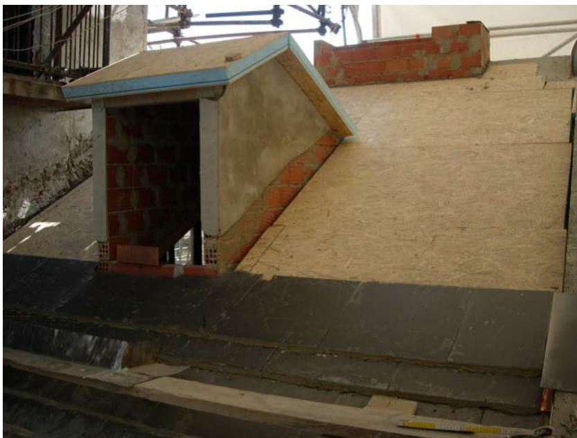
Fig. 117. Pannelli isolanti tipo sandwich in una copertura genovese, resi invisibili dagli abbadini.
