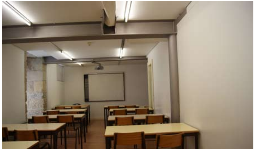
Fig. 7. Vista del solaio della parte adibita a scuola di formazione.
