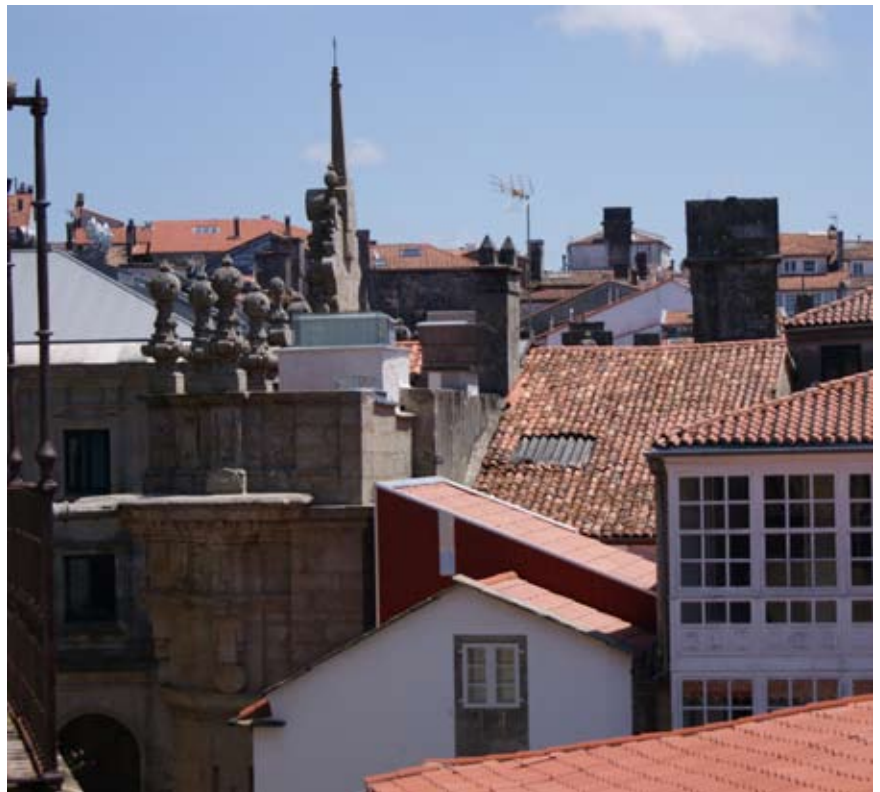
Fig. 11. Vista dei due sistemi di copertura post intervento.
