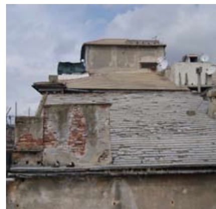
Fig. 13. Rivestimento in abbadini.
