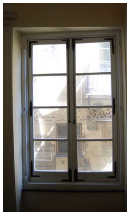
Fig. 14. Infisso genovese interno.
