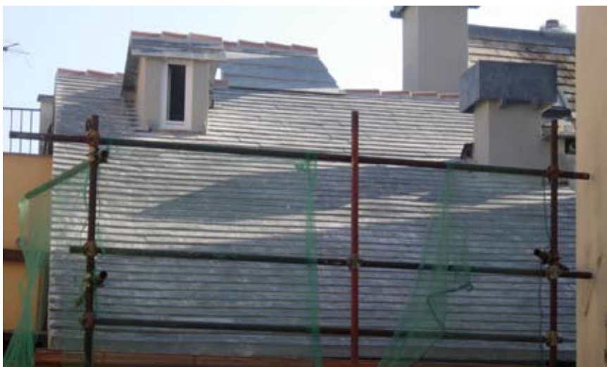
Fig. 10. Vista della copertura dopo l'intervento.
