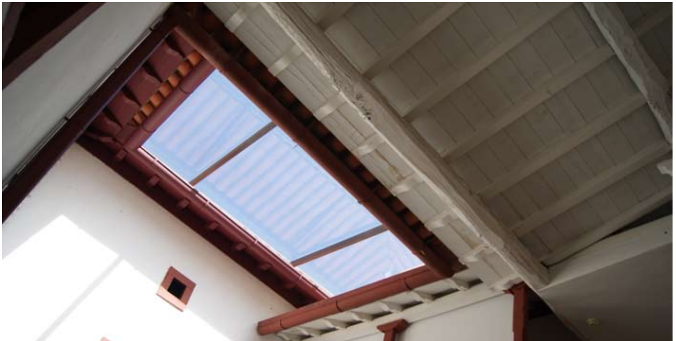
Fig. 10. Vista della copertura dalla corte.
