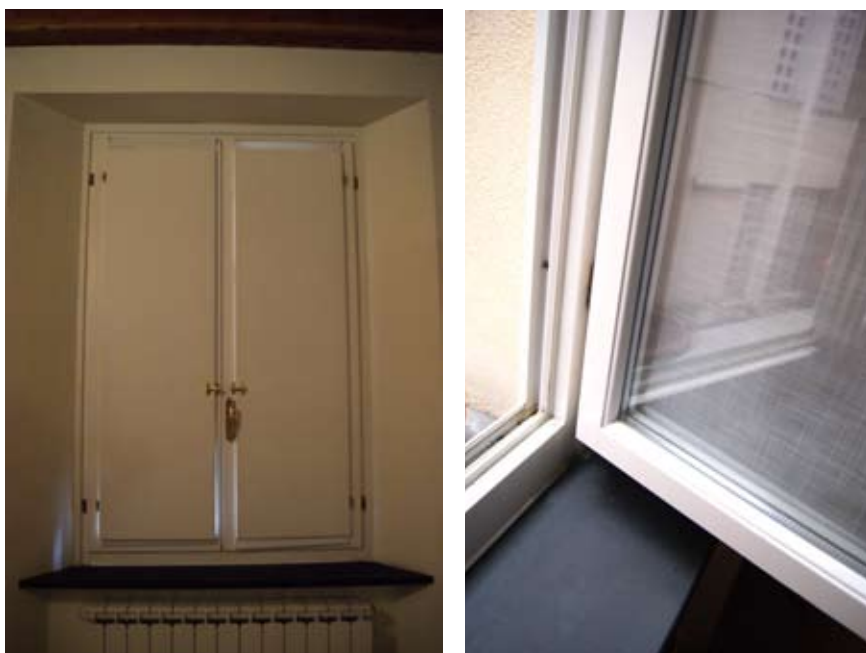
Fig. 16, 17. Vista degli infissi dall'interno post intervento.
