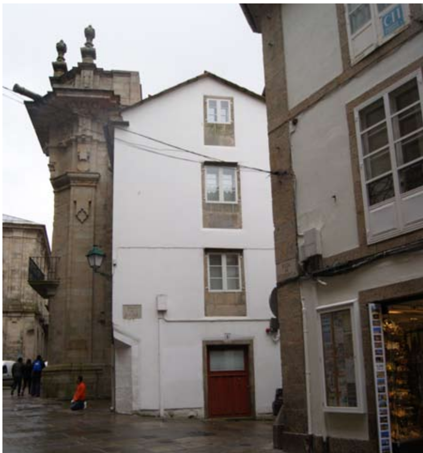
Fig. 3. Vista del fabbricato post intervento.
