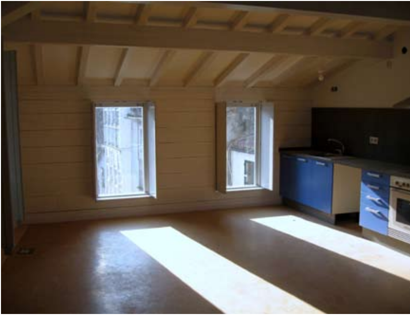
Fig. 100. Interno della copertura della Rua do Medio , n°65.
