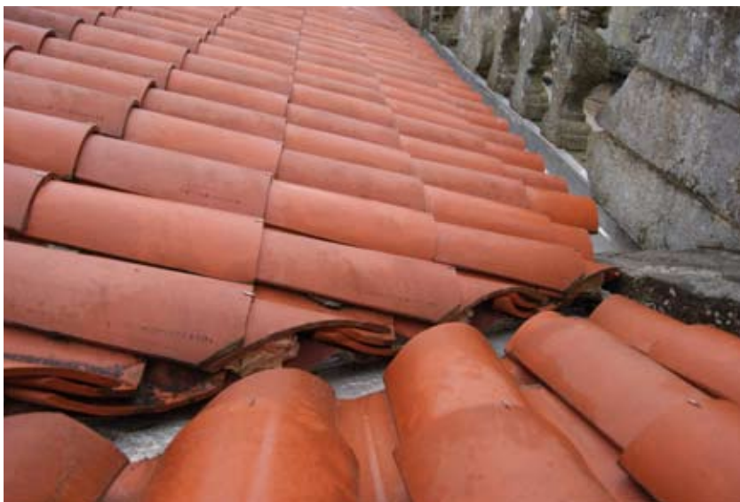
Fig. 98. Rifinitura con adesivo di alluminio nella copertura della Casa del Cabildo .
