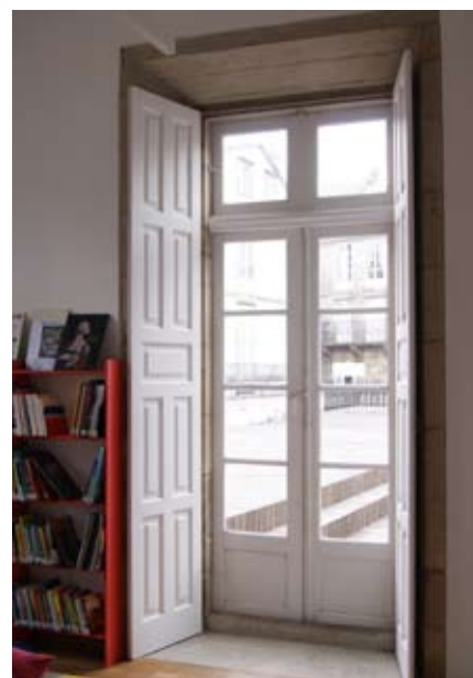
Fig. 84. Interno infisso complanare.
