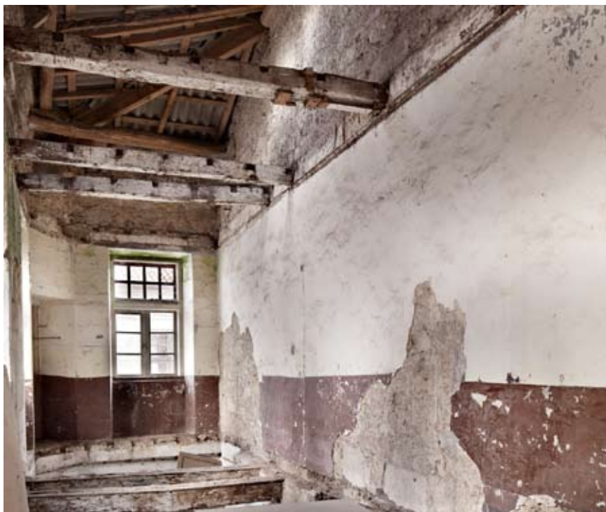
Fig. 10. Vista della copertura prima dell'intervento.
