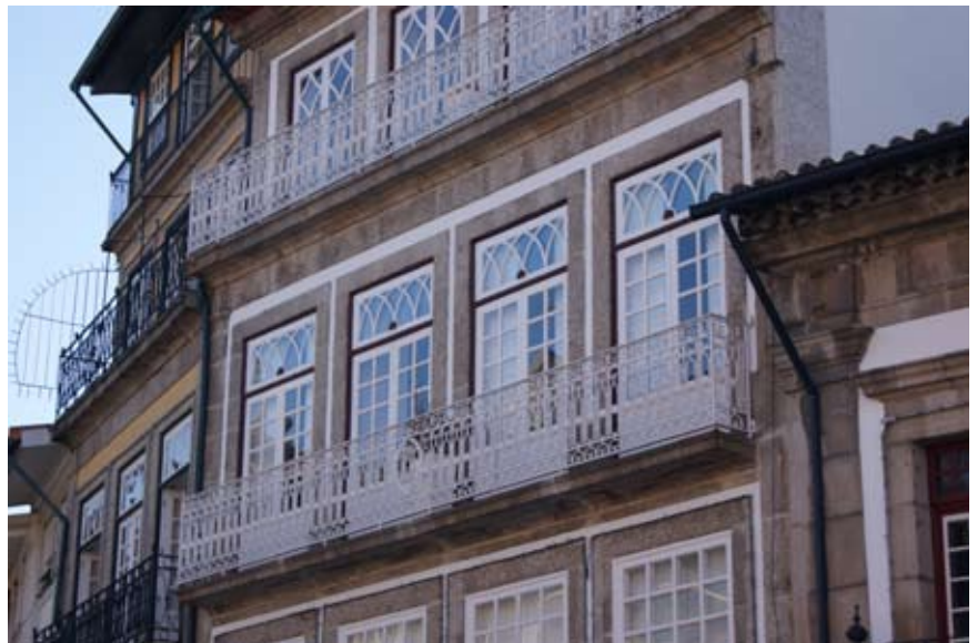
Fig. 17. Vista del prospetto principale dopo l'intervento.
