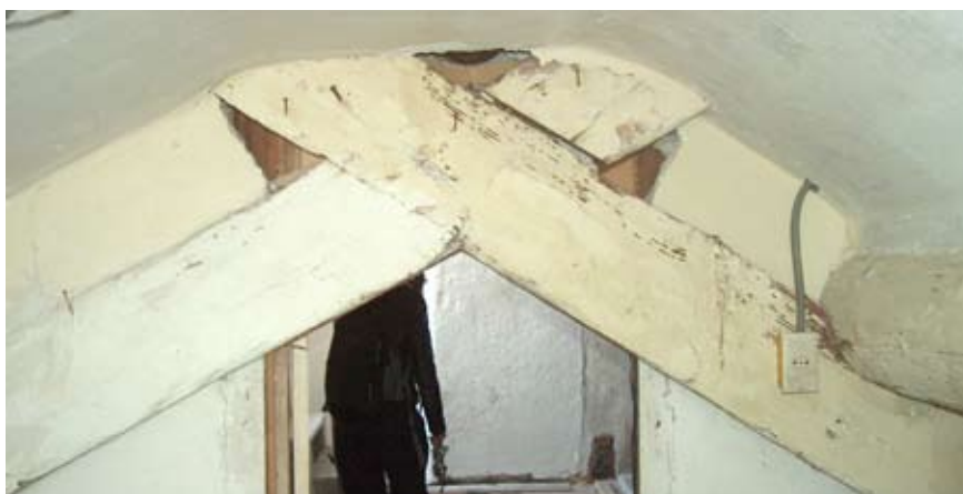
Fig. 9. Particolare del rompitratta.
