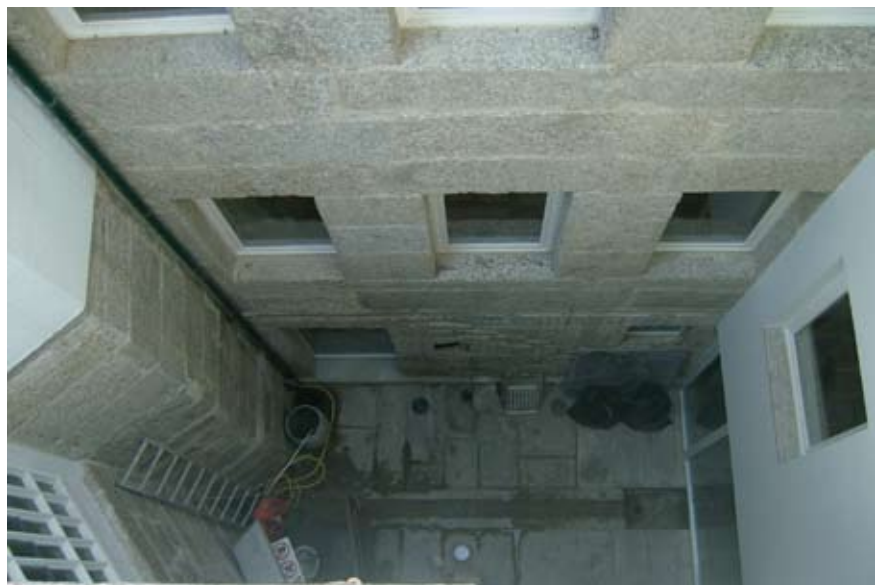
Fig. 16. Vista del prospetto posteriore dopo l'intervento.
