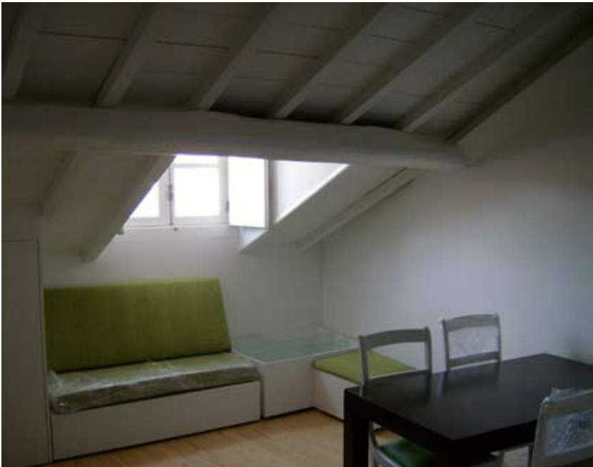
Fig. 64. In basso, elementi nuovi distinguibili nella copertura di Guimarães Studios Lounge .
