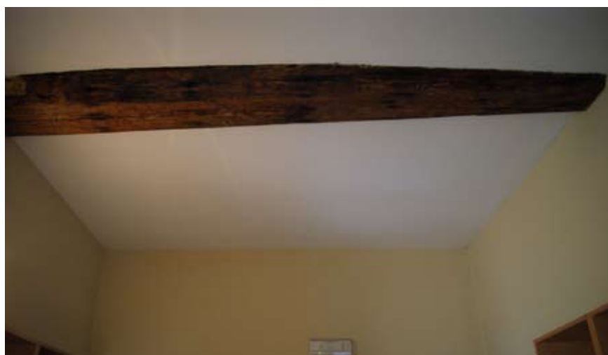
Fig. 7. Solaio recuperato con rifacimento del controsoffitto (Intervento tipo 2).
