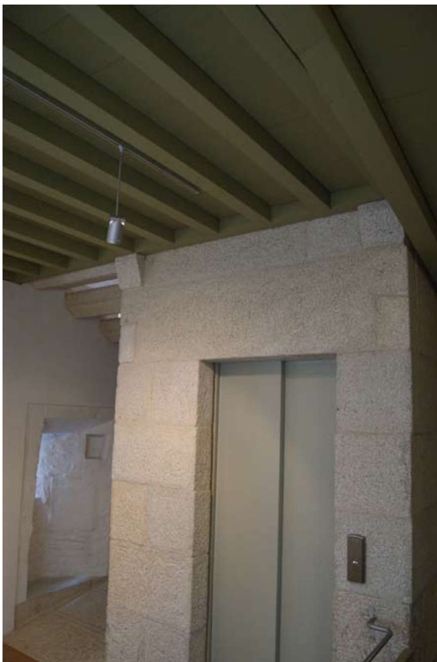
Fig. 5. Vista dell'intradosso del solaio post intervento.
