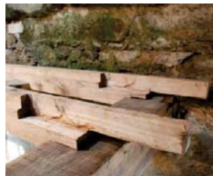
Fig. 90. Travetti dalla sezione innovativa.
