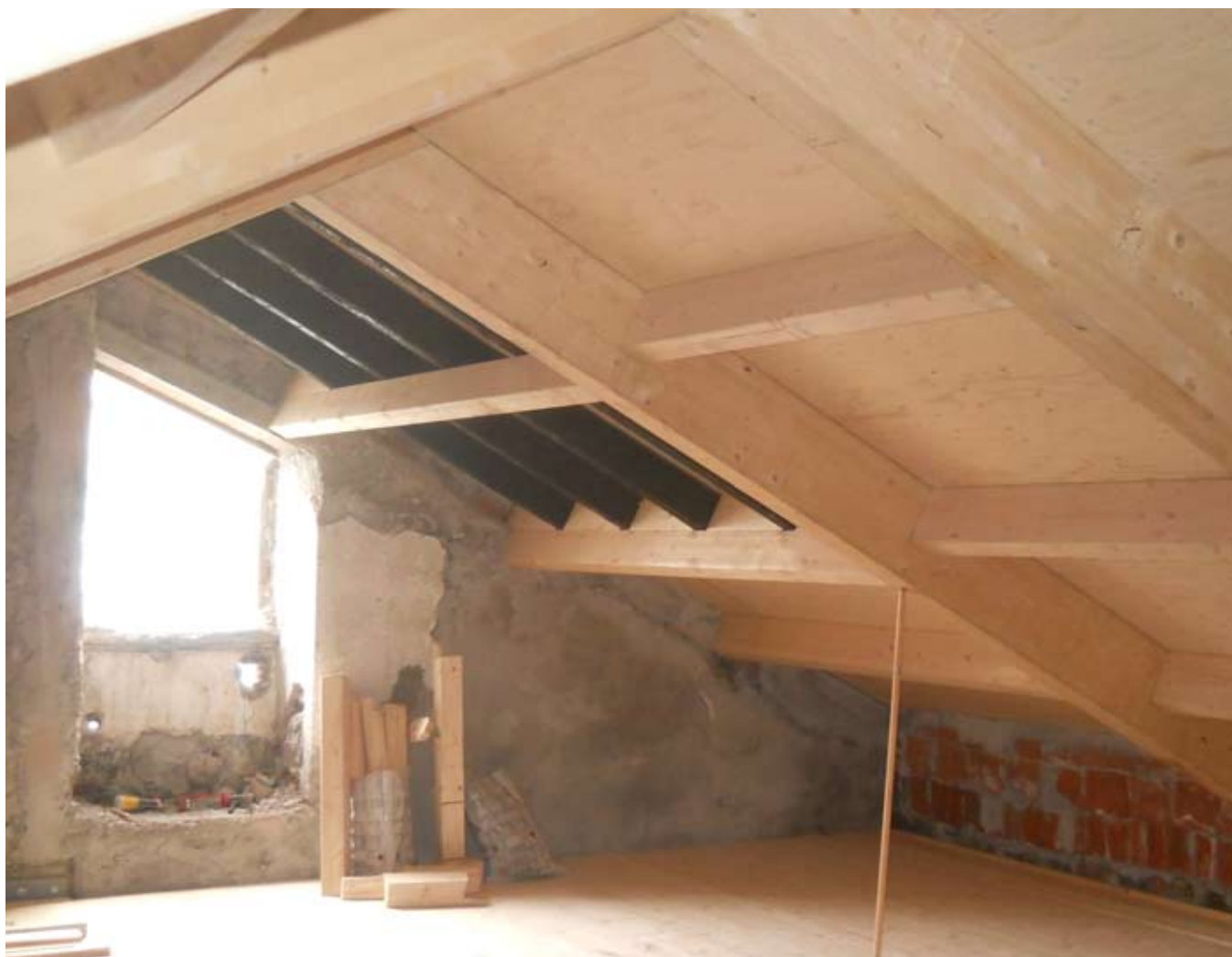
Fig. 25. Copertura edificio di Via S. Bernardo 7 .
