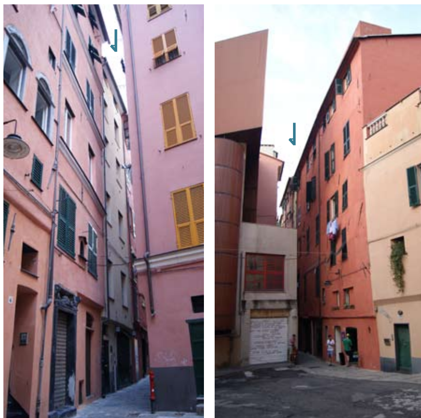
Fig. 3, 4. Vista del fabbricato da vico Santa Fede post intervento.
