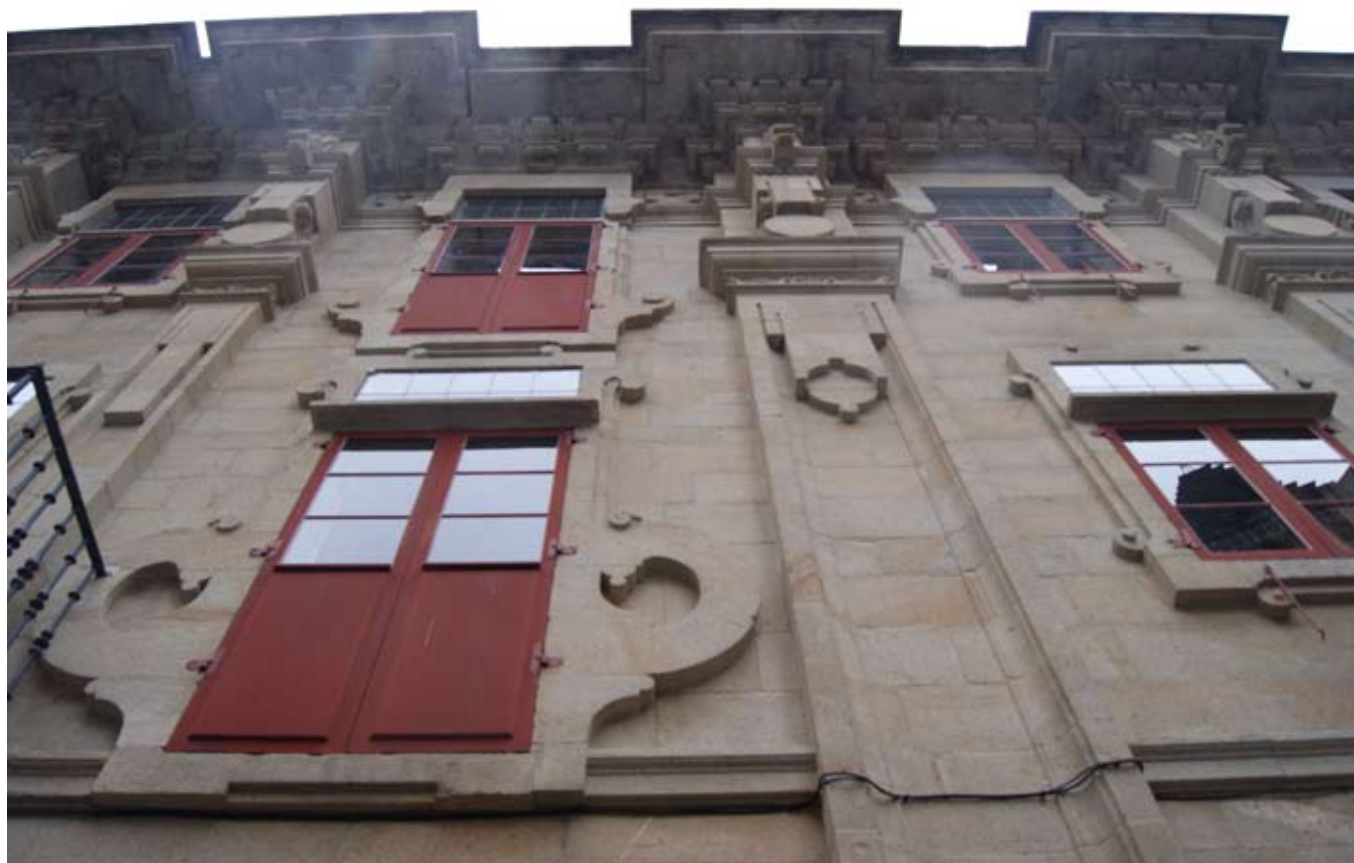
Fig. 4. Particolare del prospetto post intervento.
