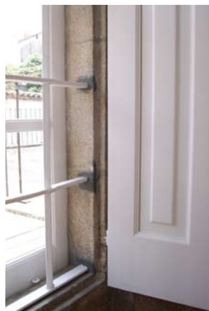
Fig. 86. Giunzione scurino.
