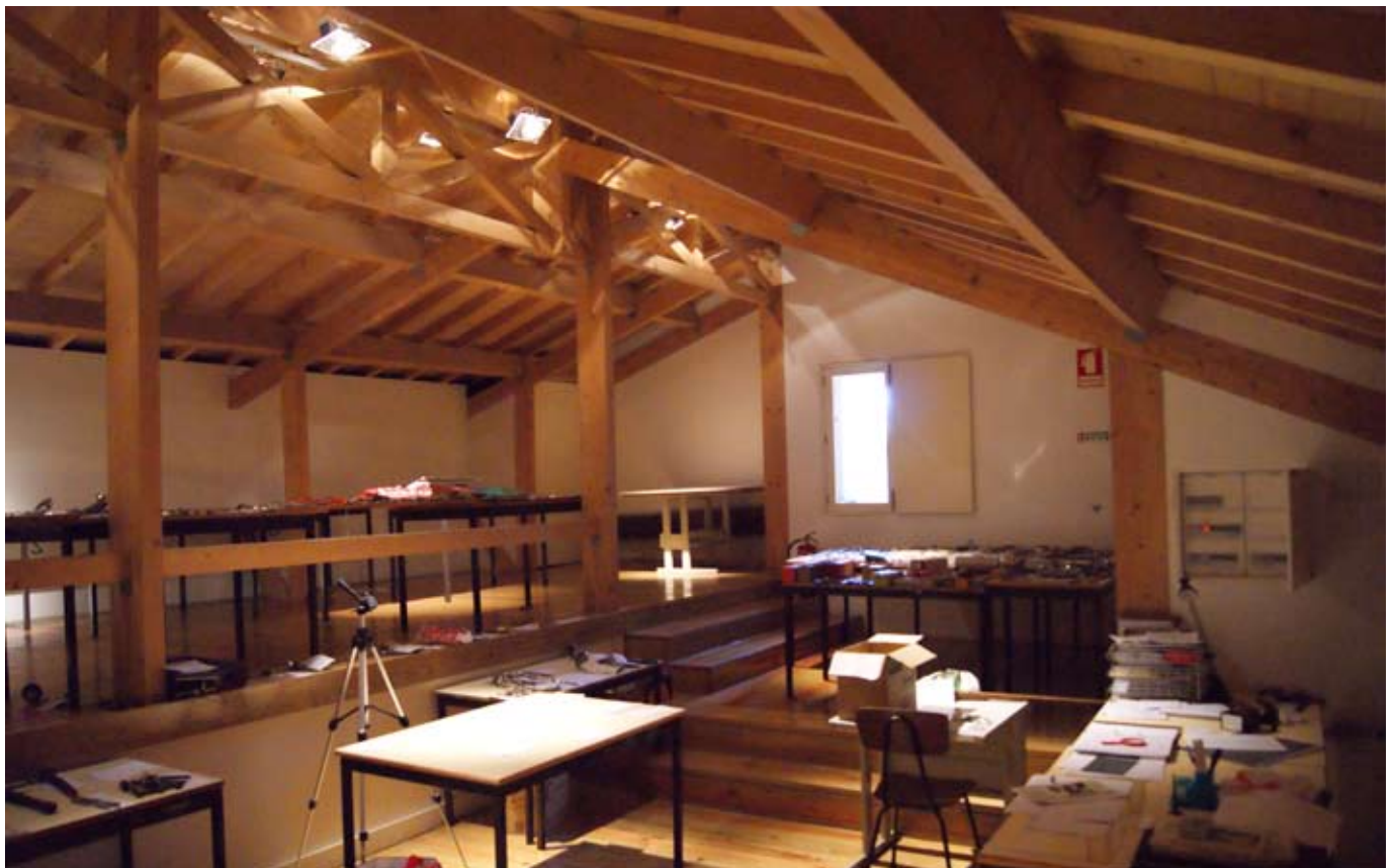
Fig. 11. Vista d'insieme del sottotetto.
