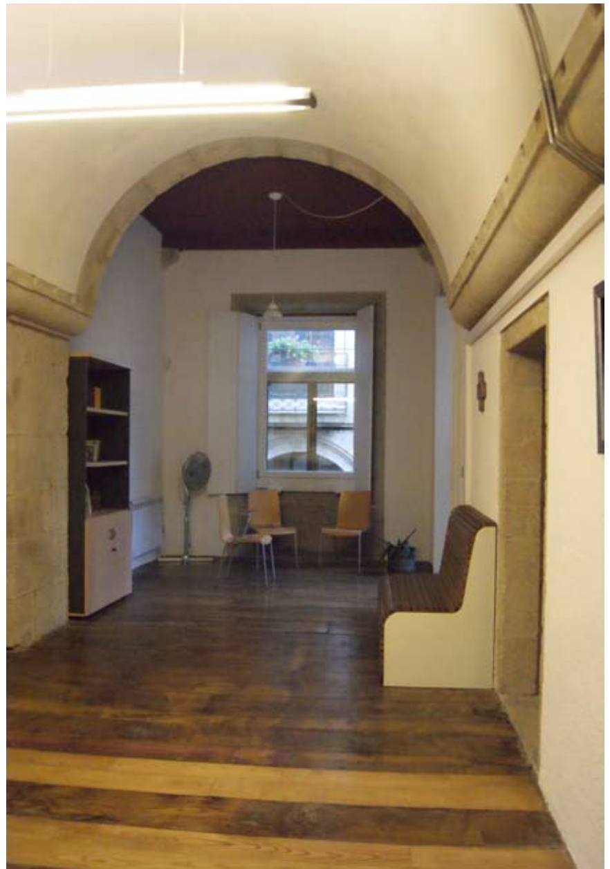
Fig. 7. Particolare del pavimento post intervento con elementi nuovi e recuperati.
