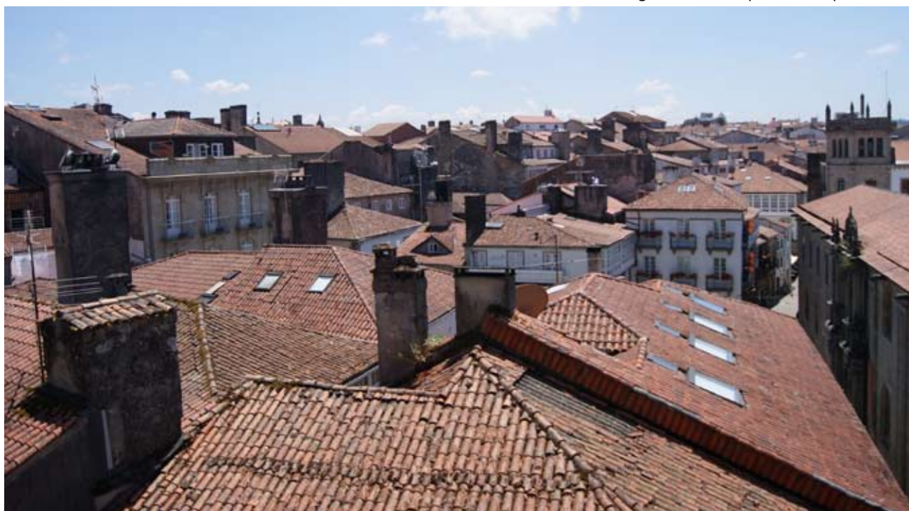
Fig. 83. Veduta coperture compostelane.
