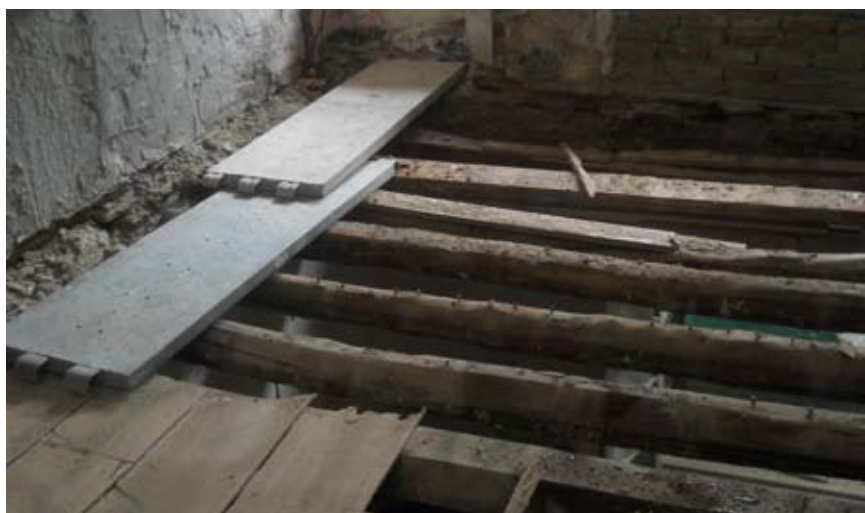
Fig. 6. Solaio in legno prima dell'intervento.
