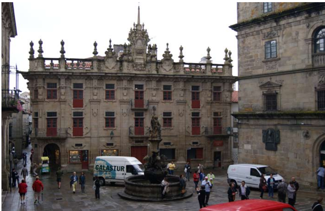
Fig. 3. Vista del fabbricato post intervento.
