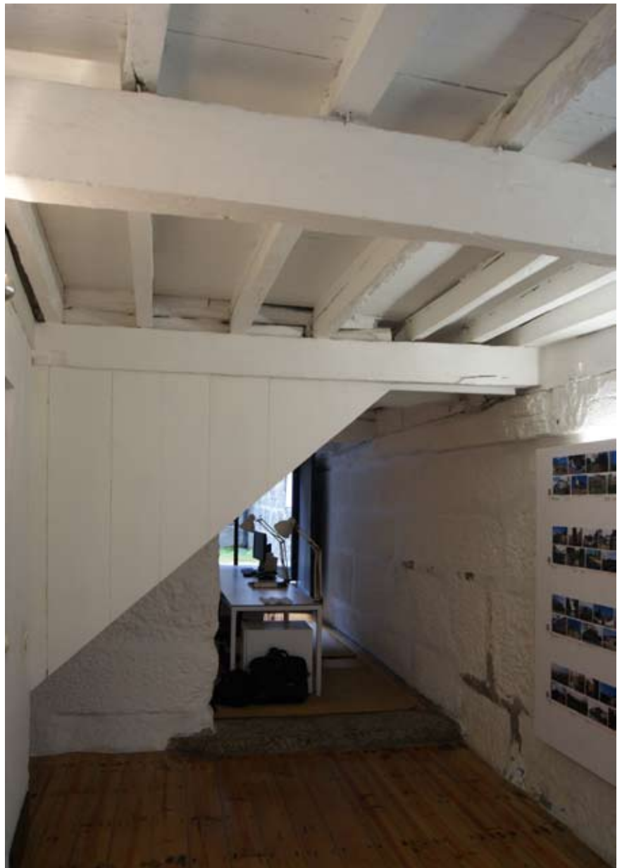
Fig. 6. Solaio del piano terra recuperato (Intervento tipo 1).
