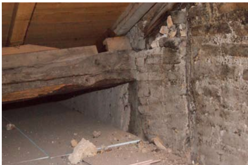
Fig. 59. Componenti conservate della copertura nella Casa Da Rua Nova .
