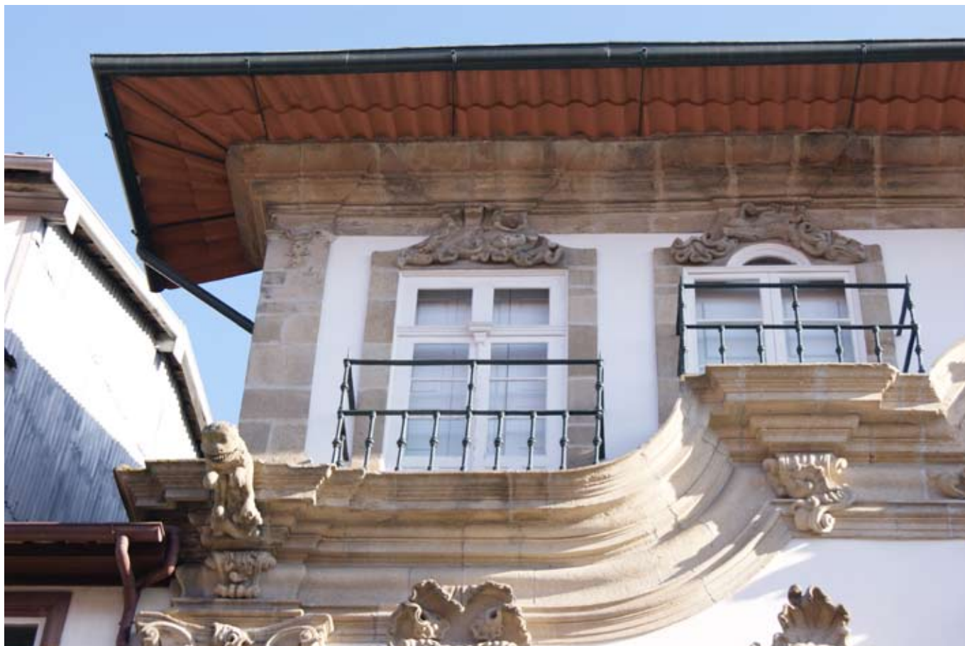
Fig. 14. Particolare degli infissi del prospetto principale.
