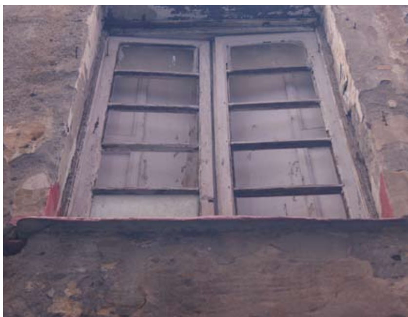
Fig. 14. Infisso genovese interno.
