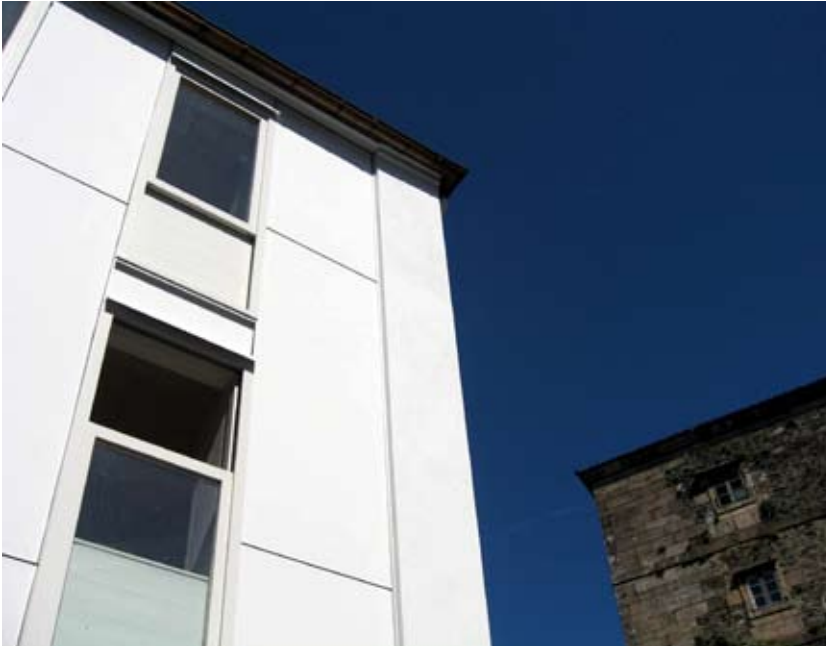
Fig. 107. Serramenti non tradizionali nell'edificio in Rua Do Medio, 65 . Notare come l'infisso aperto funga ancha da parapetto.
