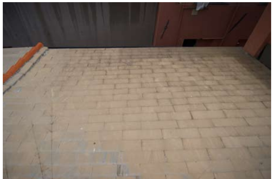
Fig. 14. Particolare degli abbadini post intervento.
