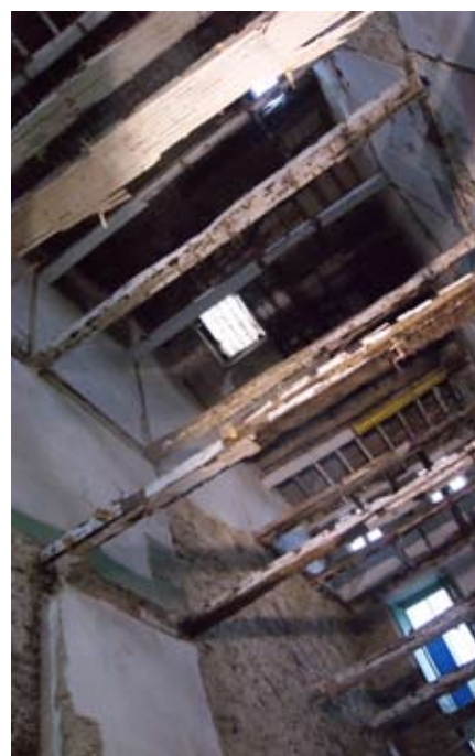
Fig. 79. Orditura principale di un solaio tradizionale.
