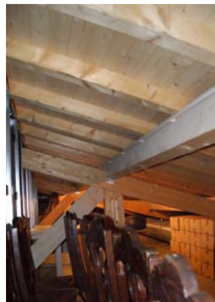
Figg. 60,61. Nuova copertura nella Casa Dos Lobos Machado .
