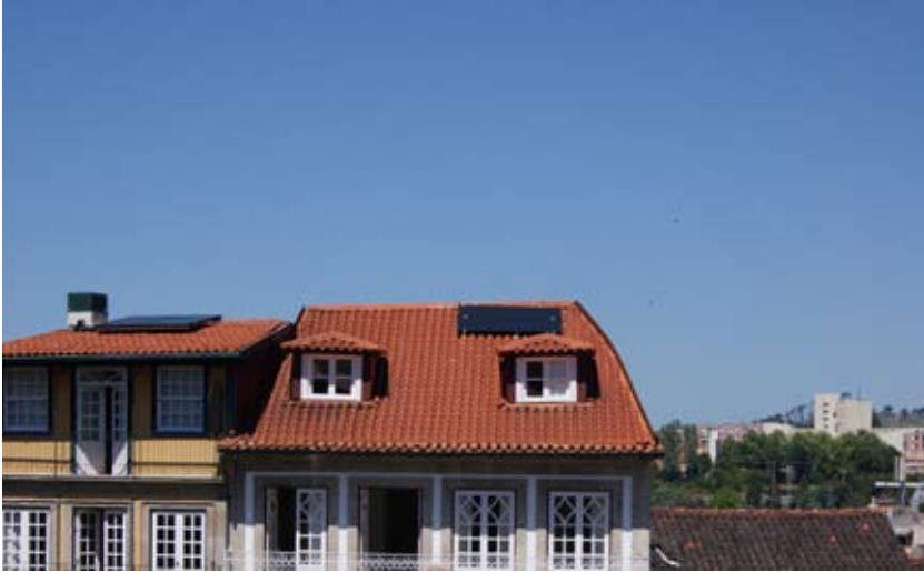
Figg. 62, 63. Guimaraes Studios Lounge , esterno ed interno della copertura.
