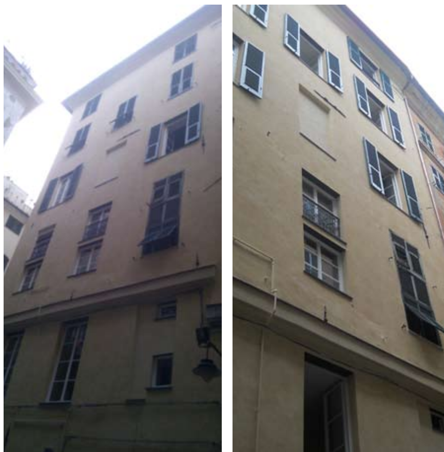
Figg. 3, 4. Vista del fabbricato da via San Bernardo post intervento.
