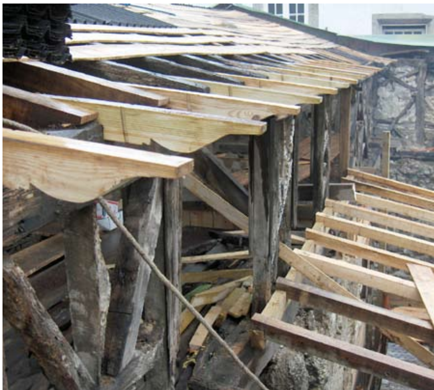
Fig. 7. Vista della copertura durante l'intervento.
