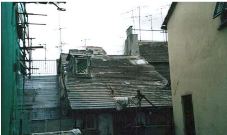
Fig. 9. Vista della copertura prima dell'intervento.
