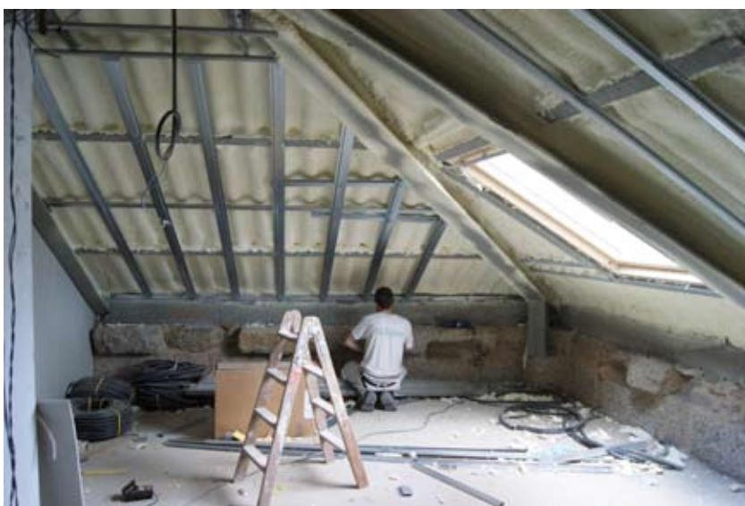
Fig. 97. Un caso di copertura ricostruita in acciaio.
