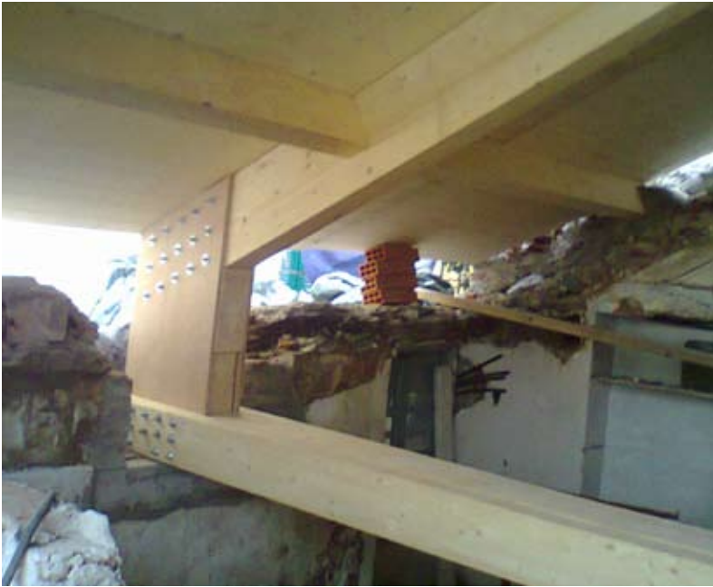
Fig. 26. Attacco capriata - muratura nella copertura di Via S. Bernardo 7 .
