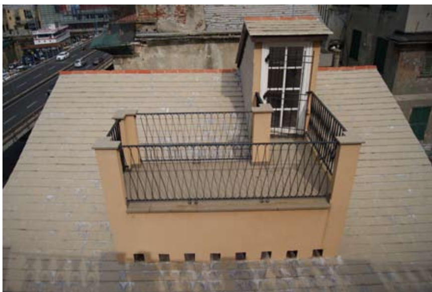
Fig. 12. Vista della copertura dall'esterno dopo intervento.
