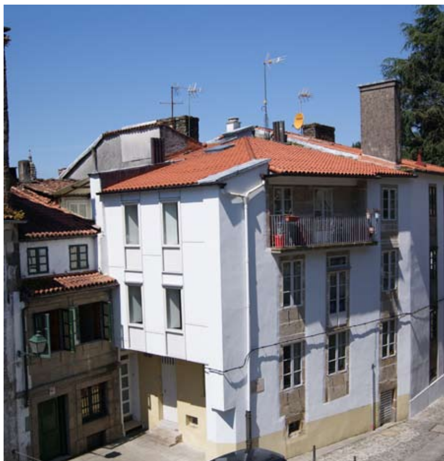
Fig. 3. Vista del fabbricato post intervento.
