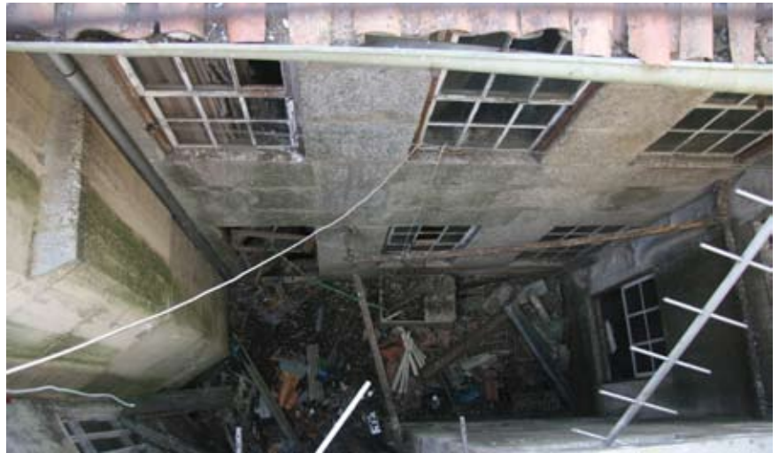
Fig. 15. Vista del prospetto posteriore prima dell'intervento.
