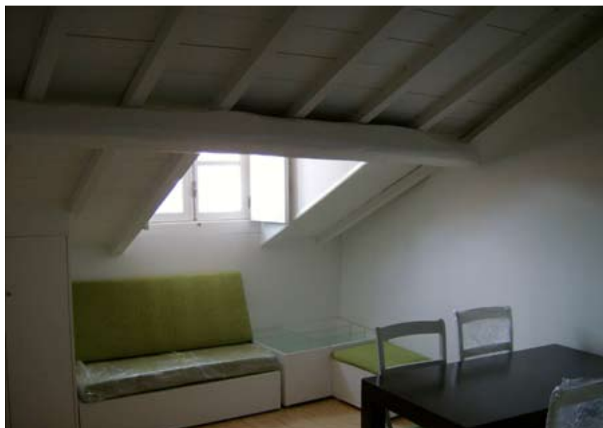
Fig. 12. Vista intradosso di copertura dopo l'intervento.
