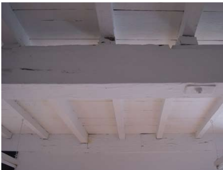
Fig. 9, 10. Particolari dei solai post intervento.
