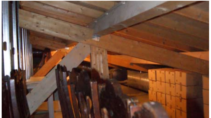
Fig. 10. Particolare del nodo trave - puntone della copertura.
