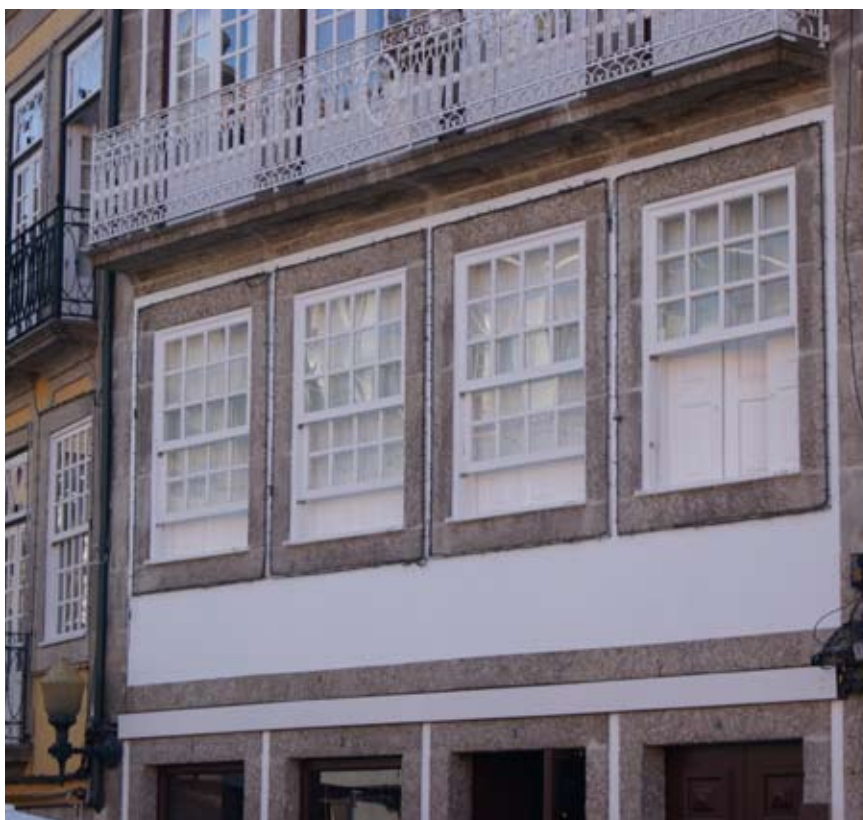
Fig. 18. Particolare degli infissi del prospetto principale dopo l'intervento.
