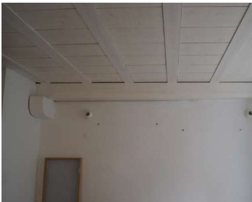
Fig. 5. Vista dell'intradosso del solaio post intervento.
