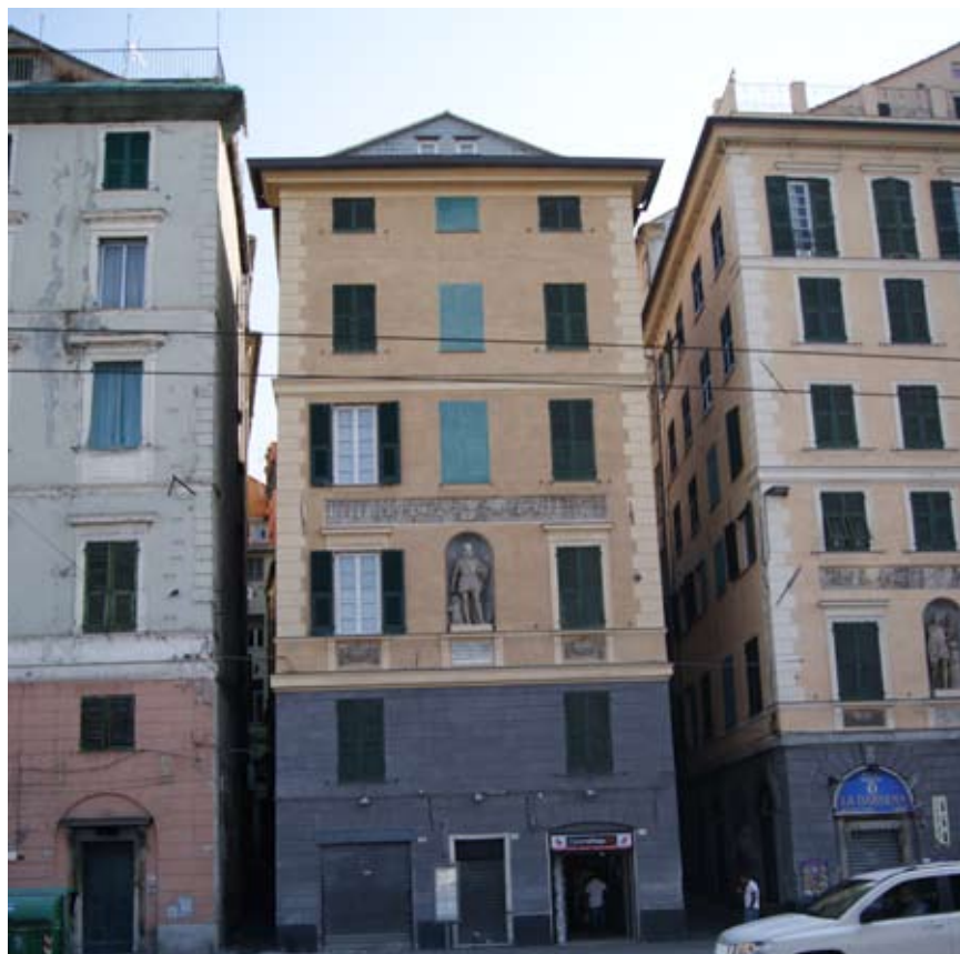
Fig. 3. Vista del fabbricato da via Gramsci intervento.
