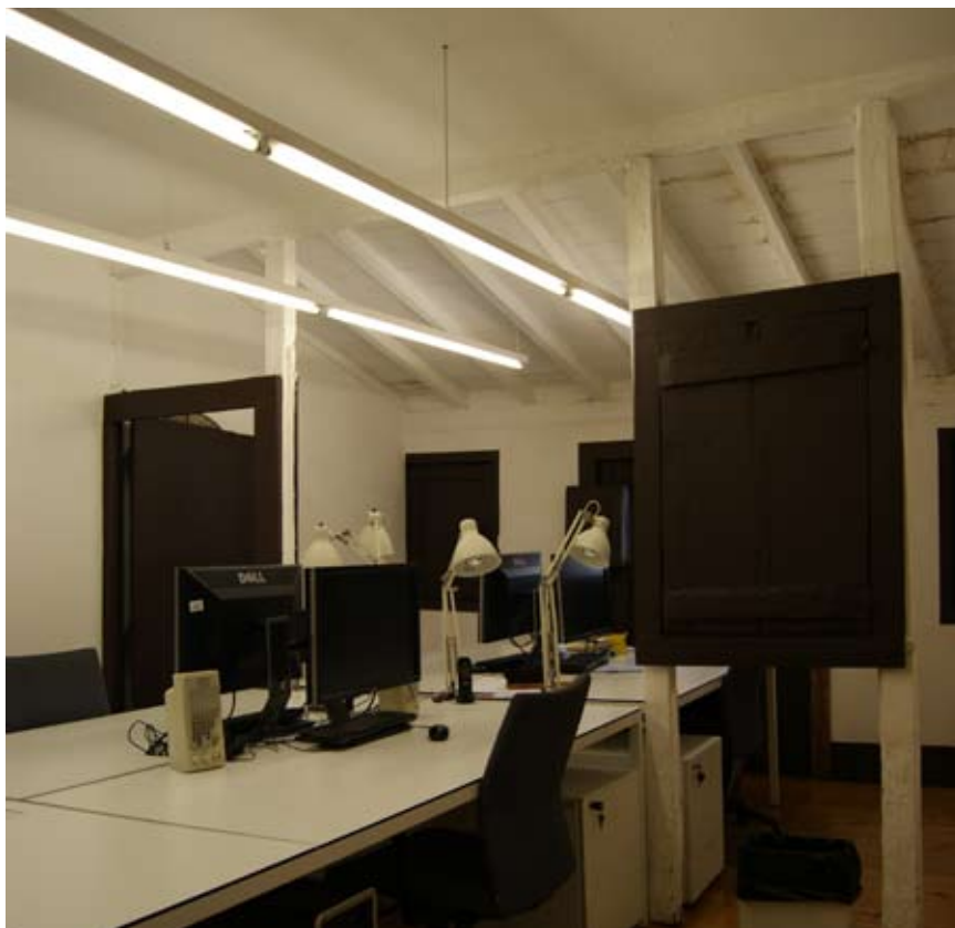
Fig. 11. Vista di una porzione dell'intradosso di copertura.
