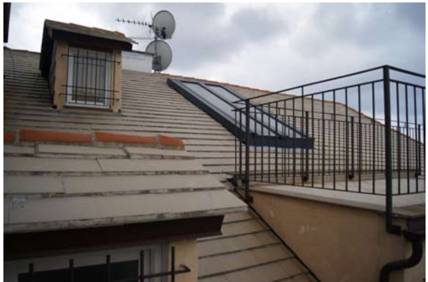
Fig. 14. Particolare degli abbadini.
