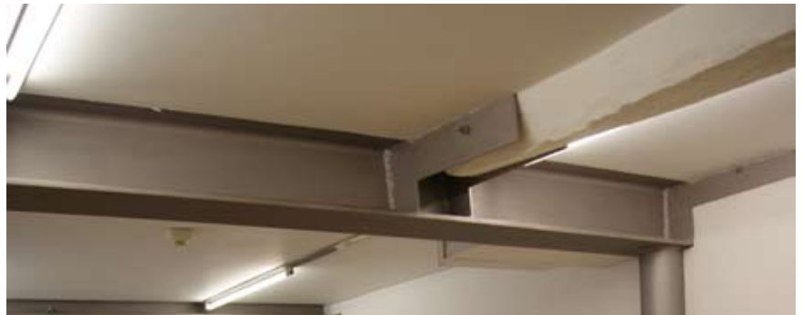
Fig. 8. Particolari del sistema di rinforzo del solaio.
