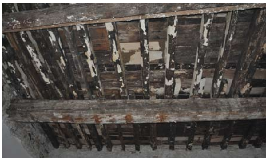
Fig. 5. Solaio in legno prima dell'intervento.
