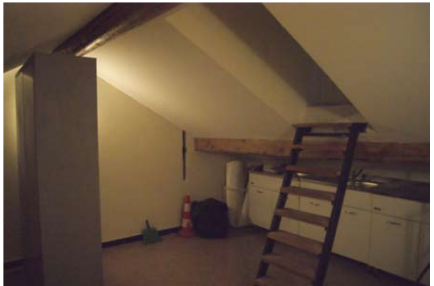
Fig. 12. Vista interna della copertura post intervento.
