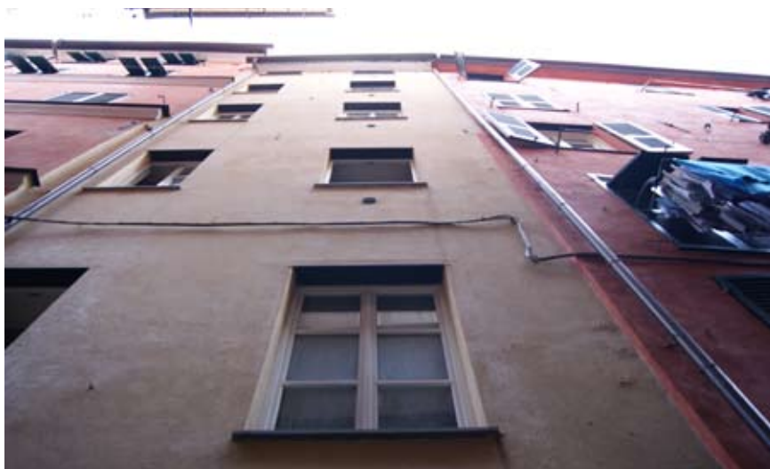
Fig. 15. Vista degli infissi dall'esterno post intervento.
