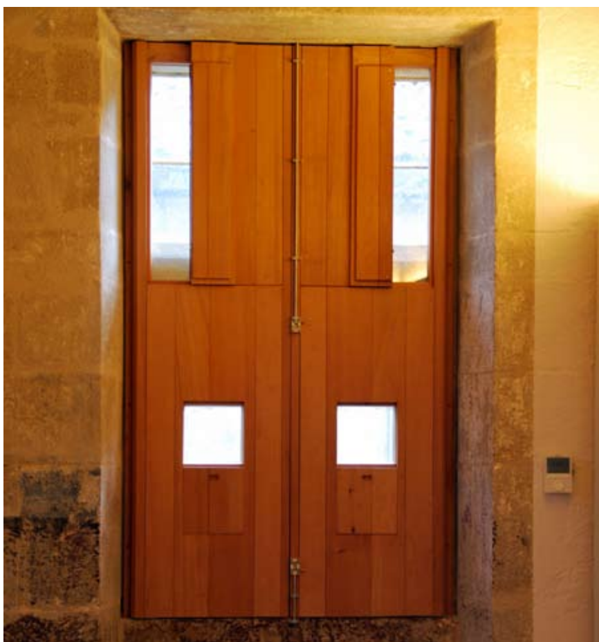
Figg. 14, 15. Serramento secondario appartenente agli infissi di tipo 1.
