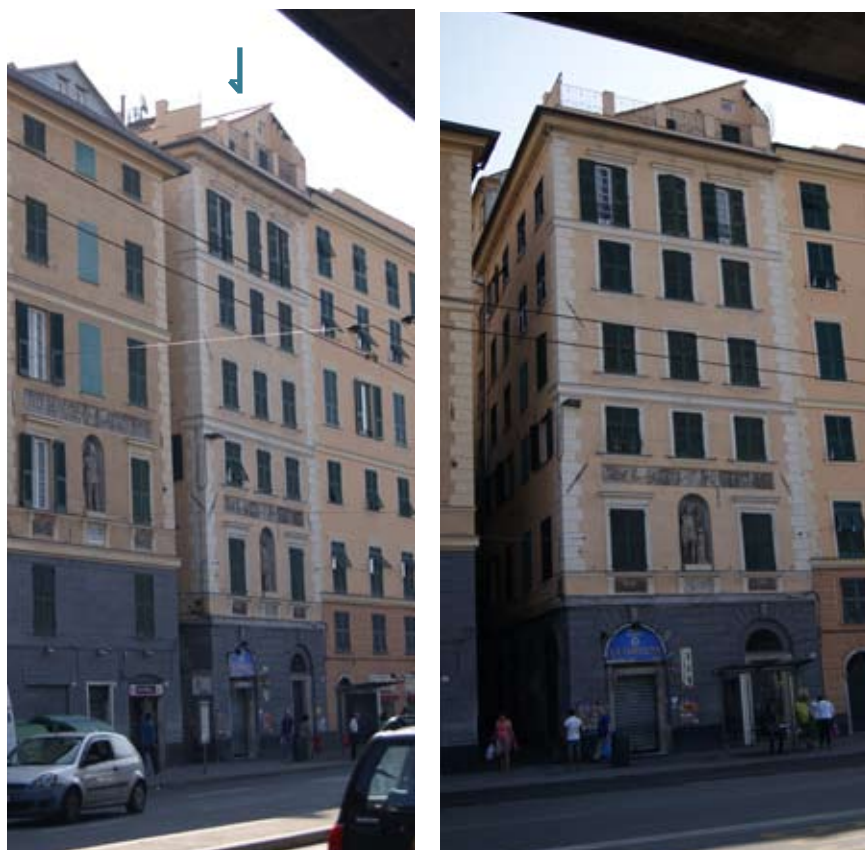
Fig. 3, 4. Vista del fabbricato da via Gramsci.
