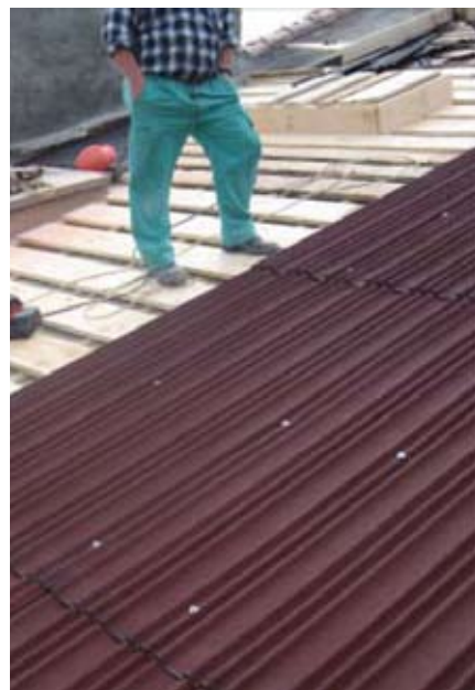
Fig. 118. Installazione lastre bitumate a Santiago de Compostela, caso studio Rua do Medio 65 .
