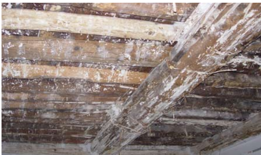
Fig. 6. Solaio in legno prima dell'intervento.
