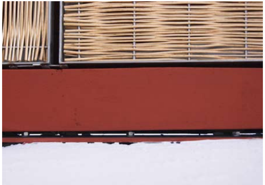
Fig. 9. Particolare del controsoffitto.
