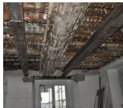
Fig. 16. Putrelle in ausilio di una trave di origine navale riciclata.
