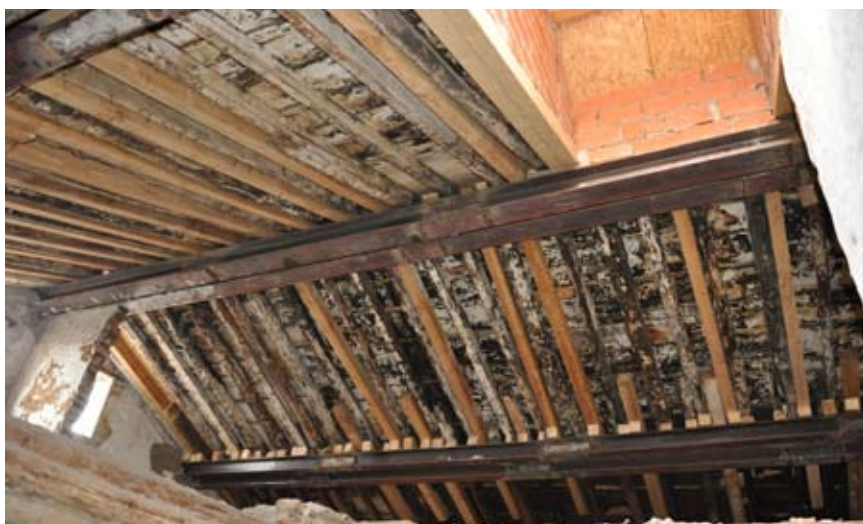
Fig. 9. Vista della copertura durante l'intervento.
