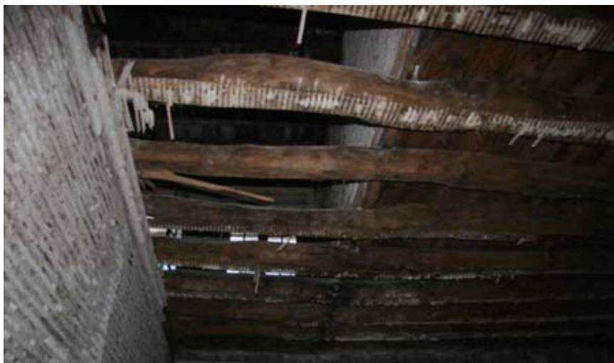
Fig. 6. Solaio prima dell'intervento.
