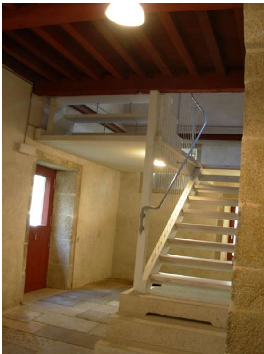
Fig. 5. Vista dell'intradosso del solaio post intervento.
