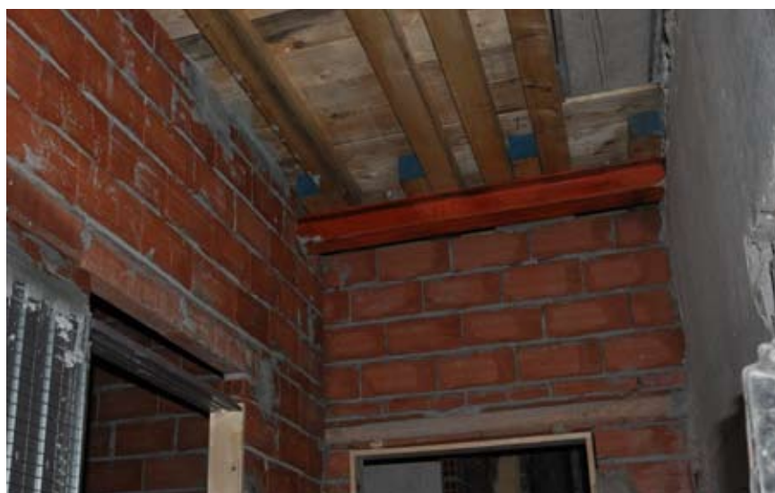
Fig. 6. Solaio durante il consolidamento (Intervento tipo 1).
