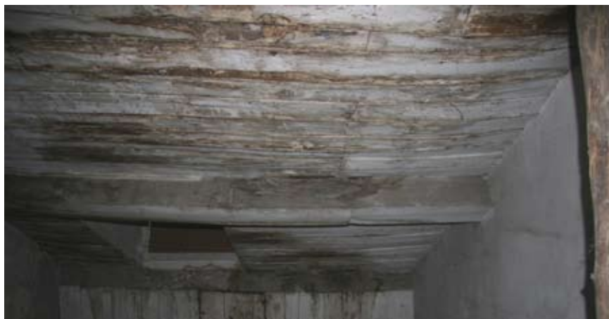
Fig. 11. Vista intradosso di copertura prima dell'intervento.
