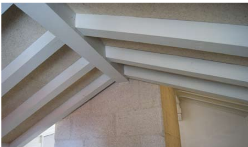
Fig. 9. Particolare del sottotetto post intervento.
