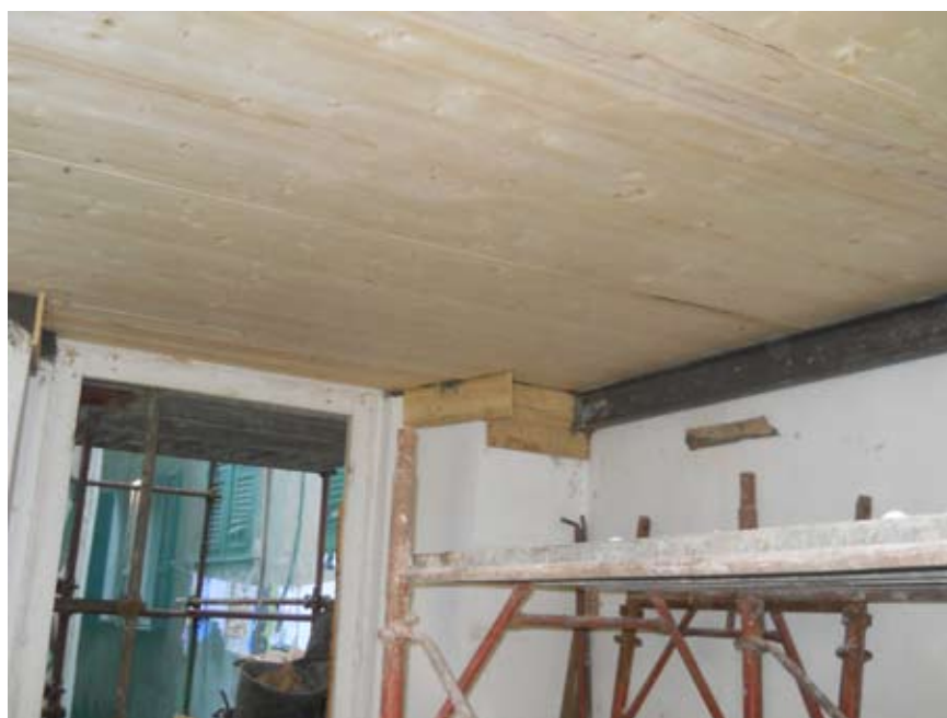
Fig. 7. Solaio durante l'intervento (Intervento tipo 3).
