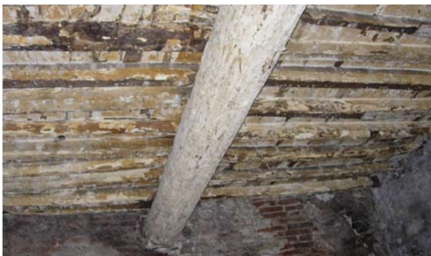
Fig. 6. Solaio in legno prima dell'intervento.
