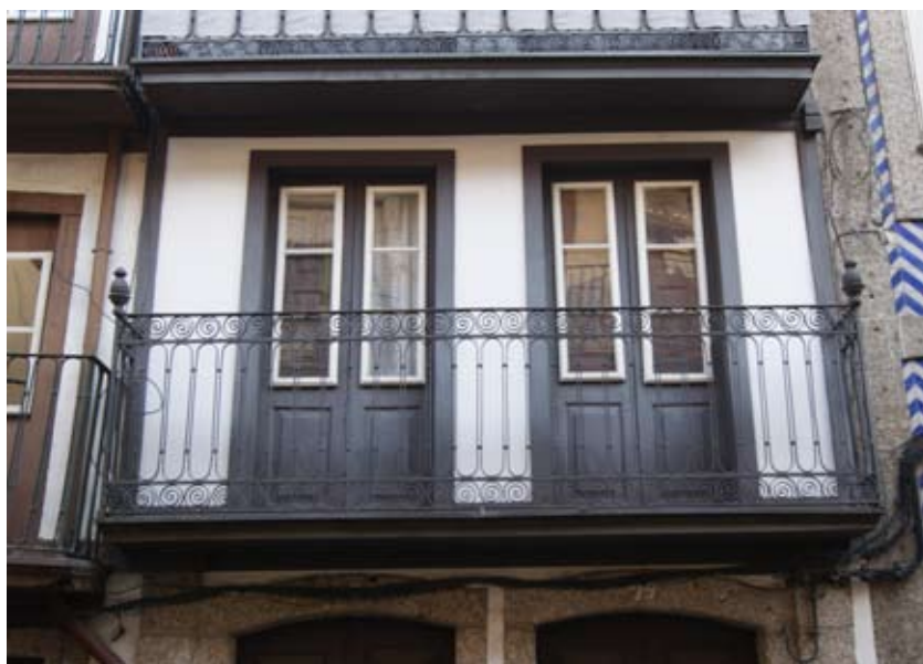
Fig. 66. Infissi nuovi installati in seguito ad intervento di recupero.
