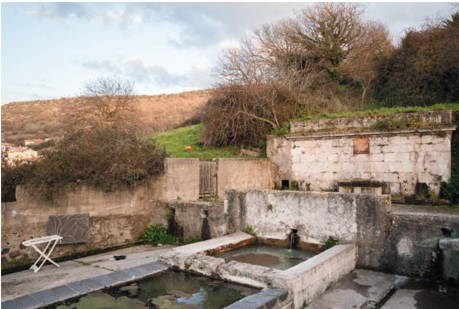
10. Fontana e lavatoio a Bonorva, ancora saltuariamente in uso da parte degli abitanti del vicinato. (foto Stefano Ferrando).
