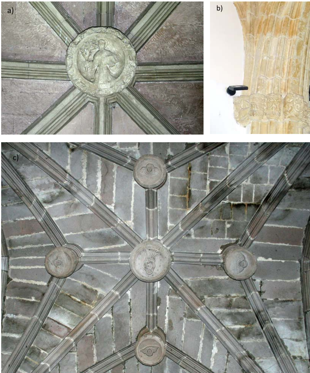
Fig.16 - Dettagli degli elementi lavorati che compongono una volta a crociera nervata: a) Busachi, chiesa di Sant'Antonio (XVI secolo), chiave di volta principale; b) Suelli chiesa di San Giorgio (XVI secolo), peduccio e capitello lavorato da cui si dipartono i conci modanati delle nervature della volta e dell'arco di accesso alla capilla mayor; c) Ula Tirso, chiesa di Sant'Andrea (XVII secolo) complesso delle gemme di chiave.
