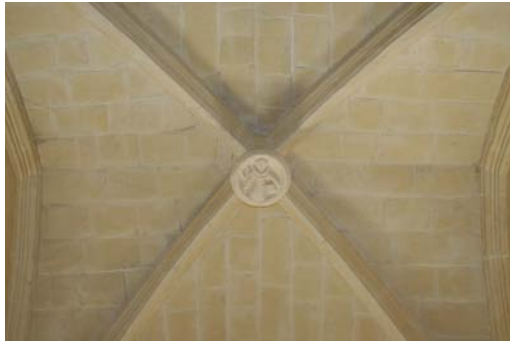
Fig.7 - Differenze nell'apparecchio della volta: a sinistra disposizione regolare dei conci a Sestu, San Giorgio (XVI secolo), cappella laterale; a destra disposizione irregolare dei conci a Elmas, San Sebastiano, (XVI secolo) cappella laterale.
