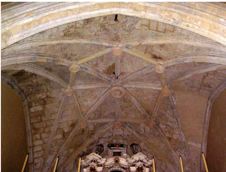
Fig.12 - Crociera stellare gruppo 2: a sinistra il caso reale, Cagliari, San Giacomo (XV secolo) volta della capilla mayor; a destra schema volumetrico del caso teorico.
