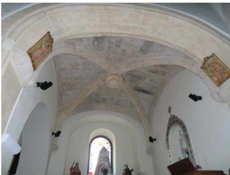
Fig.9 - Crociera semplice gruppo 2: a sinistra schema volumetrico del caso teorico; a destra esempio reale Ortacesus, San Pietro (XVI secolo) cappella laterale.
