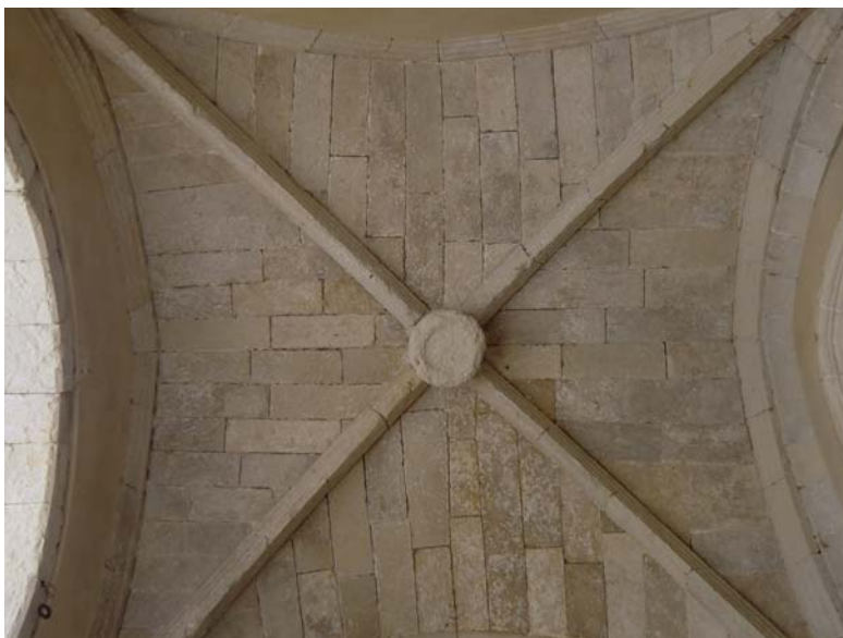
Fig.8 - Crociera semplice gruppo 1: a sinistra esempio reale Isili, San Saturnino, (XV secolo) volta del portico d'accesso alla chiesa; a destra schema volumetrico del caso teorico.
