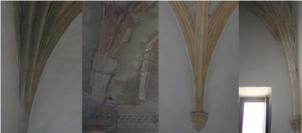
Fig.5 - Diverso trattamento dei conci d'avvio delle nervature, da sinistra a destra vulcanite (Busachi, Sant'Antonio e San Domenico), calcare di Cagliari (Assemini, San Pietro e Decimomannu, Sant'Antonio)
