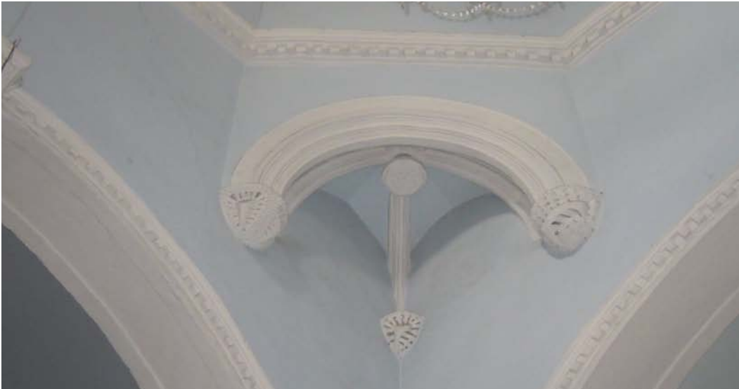
Fig.17 - Senorbì, santa Barbara (XVII secolo) volte di raccordo della cupola ottagonale.
