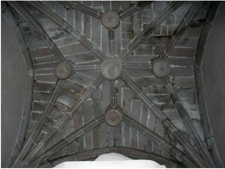
Fig.11 - Crociera stellare gruppo1: a sinistra esempio reale Ula Tirso, Sant'Andrea (XVII secolo) volta del presbiterio; a destra schema volumetrico del caso teorico nel caso la traccia della pendenza sia rettilinea.
