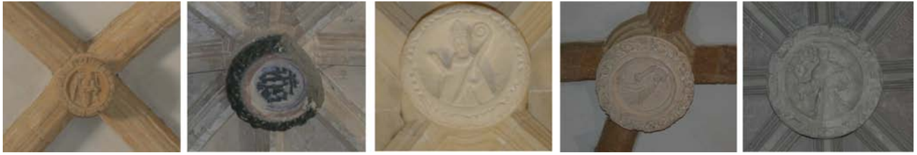
Fig.6 - Varianti della lavorazione delle chiavi di volta dei presbiteri. Da sinistra a destra: Assemini, Decimomannu, Sestu, Furtei, Busachi.
