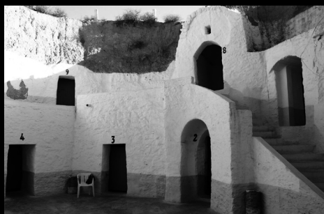
Particolare del prospetto sul patio. La stratificazione dello spazio tra casa e corte
