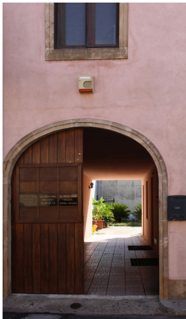
la transizione tra strada e corte retrostante
