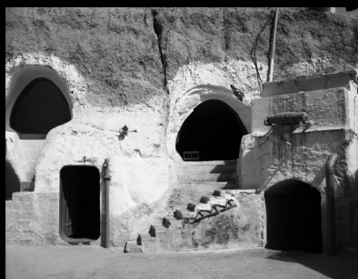
Particolare del prospetto sul patio. Le soglie e il sistema delle scale
