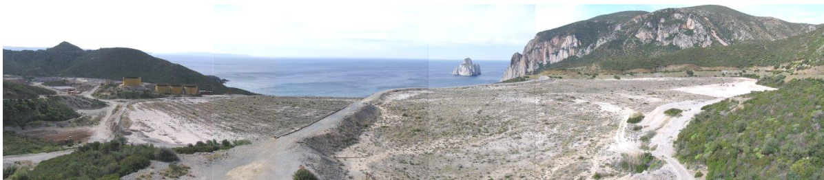
Figura 4.2: Bacini di decantazione di Masua.
