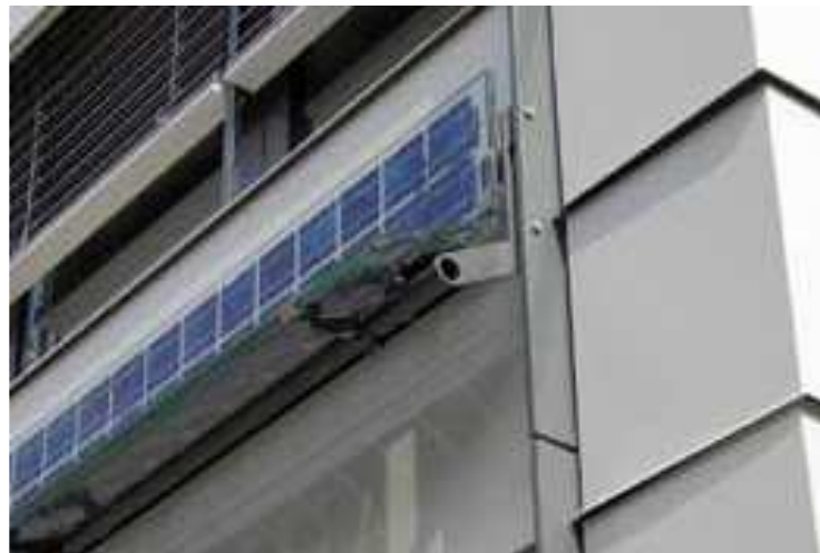
Vista delle pensiline FV nel dettaglio costruttivo (a sinistra) e nella foto (in alto)
