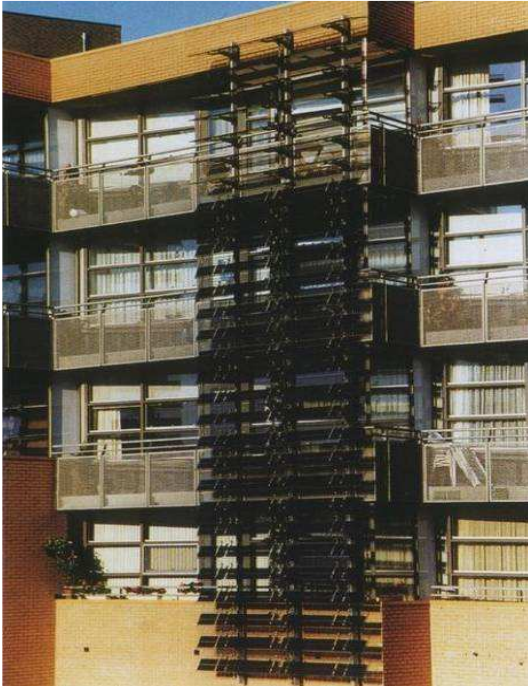
Intervento retrofit in Olanda Brise soleil fotovoltaici in facciata
