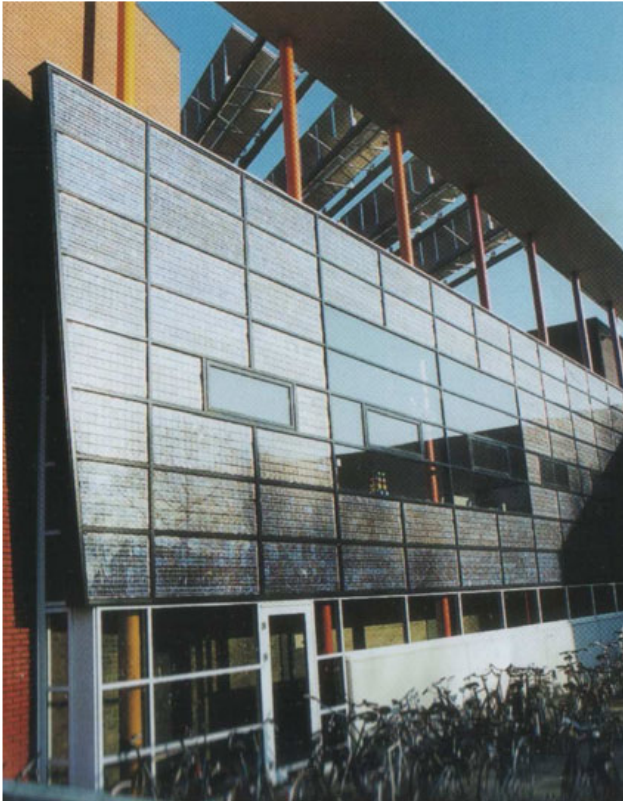
Vista del curtain wall sulla facciata sud
