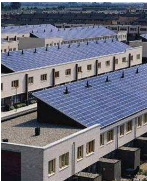
Integrazione in copertura Complesso residenziale, Amersfort
