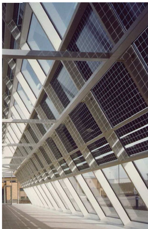
Vista dall'interno al piano terra
