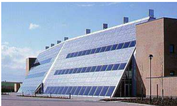
Vista laterale della facciata fotovoltaica
