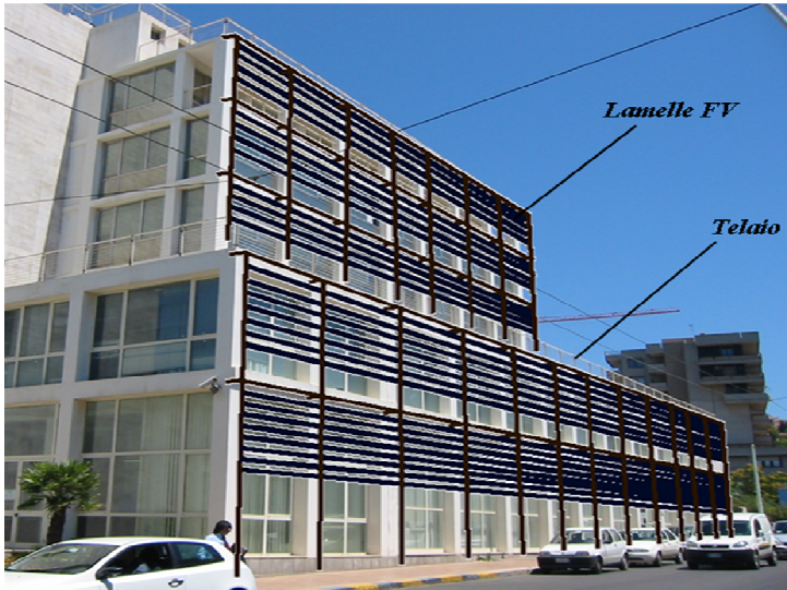
Integrazione retrofit con telaio a vista
