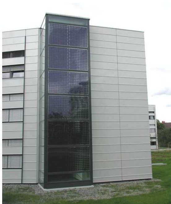
Vista della facciata PV sulla facciata sud
