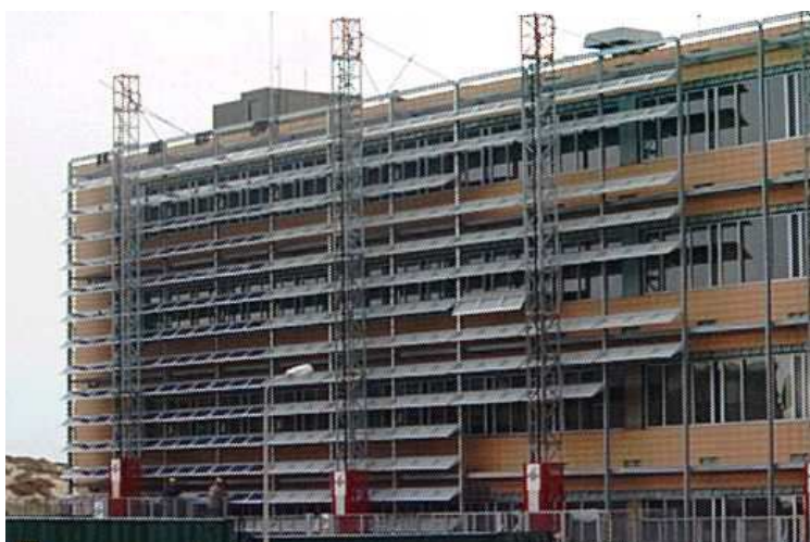
Montaggio del sistema fotovoltaico a lamelle in facciata
