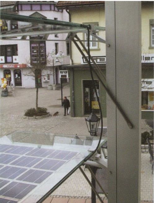
Dettagli del sistema frangisole
