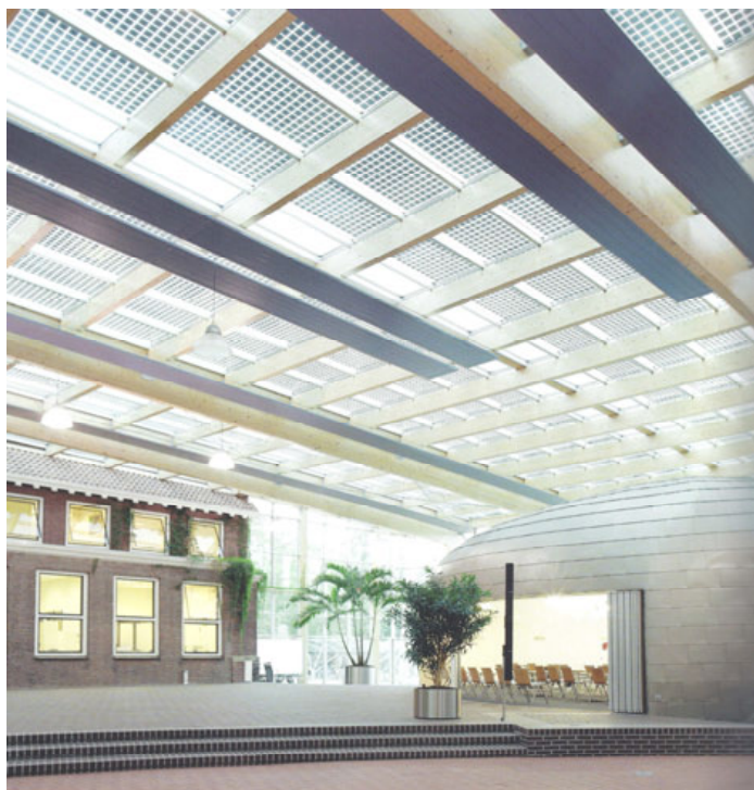
Edificio comunale a Dongen, Paesi Bassi
