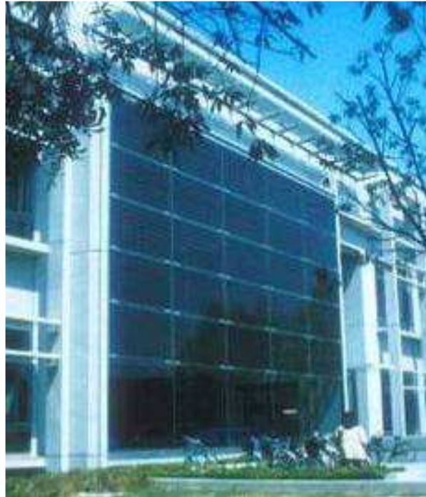
Intervento BIPV in Giappone Facciata vetrata fotovoltaica
