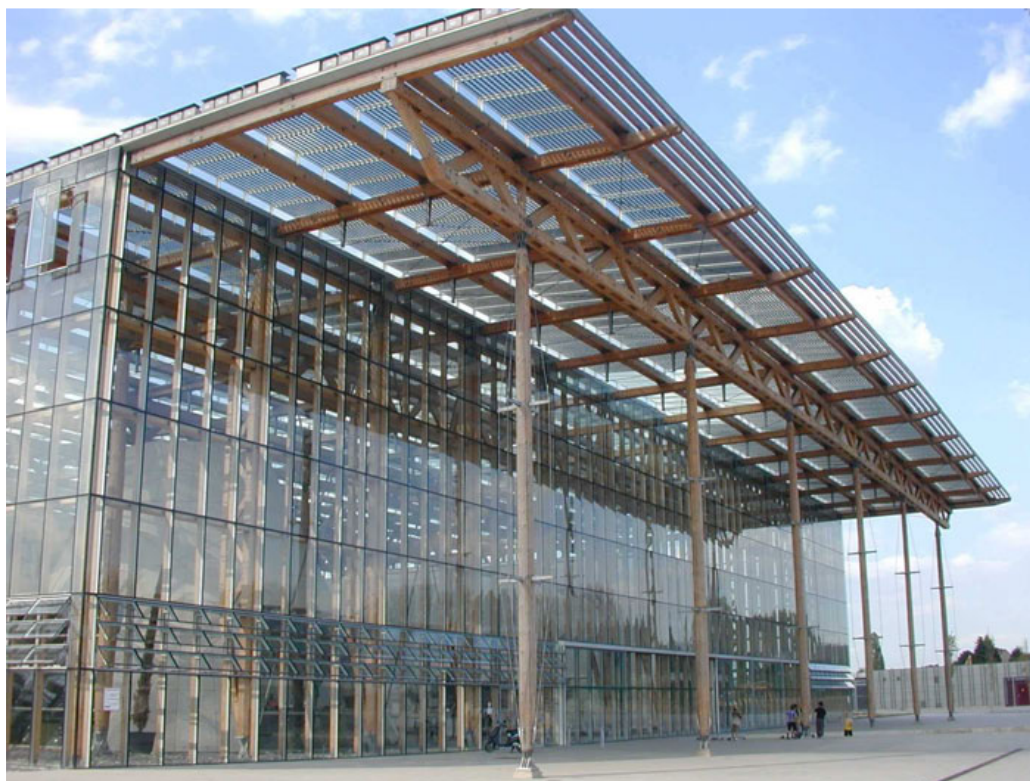
Vista del fronte principale dell'edificio
