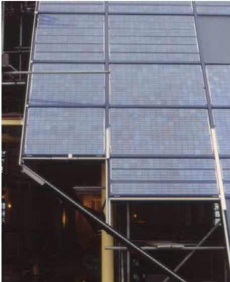
La stringa PV in costruzione
