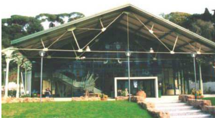
Vista della facciata principale
