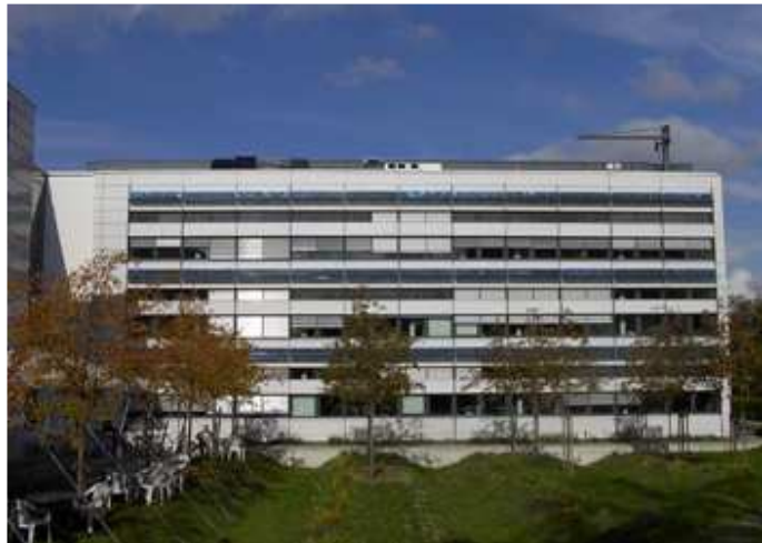
Vista della facciata PV nell'ala sud
