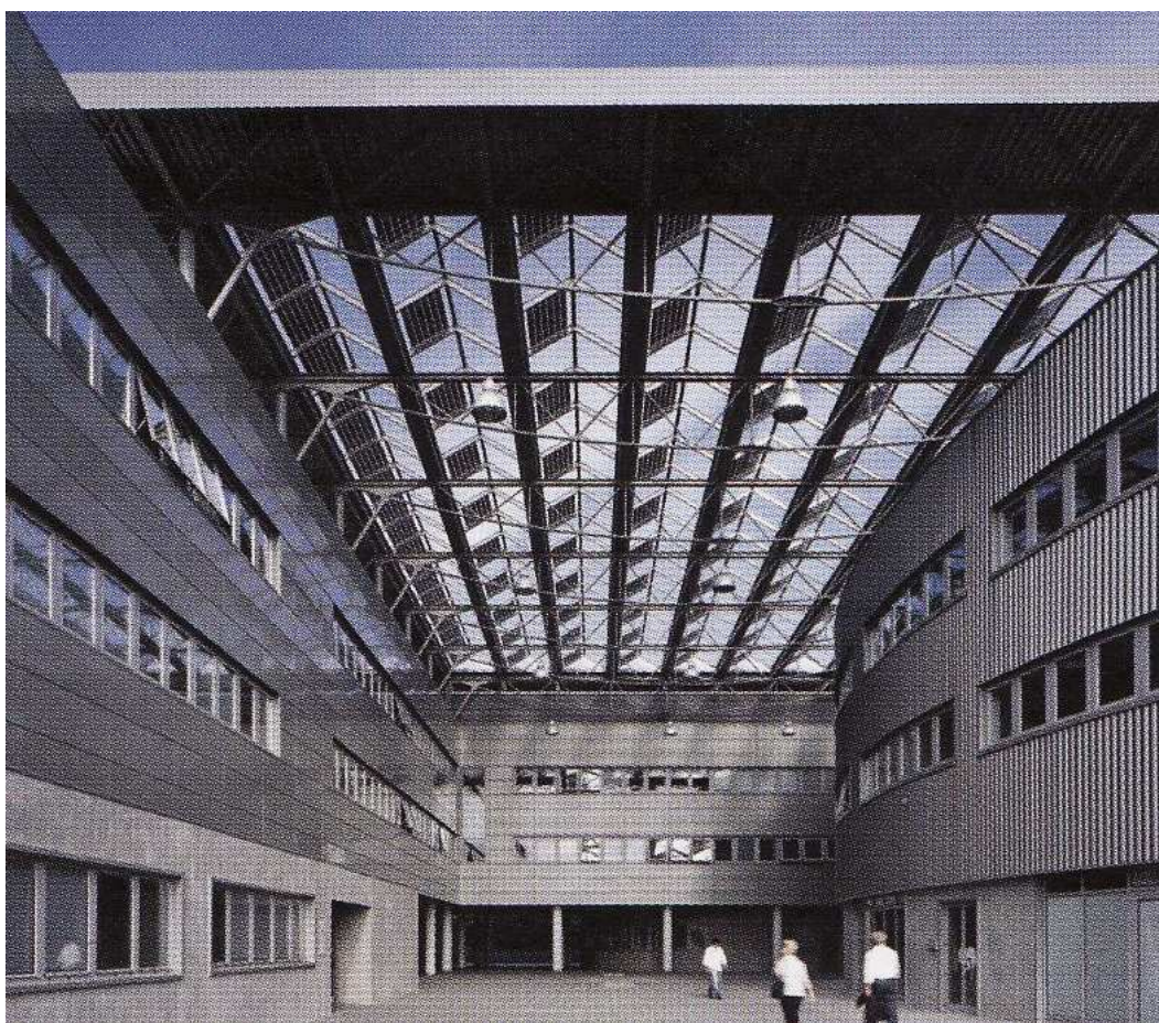
Vista della copertura fotovoltaica
