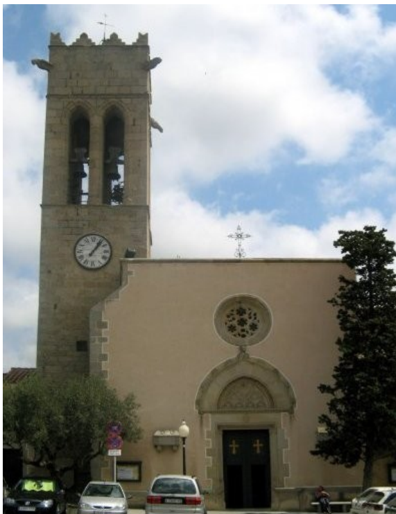
Fig. 30 – Il prospetto della chiesa di Argentona
