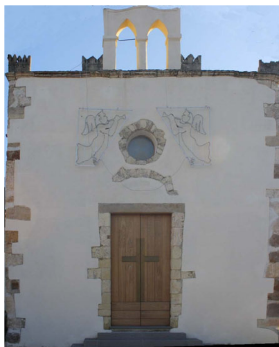
Fig. 5 – Ortofoto della facciata della chiesa di Sant'Anna a Siliqua (CA).
