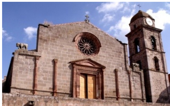
Fig. 17 – Facciata della Vergine del Buon Cammino di Ardauli
