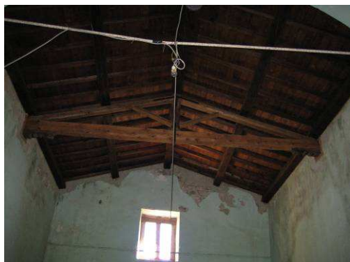
(copertura della navata) foto Paolo Caddeu
