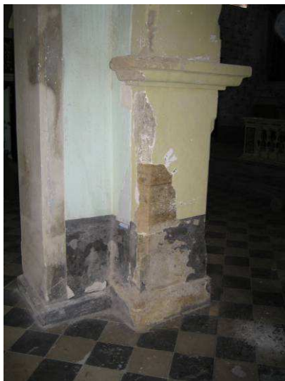
(particolare di un pilastro interno) foto Paolo Caddeu
