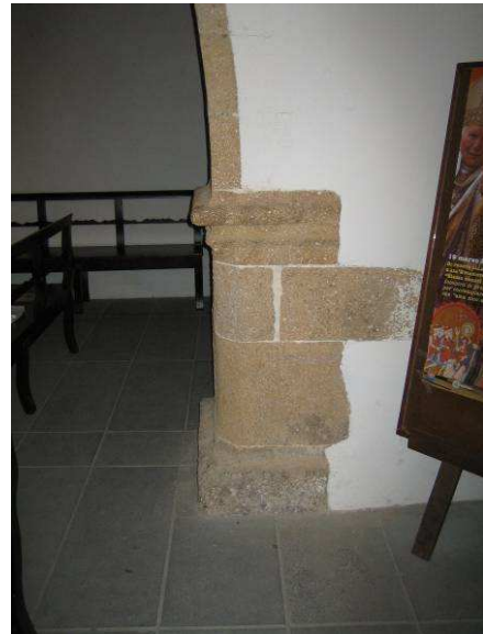
(particolare interno) foto Paolo Caddeu
