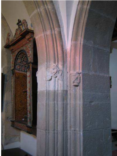
(particolare interno) foto Paolo Caddeu
