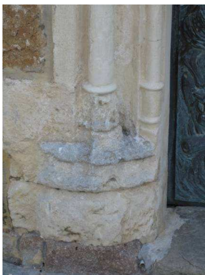
Particolare del portale
