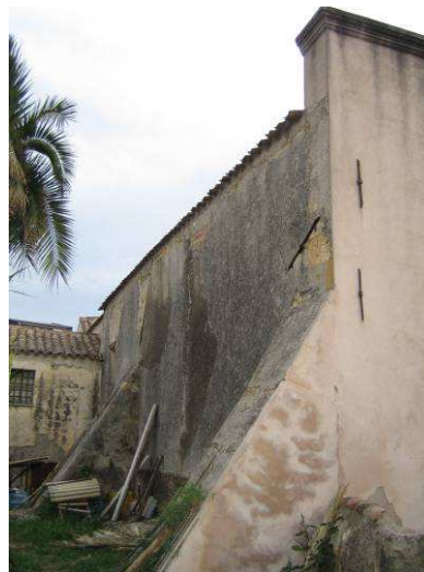
(particolare del contrafforte) foto Paolo Caddeu
