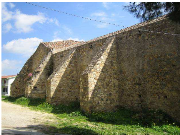
(prospetto laterale sinistro) foto Paolo Caddeu
