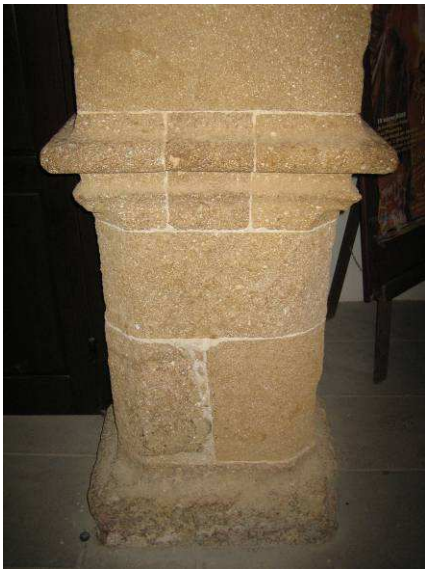
(particolare interno) foto Paolo Caddeu
