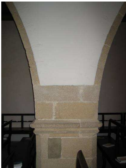
(particolare del pilastro d'appoggio) foto Paolo Caddeu
