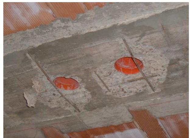
Figura 57: Fori nelle travi a spessore effettuati durante con tubi forma predisposti nella fase di getto: la programmazione di questo intervento, resosi necessario per motivi impiantistici, ha avuto come conseguenza la riprogettazione statica dell'intero impalcato prima della fase di getto. Da notare l'evidente non conformità dovuta al non rispetto degli spessori del copriferro per le staffe in acciaio.
