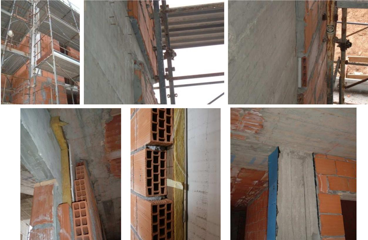
Figura 62: Esempi di coibentazioni termiche e di soluzioni per il rispetto degli standard acustici e termici del sistema edificio-impianti: la visita in cantiere permette di valutare la corretta messa in opera degli strati costituenti il pacchetto di involucro e di confrontarne la soluzione con quanto progettato.
