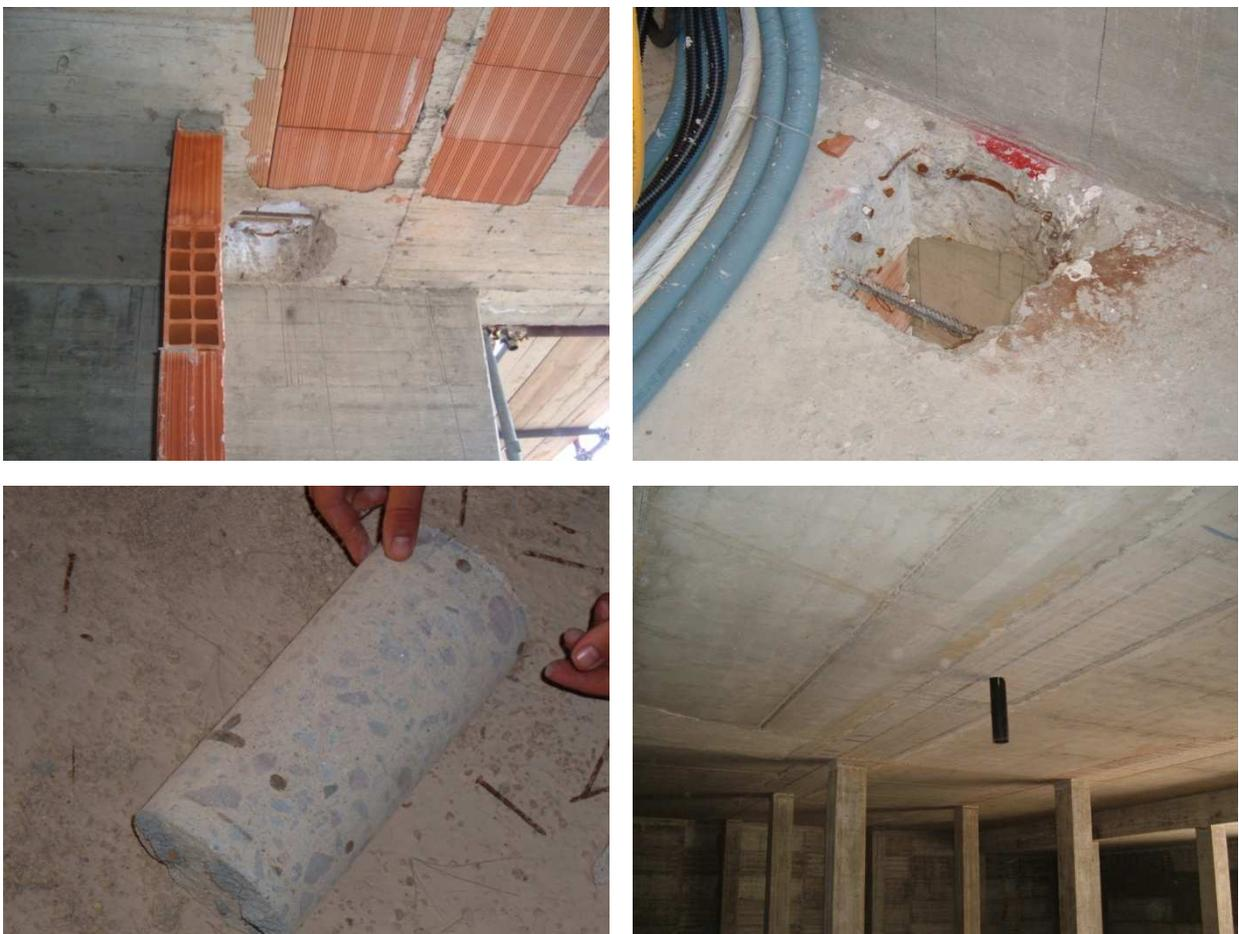
Figura 59: Fori nelle travi effettuati dopo la maturazione dei getti e senza verifica statica. L'intervento dell'impresa in assenza di indicazioni precise o per incomprensione del progetto fa sì che si risolvano i problemi di interfaccia tra sistemi (statici ed impiantistici) attraverso l'impiego di macchine carotatrici per forare le parti strutturali (recidendo anche i ferri d'armatura) compromettendole, in tal modo, staticamente.
