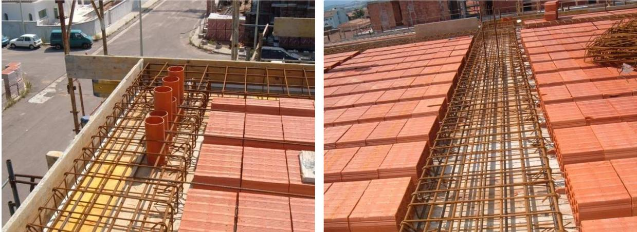
Figura 58: Le visite in cantiere consentono di registrare l'effettiva rispondenza del costruito al progetto soprattutto per le verifiche sensibili come quelle strutturali.
