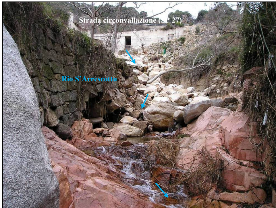
Figura 35 – Vista a valle del 2° attraversamento della S.P. 27 (circonvallazione)
