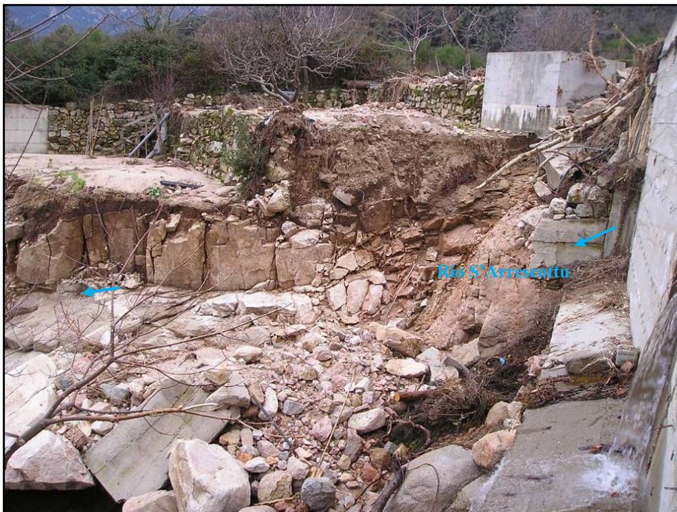
Figura 34 – Vista a valle del 2° attraversamento della S.P. 27 (circonvallazione)
