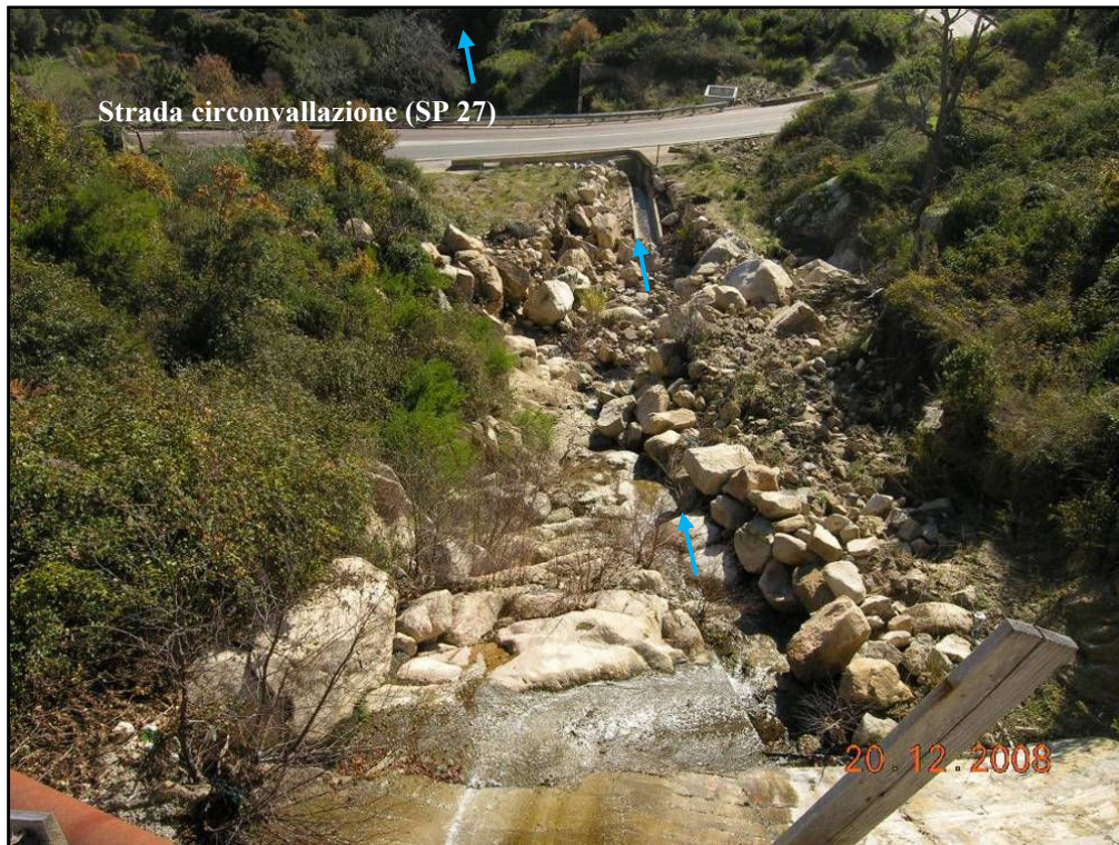
Figura 31 – Vista a valle del primo attraversamento della S.P. 27
