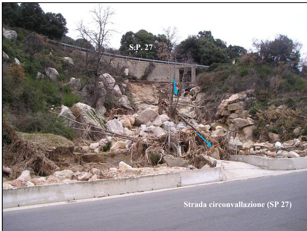
Figura 32 – Vista del tratto tra i due attraversamenti della S.P. 27
