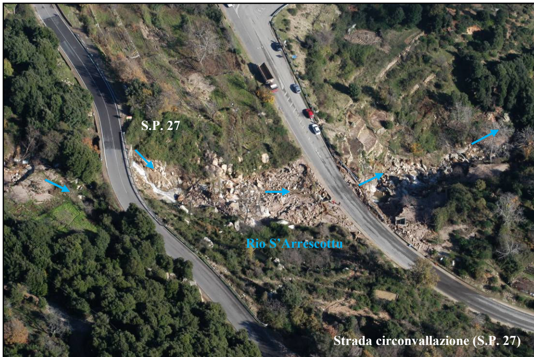
Figura 8 - Vista da elicottero dei fenomeni erosivi e di deposito lungo il rio S'Arrescottu nel tratto tra i due attraversamenti lungo la S.P. 27 per Tortoli (dicembre 2004)
