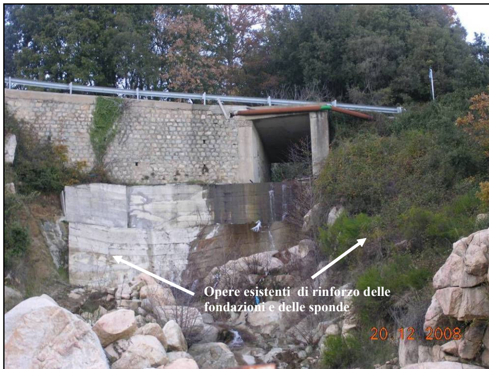
Figura 30 – Vista da valle del primo attraversamento della S.P. 27
