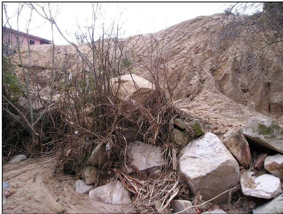
Figura 36 – Vista dei fenomeni di instabilità del versante lungo il rio S'Arrescottu in sponda destra presso località Gurthoi
