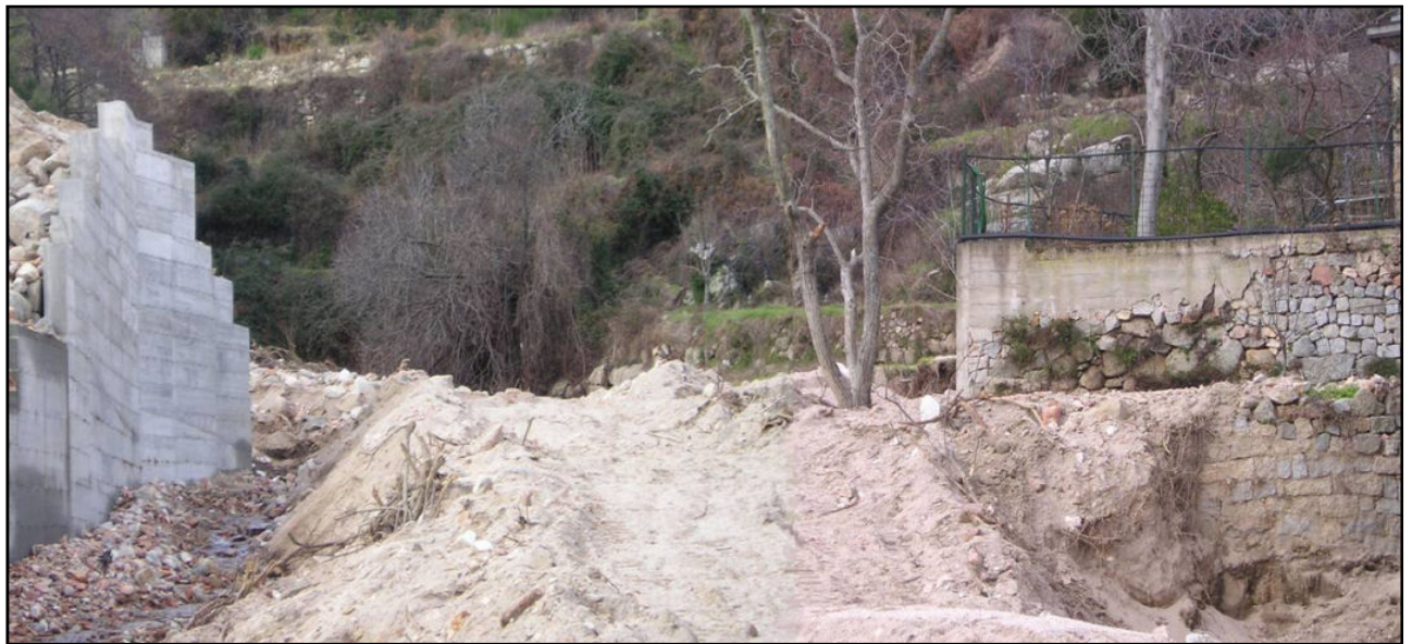
Figura 44 - Colata in prossimità del ponte sulla via Roma
