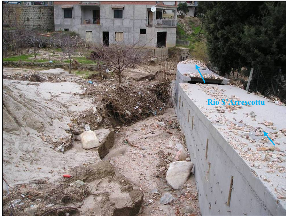
Figura 39 – Vista dei fenomeni di dinamica torrentizia del rio S'Arrescottu con ostruzione della tombinatura a valle della via Roma
