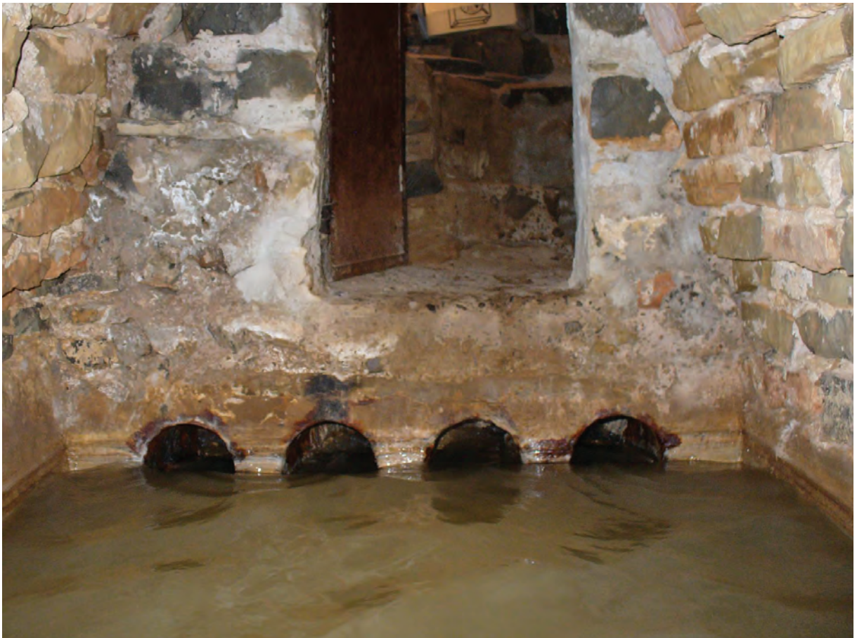
Interno della foggara . (Foto: M. Achenza)
