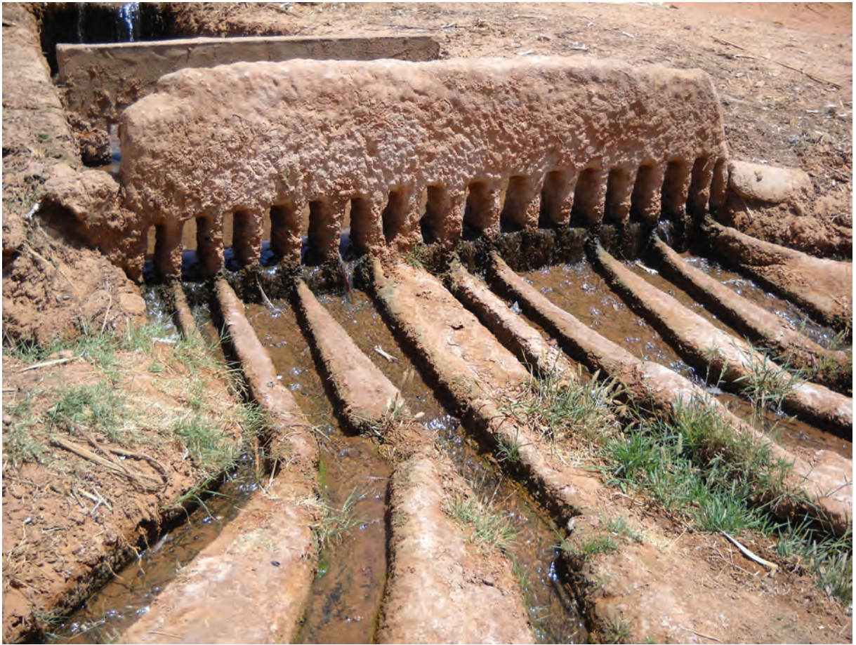
Sistema di ripartizione delle acque a Kasria (Foto: M. Achenza)
