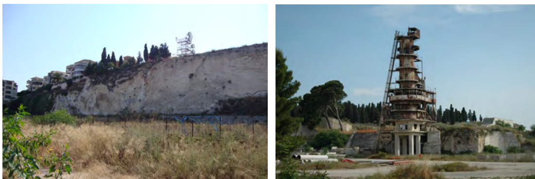
Figura 20 – Fronte di scavo lungo la via Is Maglias, impianto di trattamento della calce
