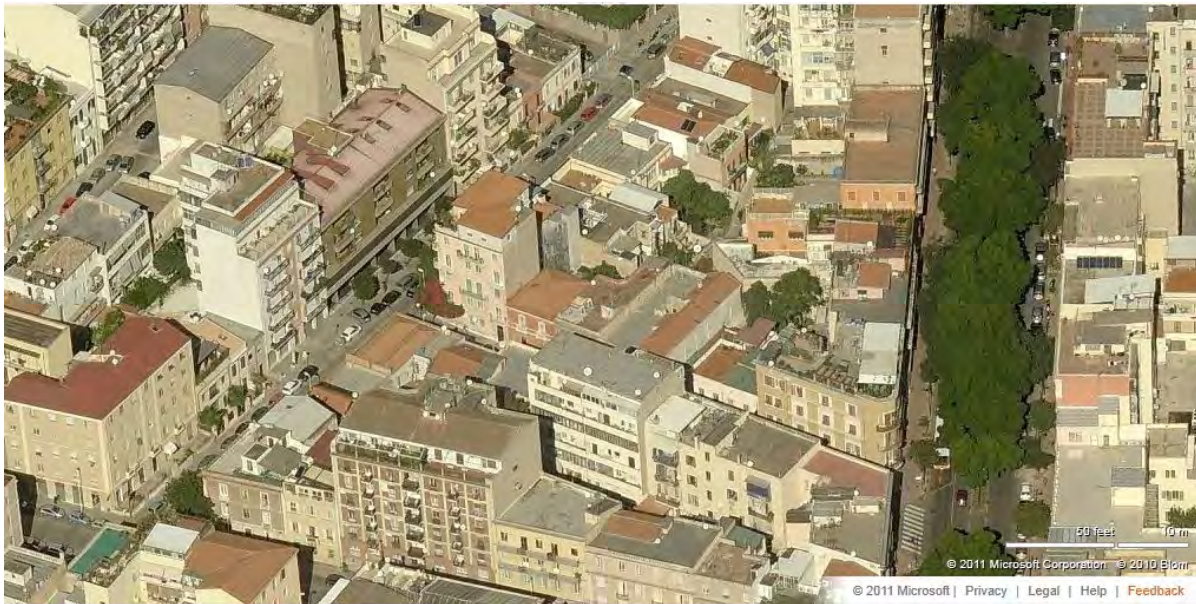
Fig. n°9.11, vista dell'area di studio (Bing Maps) si nota la forte disomogeneità delle coperture.
