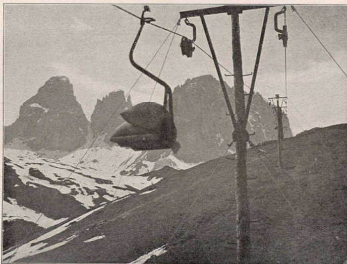
Die Seilbahnen an der Tiroler Front, rasch gebaut, sehr leistungsfähig und fast unsichtbar. Aufnahme von Oblt. Handl.
