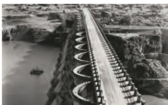
diga di Santa Chiara a Ula Tirso, vista dell'opera in fase di costruzione e a lavori appena ultimati (ITCOLD - SAR.D.L.it)
