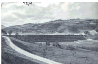
a sinistra: Diga della Polverina, Marche; alta 27.5m, terminata nel 1967 è una diga della tipologia in terra con nucleo di tenuta in argilla e rivestimento a monte in pietra. (MAN.I.H) a destra in alto: Diga di Nurek, Tajikistan; alta 300m, terminata nel 1980, è una diga in terra zonata con ricoprimento in pietra sui paramenti. (RID.C) a destra in basso: Diga di Assuan, Egitto; alta 111m, terminata nel 1970 è una diga in terra e pietra con nucleo in terra. (RID.C)
