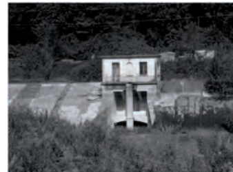
vista dell'opera di scarico prima della demolizione (ITCOLD)
