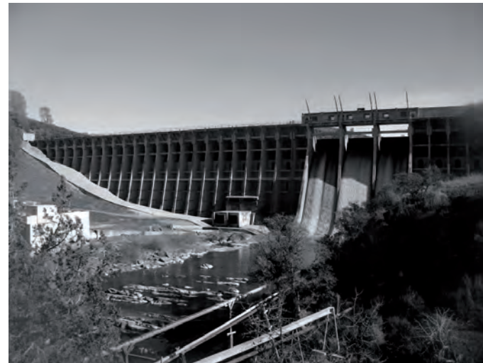
Diga di Stony Gorge, California, USA; diga a gravità alleggerita del tipo a speroni e piastra alta 42.40m terminata nel 1928. (WEB)
