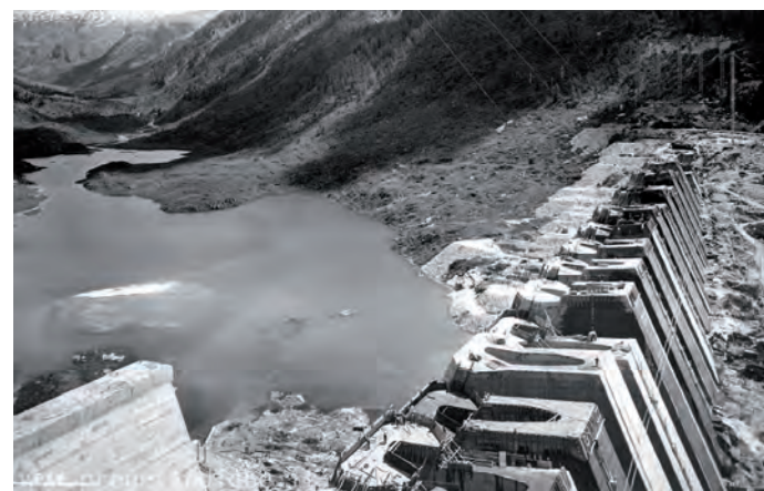
diga di Malga Bissina, Trentino Alto-Adige, Italia; diga a gravità alleggerita del tipo a vani interni, alta 81.0m è stata ultimata nel 1957 (PROG.D.)
