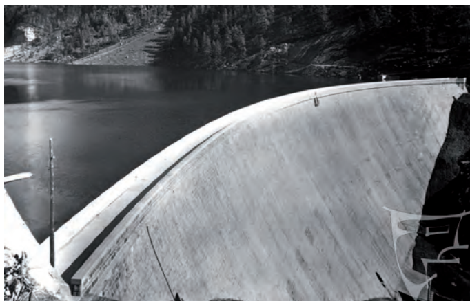
in basso a sinistra: Diga di Agaro, Piemonte, Italia; è una diga a gravità ordinaria alta 57.6m terminata nel 1940. (PROG.D.)
