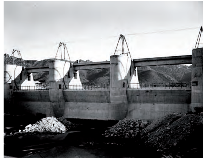
a sinistra Benzone - aprile 1962 - vista generale sul cantiere: si lavora alle complesse casse-forme degli speroni (P.TMM, A.OMOD)
