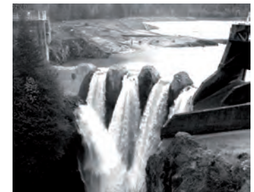
dall'alto: Demolizione della diga di Condit; l'apparente lentezza dell'operazione è giustificata dalla complessità di movimentare le macerie in altra sede. Nell'immagine successiva si noti il paziente lavoro di rimodellazione degli argini con la movimentazione dei sedimenti che nel tempo hanno colmato l'invaso. Sotto: demolizione della diga di Elwha (stato di Washington, USA). In questo caso la demolizione è avvenuta a pieno vaso e dall'alto al fine di ridurre lo sversamento a valle dei sedimenti (2011-2012). (www.columbian.com, WIKI)
