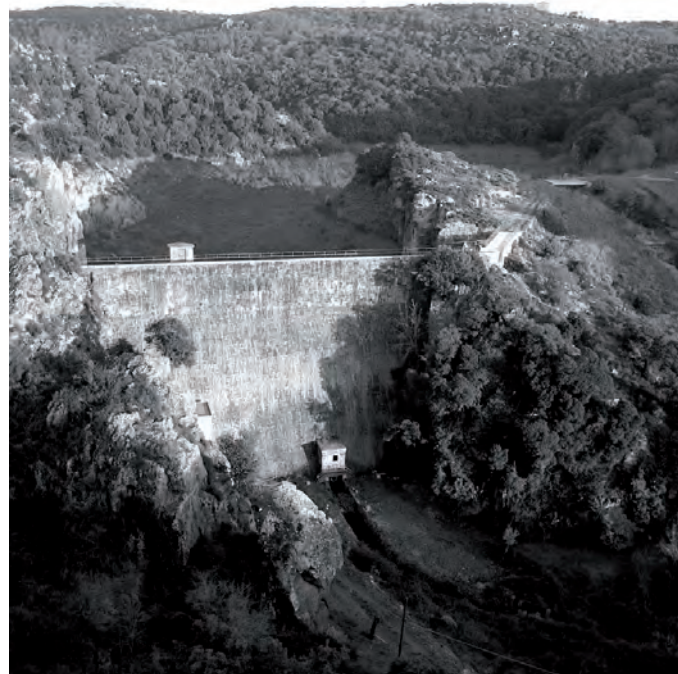
diga a gravità in muratura di Bussari Bassa, terminata nel 1879 è alta 27.5m per una capacità di invaso di 0.46 Mmc (RID.C)
