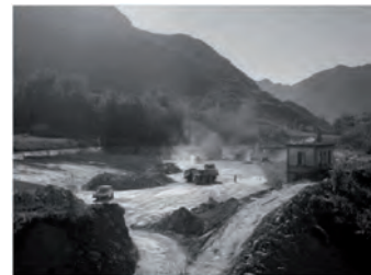
vista del bacino nella fase di realizzazione dei lavori (ITCOLD)
