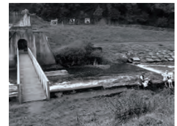
diga di Kernansquillec a seguito della dismissione. (ITCOLD)
