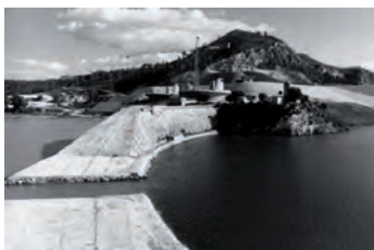
diga di Disueri, vista della breccia realizzata del corpo centrale della vecchia diga (ITCOLD)
