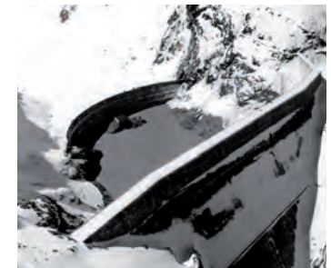
dall'alto: Diga di Santa Chiara sul Tirso, Sardegna; ampiamente analizzata nel capitolo sul decommissioning, nelle immagini appare prima e dopo l'invaso del nuovo bacino sotteso a valle dalla diga Cantanera. Diga Grande Dixence, Svizzera; l'immagine mostra la nuova diga a valle della originale Dixence, una diga a gravità alleggerita completata nel 1935 e sommersa nel 1965 ( www.grande-dixence.ch )
