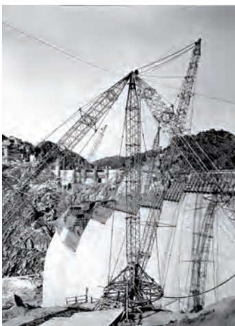
Derricks: è una gru a torre con albero verticale e una porzione orizzontale. Può essere fissa (su un telaio o incorporato in una massa di cemento o mobile). Può misurare fino a 75 m di altezza e avere una penna di 40 metri. (P.TMM, A.OMOD)
