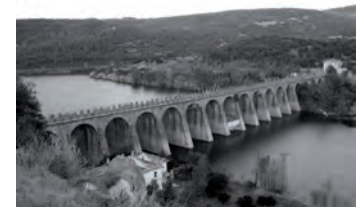
diga di Santa Chiara a Ula Tirso, apertura dei varchi nel vecchio sbarramento e la nuova diga Cantoniera, più a valle. La vecchia diga è attualmente semisommersa. (ITCOLD, SAR.D.L.it)
