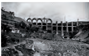
diga di Disueri, vista della breccia realizzata del corpo centrale della vecchia diga (ITCOLD)
