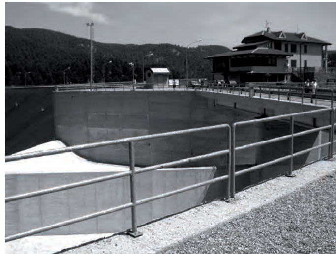
a sinistra: Riccardo Morandi, Diga sul Menta, Calabria, 1987- sfioratore di superficie e ponte pedonale. (PANORAMIO)
