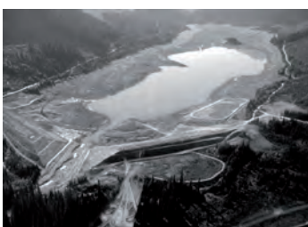
vista aerea della diga di Coursier: è visibile la breccia praticata nella parte centrale dell'opera. (ITCOLD)
