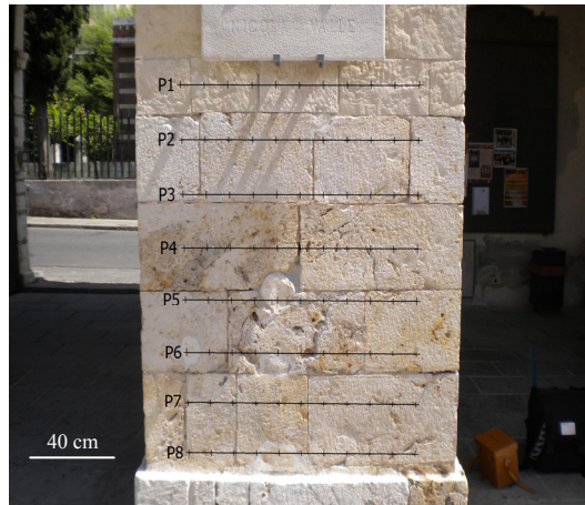
Figura 2.47: Schema di acquisizione dei dati ultrasonici in modalità indiretta nel lato “A” del pilastro.
