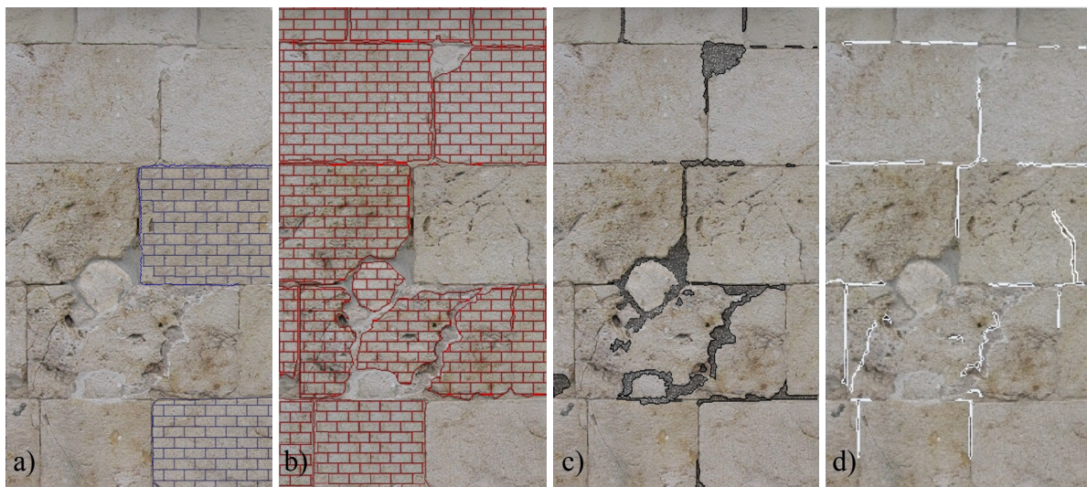
Figura 2.51: Analisi della tessitura muraria: (a) conci con velocità ultrasonica paragonabile a quella della Pietra Forte ; (b) conci con velocità ultrasonica paragonabile a quella del Tramezzario ; (c) zone con cemento o malta; (d) spazi vuoti compresi entro i conci o tra i giunti.
