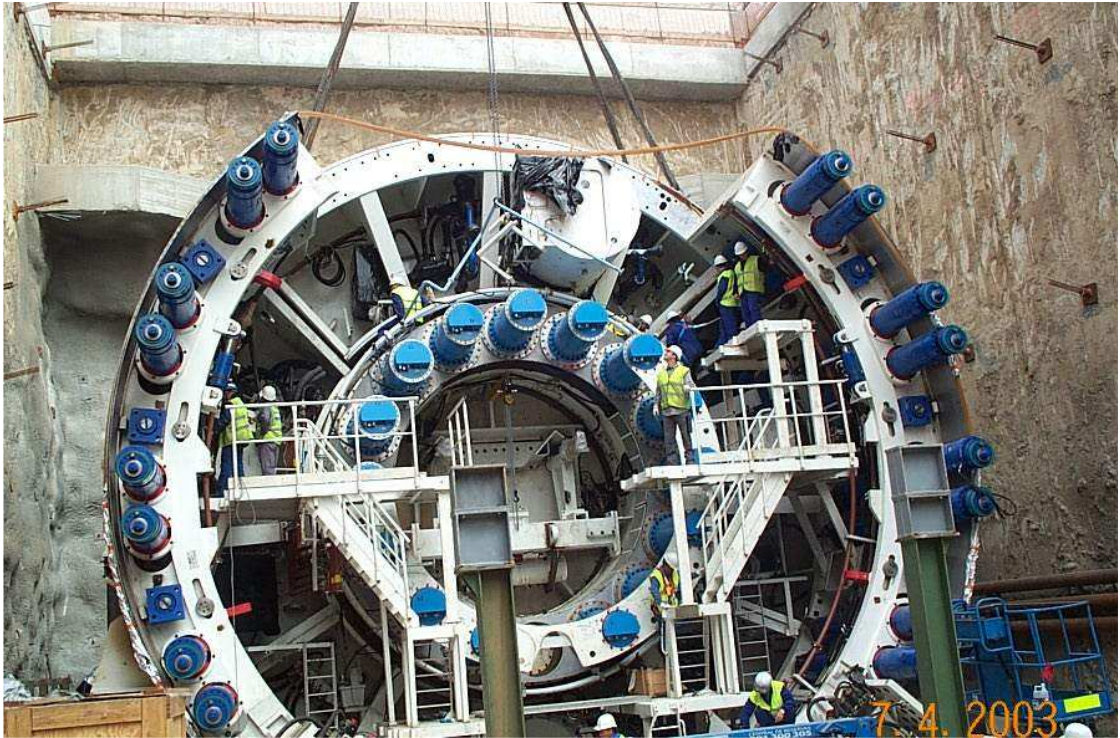
Figura 52: particolare dei motori per la rotazione e dei cilindri per l'avanzamento
