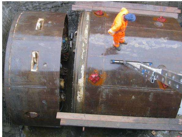
Figura 64 Effetto dei cilindri di articolazione tra lo scudo anteriore della TBM e lo scudo stazionario
