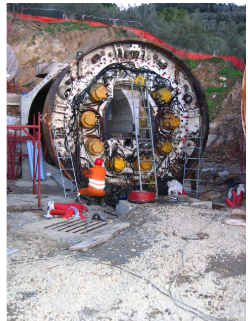
Figura 64 a: Scudo stazionario e ( a destra ) e scudo anteriore con piastra motori ( a sinistra).
