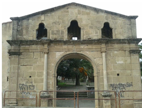
Figura 6.17. S'ecca 'e donna Annetta : il portale del podere di donna Annetta, eretto a Cabras tra la fine del 1600 e i primi del 1700, fungeva d'accesso all'oliveto de Su Marchesu (oggi scomparso). ed è attualmente considerato tra i più importanti esempi di architettura rurale della Sardegna.
