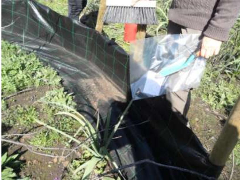
Figura 57 - Silt fence - raccolta materiale eroso.
