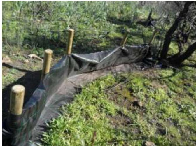
Figura 56 Particolare del posizionamento del geotessile
