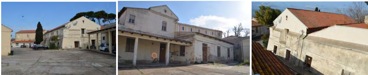
Fig. 2 - L'ex Panificio Militare, esterni: la ridotta del bastione e il piazzale del compendio; l'antico panificio; una vista della antica ridotta dal viale Buoncammino ove sono chiaramente riconoscibili le strutture bastionate della ridotta e i volumi sovrapposti che attualmente ospitano la Biblioteca di Presidio (foto V. Santoni per gentile concessione dell'E.I.).
