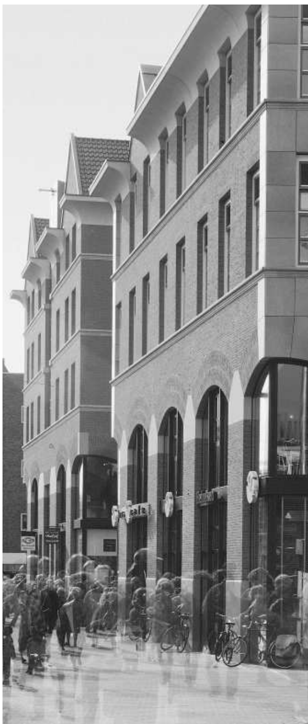
Ricostruzione della Waagstraat a Groningen. (Da: Costruire in Laterizio n. 81, maggio - giugno 2001, foto di Ciampi Mario).
