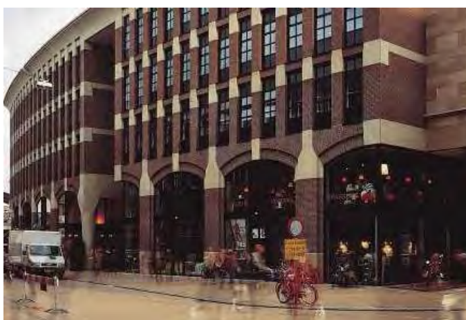
Ricostruzione della Waagstraat a Groningen. (Da: Costruire in Laterizio n. 81, maggio - giugno 2001, foto di Mario Ciampi ).
