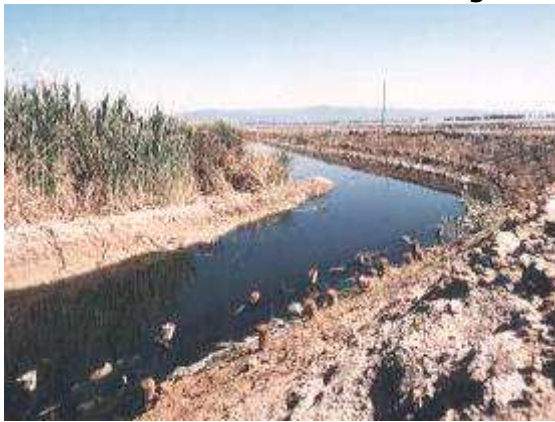
Foto 10 Rinaturazione delle sponde e rifacimento degli argini del canale di deflusso del Perdalonga
