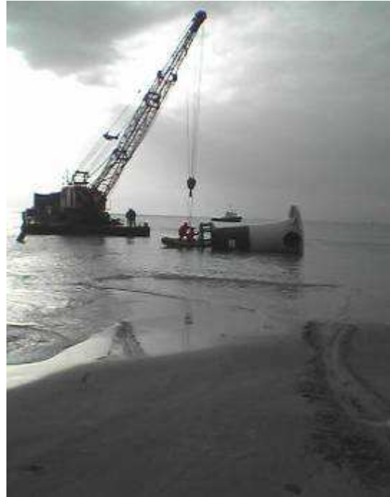
Foto 23 Nuova opera di presa a mare e relativa camera di aspirazione
