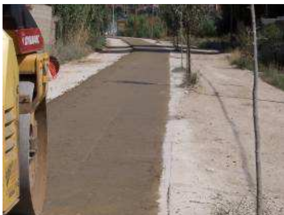
Foto 20 Risistemazione del piano viario esistente e realizzazione delle piste ciclabili
