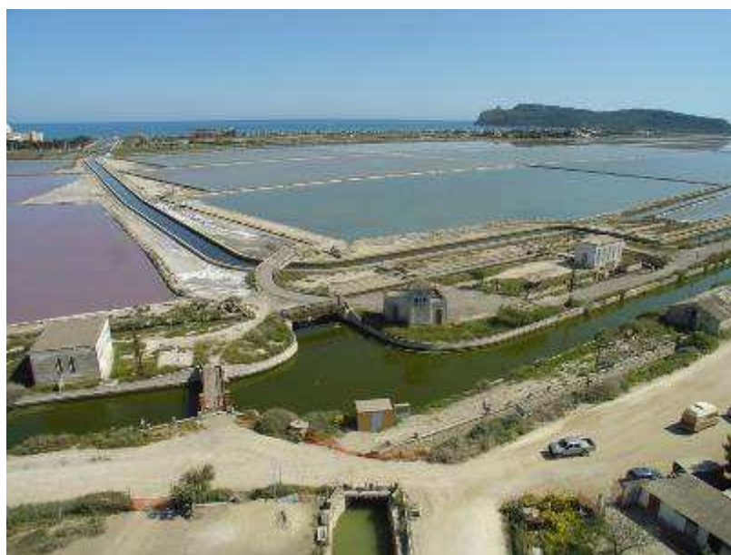
Foto 1 Idrovora del Rollone e complesso sistema di canali e chiuse, che consente la corretta distribuzione delle diverse acque sollevate.
