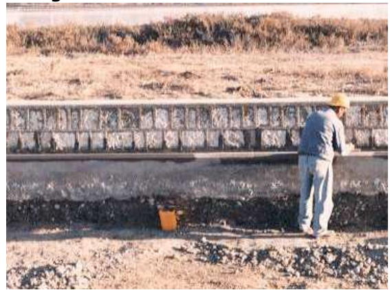
Foto 10 Rinaturazione delle sponde e rifacimento degli argini del canale di deflusso del Perdalonga
