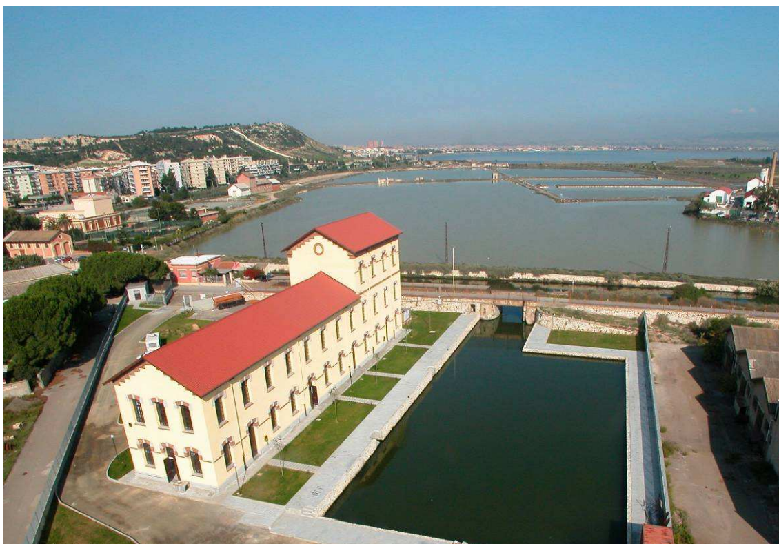
Foto 18 Edificio Sali Scelti ristrutturato e attuale sede del Parco
