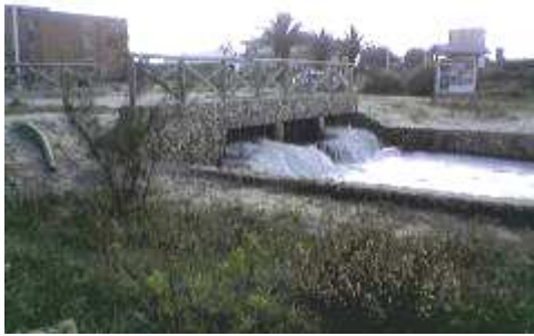
Foto 23 Nuova opera di presa a mare e relativa camera di aspirazione
