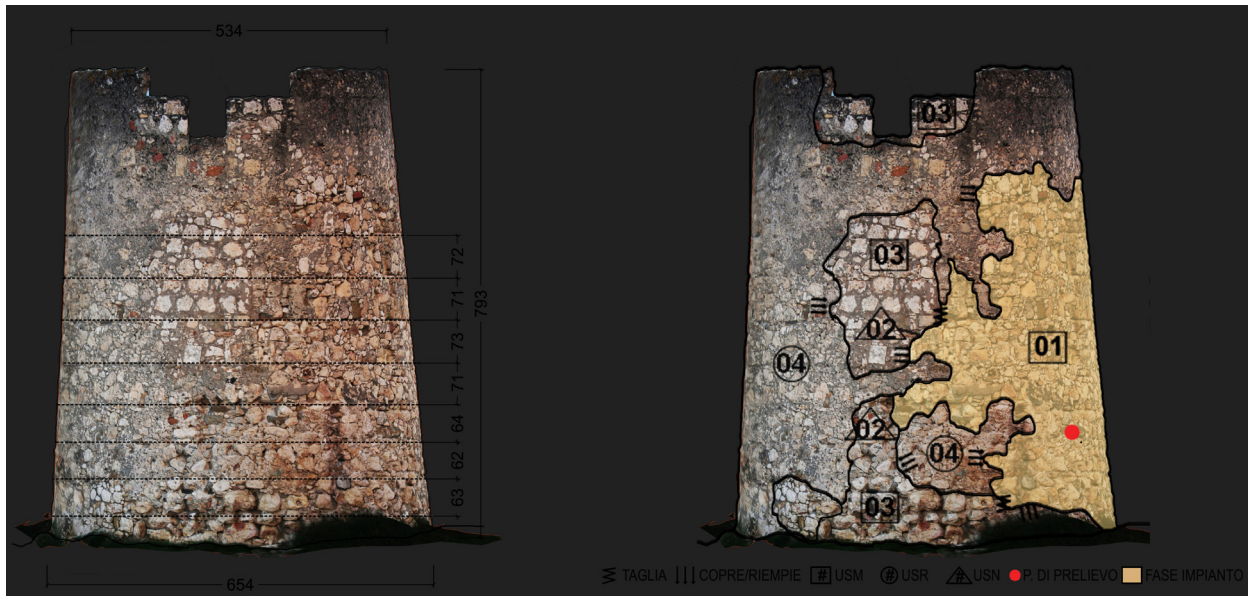
Fig. 18. Ricostruzione del modello tridimensionale con indicazione dei cantieri e rilievo stratigrafico della torre di Mezza Spiaggia
