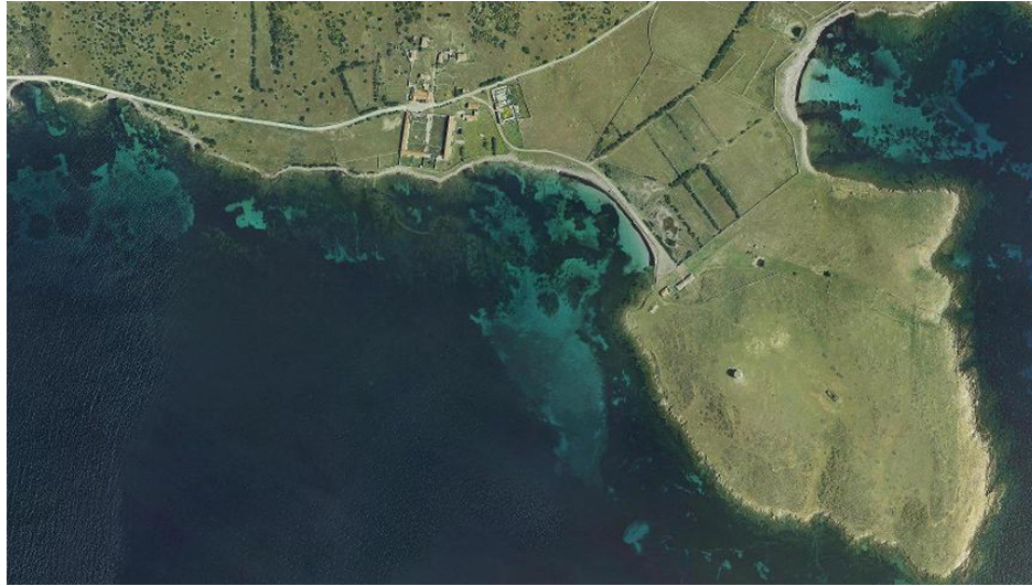
Fig. 44. La torre di Trabuccato Foto aerea, volo del 2006. In http://www.sardegnageoportale.it/webgis2/sardegnafotoaeree/ .
