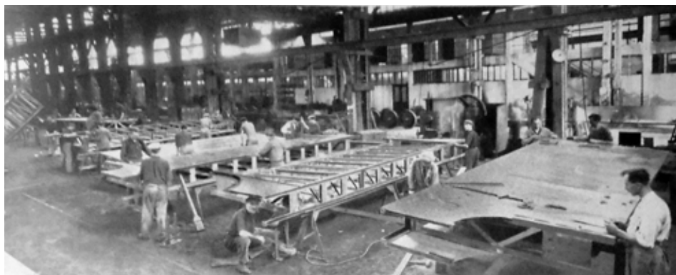
Struttura saldata dei fasci in montaggio nelle officine Savigliano. (Bollettino Tecnico Savigliano n.4-5 1933)
