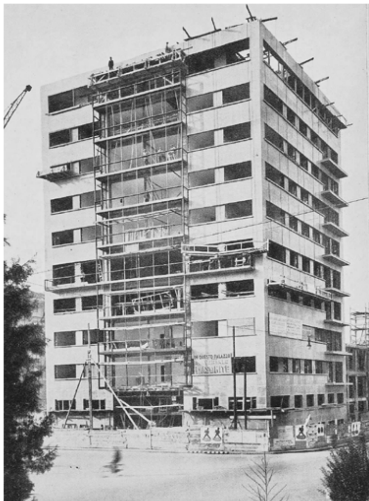
Foto dell'edificio in costruzione. (L'ossature métallique, n. 5 1936)
