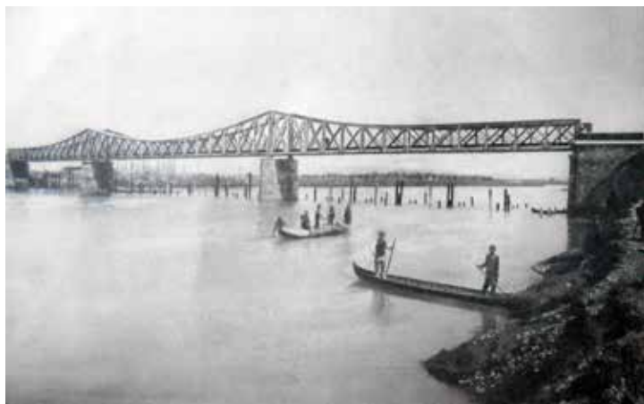
Ponte sul Tanaro (1886). (Types de construction métalliques, 1914)
