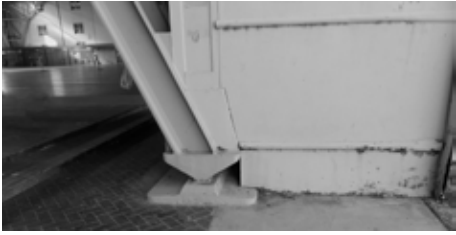
Particolari del sostegno del cavalletto trasversale doppio incernierato alla base. (Foto M. Pisanu; fondo Ministero dell'Aeronautica, ACS Roma)
