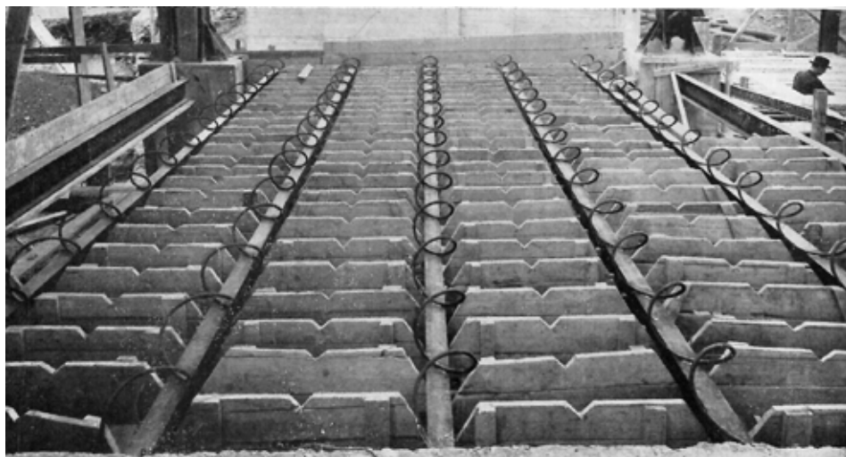
Solaio Alpha, tramezze di legno per la formazione dei casseri. Si notano gli intagli a V per il passaggio dei cavi. (Edilizia moderna n. 18 1935)
