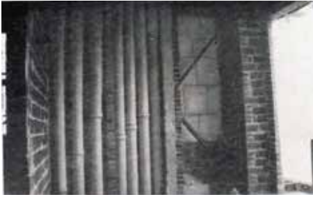
SNOS, "Grattacielo" di Torino. Nella foto si vedono le tubazioni che passano nella camera d'aria dei muri perimetrali. (L'architettura italiana, dicembre 1935)
