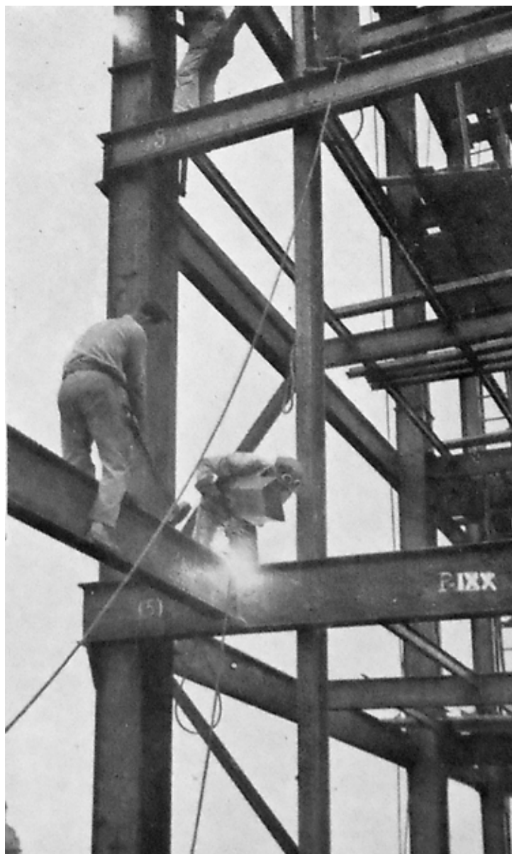
Saldatura di una trave. (Bollettino Tecnico Savigliano 3-4 1933)
