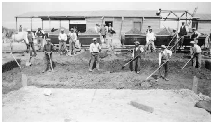
SNOS, fase di scavo per la costruzione dell'hangar Savigliano dell'Aeroporto Militare di Elmas. (1933) (Fondo SNOS, Biblioteca "Roberto Gabetti", Politecnico di Torino)
