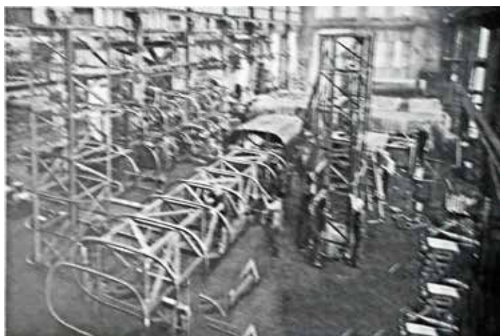
Struttura saldata dei fasci in montaggio nelle officine Savigliano. (Bollettino Tecnico Savigliano n.4-5 1933)
