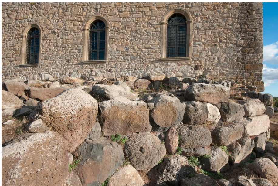
Fig. 2: La sovrapposizione evidente delle mura del palazzo su quelle più antiche del palazzo. In primo piano l'opera muraria della cortina ovest e della torre nord-ovest.
