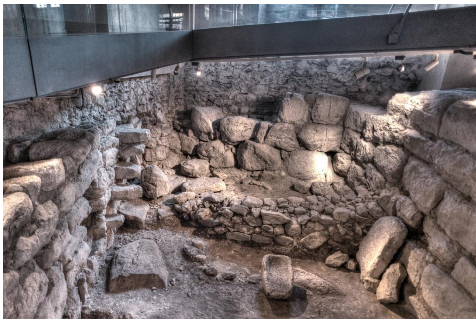
Fig. 7: Il cortile compreso tra l'antemurale, a sinistra, la cortina sud-est a destra e la torre sullo sfondo. Nel paramento murario dell'antemurale è visibile la scala realizzata con lastroni infissi nella muratura.
