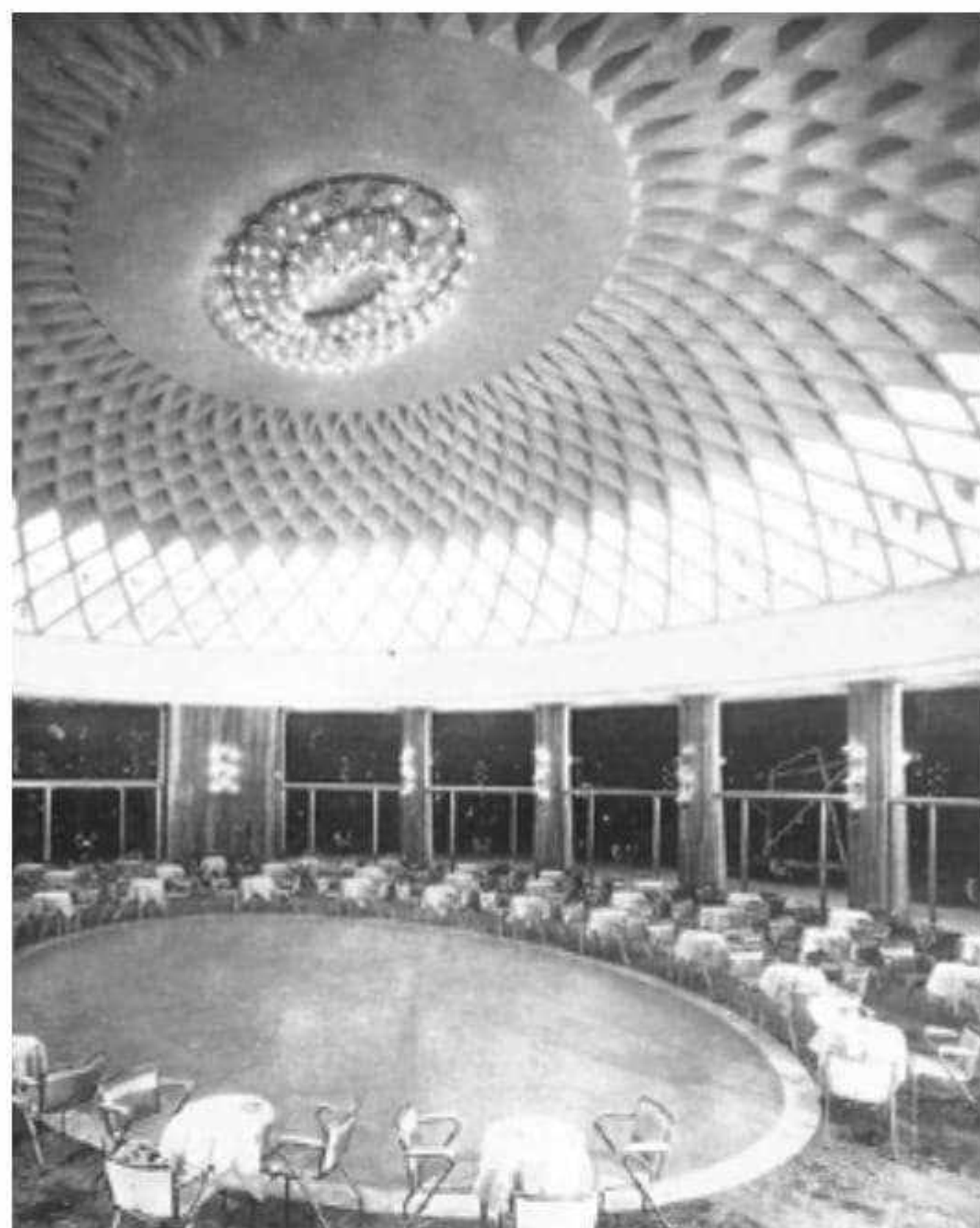
Fig. 103 Copertura del salone delle Nuove Terme di Chianciano di Pier Luigi Nervi, foto storica.
