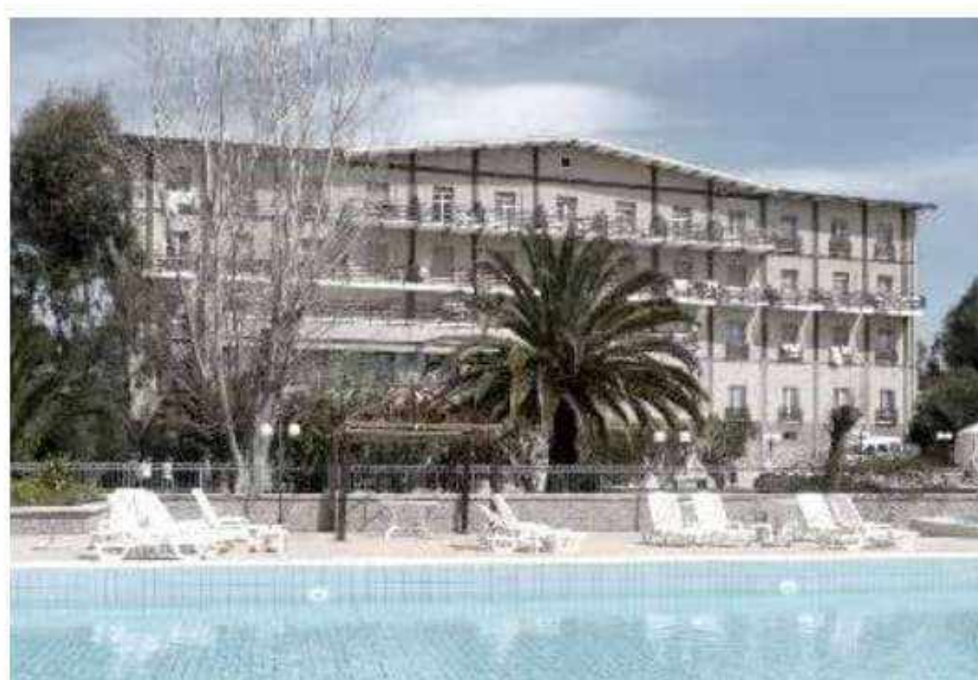
Fig. 184 Edificio delle Terme San Saturnino, Benetutti.
