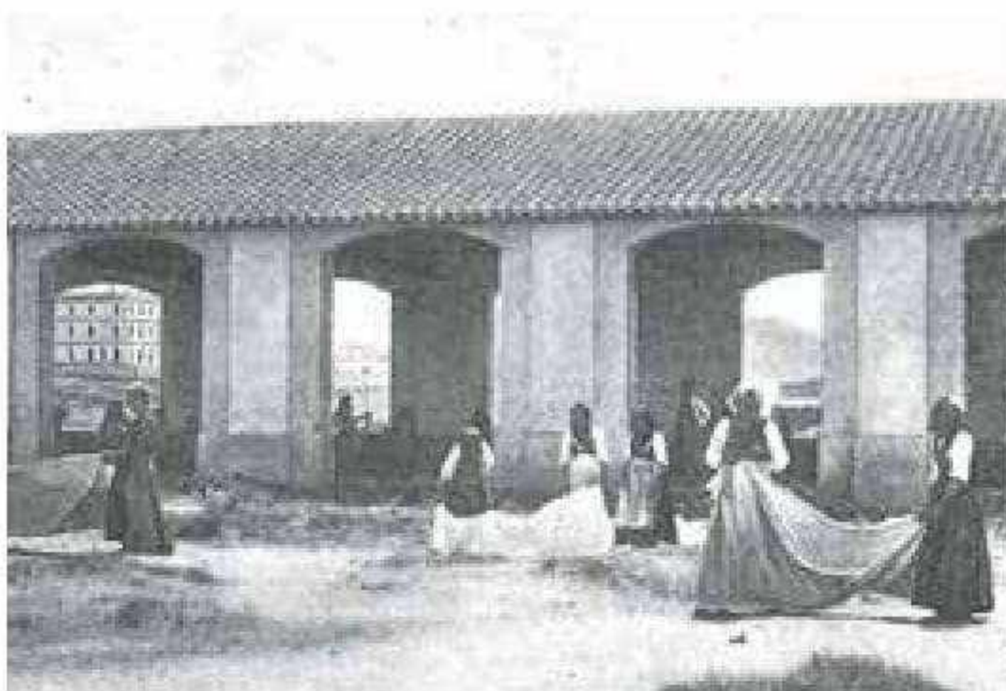
Fig. 245 Edifici di Gaetano Cima , foto storica.
