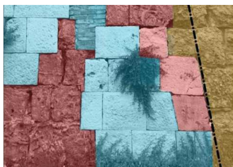
Fig. 4- Dettaglio del Bastione della Concezione: disposizione della scarpa in prossimità della cortina di San Guglielmo. In rosso sono indicati i conci riconducibili alla cortina del XVI sec., in giallo il muro realizzato nel XIX sec. a seguito delle demolizioni, in ciano i successivi restauri
