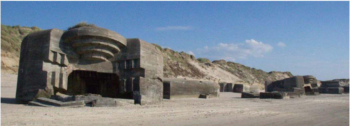
Figuras 31-32. Arriba, figura 31, búnker apostado en una de las vías de los campos en retícula de Arborea (Or), Cerdeña (foto A. Martínez-Medina, 2016); abajo, figura 32, vista general de los búnkeres de la II Guerra Mundial esparcidos por la playa de Løkken, Dinamarca (foto A. Martínez-Medina, 2018).
