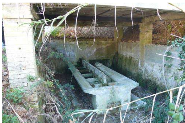
Fig. 3: Massignano, provincia di Ascoli Piceno. Lavatoio comunale.
