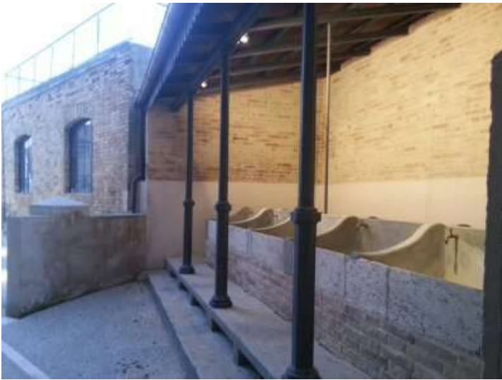
Fig. 8: Carassai, Lavatoio comunale (1901).
