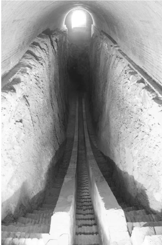
Figura 5. Del grande osservatorio astronomico di Ulugh Beg si è salvata soltanto la porzione inferiore del grande Quadrante Verticale, spogliata dei marmi e del bronzo delle scale graduate. Era tre volte più grande di quello realizzato, oltre un secolo dopo, da Tycho Brahe a Uranieborg.
