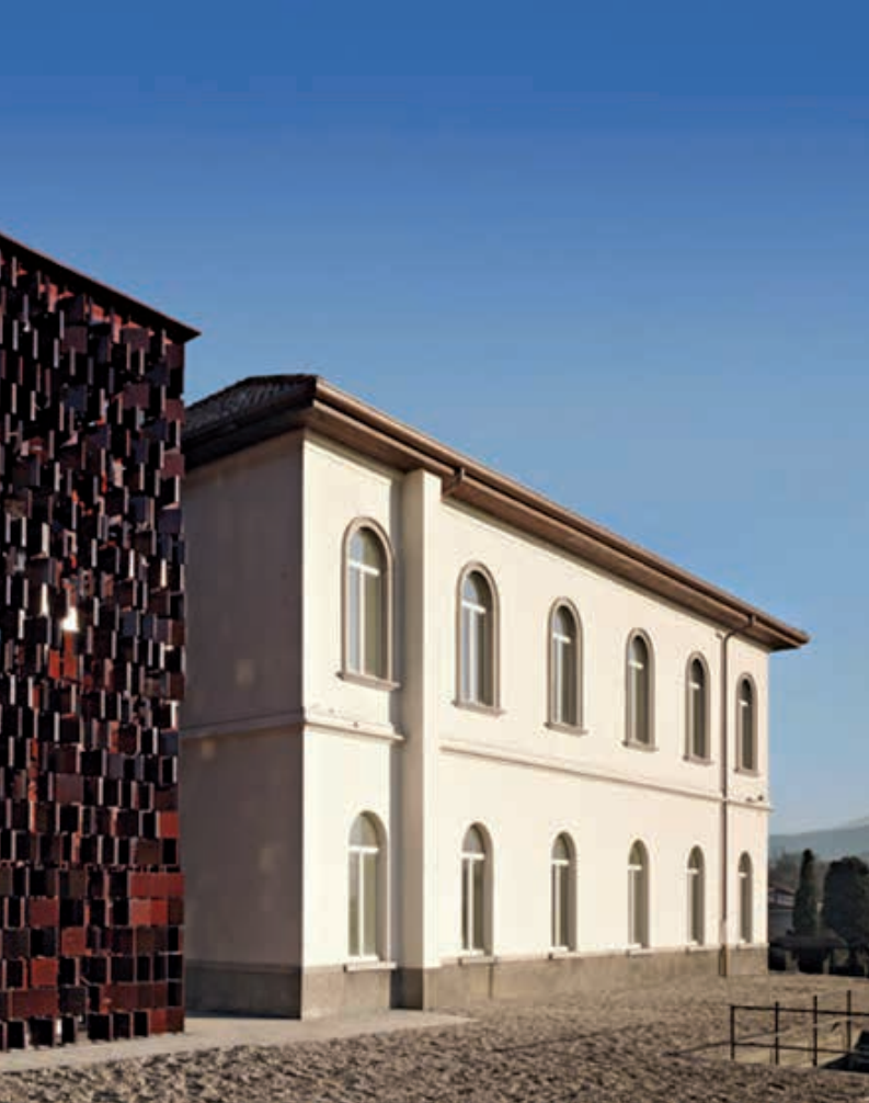
Biblioteca e Auditorium comunali di Nembro. Italia. Progetto di Archea Associati (2005-2007). Firenze, Italia. Rivestimento frangisole realizzato da elementi in cotto smaltato serie Externa di Sannini Impruneta. Fonte: www.sannini.it
