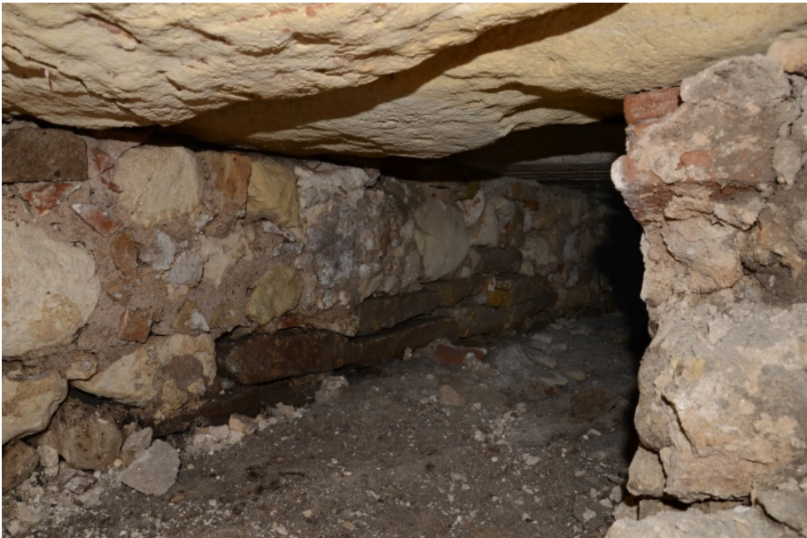
CAGLIARI - Ex Manifattura Tabacchi. Canale di scolo delle acque (foto C. Nieddu)
