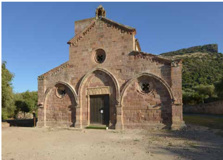
La chiesa di San Pietro di Bosa, vista dal Castello, lungo la sponda opposta del fiume e a monte, sede del vescovo di Bosa Costantinus di Castra che la fonda nella seconda metà dell'XI secolo. La facciata è oggetto di una ristrutturazione il cui disegno può essere attribuito a maestranze cistercensi della vicina abbazia di Sindia, vista la identità dei tre archi con quelli presenti a Casamari e a Fossanova.
