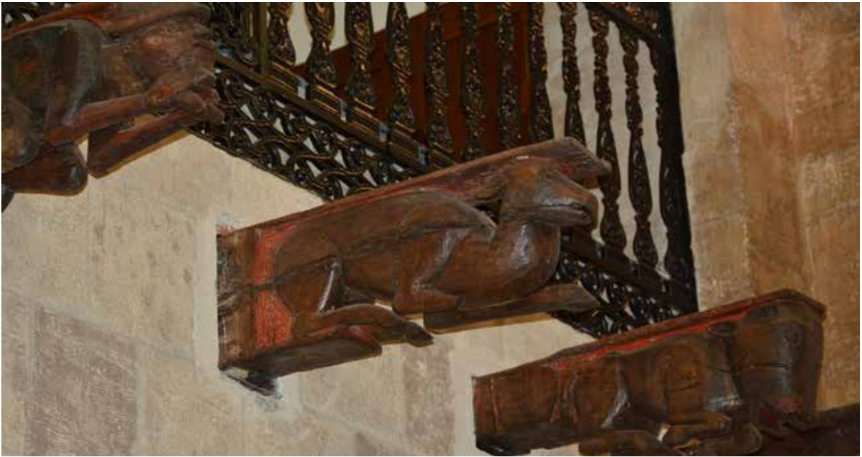
Alcune delle mensole lignee decorate e intagliate dell'originale tetto trecentesco di Santa Chiara di Oristano, demolito nel 1923.
