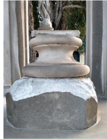
*Figura 13 - Tomba monumentale e particolare con evidente presenza di croste nere e perdita materica.*
