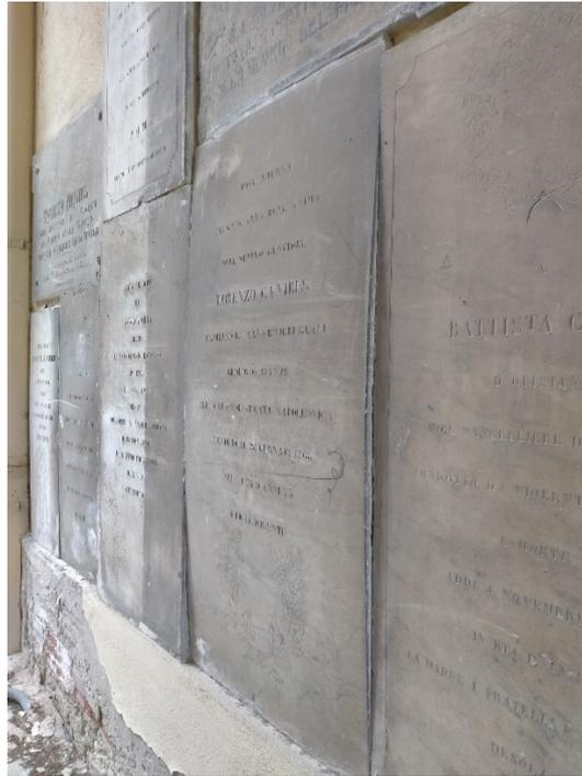
*Figura 7 - Deformazione di un'antica lapide sepolcrale (bending) presso il cimitero di Bonaria.*
