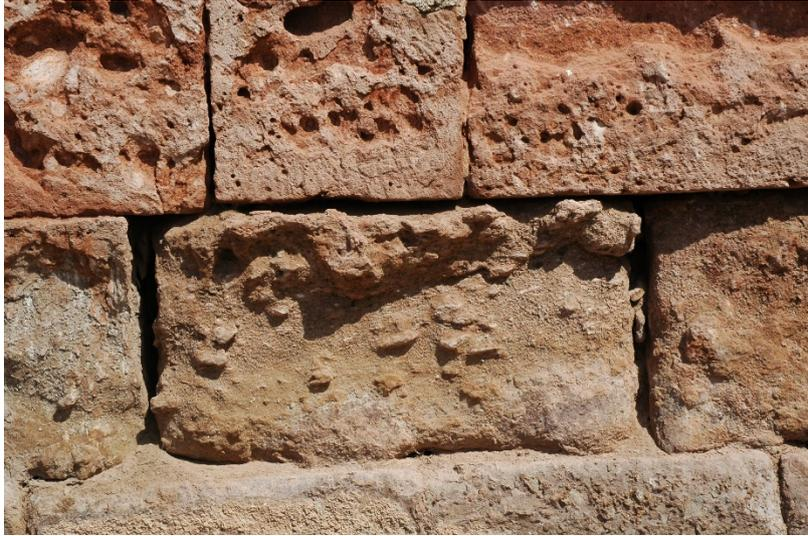
*Figura 8 - Fenomeno di erosione causata dal vento su un'arenaria.*
