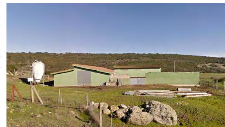
[ Figura 3.71f ] Laconi, Sarcidano; Azienda recente a corte chiusa con hangar a doppia falda sfalsata e fabbricati in laterocemento; all'esterno un silo metallico per il mangime e lavori di sistemazione del suolo;
