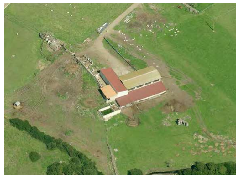
[ Figura 3.36h ] Tergu (Anglona); azienda zootecnica di nuovo impianto, realizzata con la giustapposizione di hangar e padiglioni rispetto a una vasta corte informale; i bordi ospitano i dispositivi tecnici; I campi circostanti, spietrati e disboscati, sono pascolati e coltivati a foraggere in alternanza biennale;
