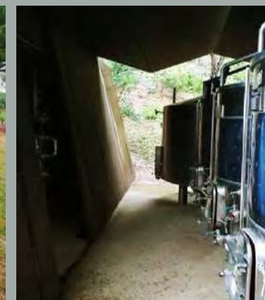
[ Figura 2.58 ] I tagli di luce che illuminano gli accessi e gli spazi di lavorazione intermedia.
