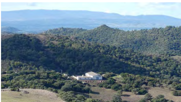
[ Figura 3.72b ] Laconi, Sarcidano; azienda ovina di nuovo impianto a corte chiusa e due bracci di fabbricati (hangar e stecca), sovrainposta al paesaggio di macchia-foresta del pascolo brado estensivo;
