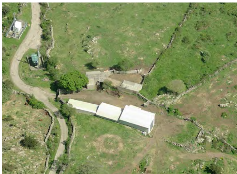
[ Figura 3.36f ] Santu Lussurgiu (Oristano); tettoie e hangar di nuovo impianto costruiti su un articolato sistema di recinti di lunga durata; (Sardegna Geoportale);
