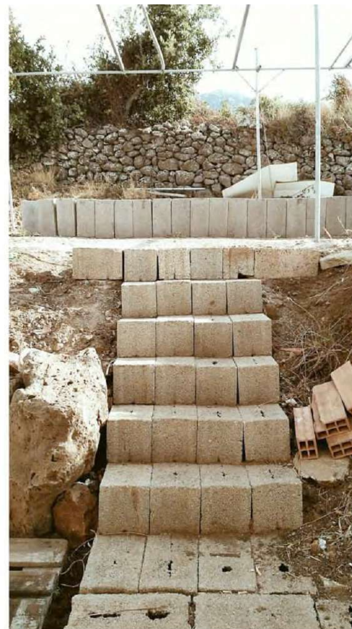
[ Figura 4.3 ] Architettura del 'bricoleur' pastore-contadino che reimpiega i materiali standardizzati della prefabbricazione edilizia e le tecniche e i lacerati locali per il lento e continuo adeguamento dell'azienda alle circostanze mutevoli;
