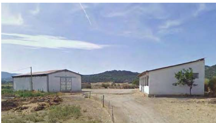
[ Figura 3.71b ] Benetutti, Goceano; fabbricati zootecnici di origine recente: a sinistra un hangar che ospita la sala mungitura, a destra una stalla-loggia semiaperta a falda singola, al centro un vasto spiazzo in terra battuta per la movimentazione dei mezzi mec-
