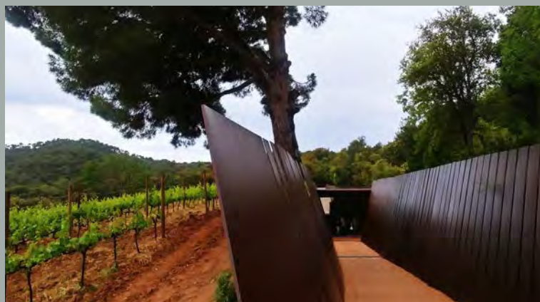
[ Figura 2.55 ] Rampa di ingresso della cantina ipogea.
