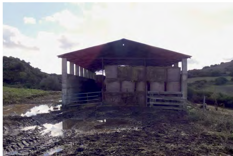
il grande hangar dei foraggi in setti di calcestruzzo e tettoia metallica, nuovo 'tempio' dell'agro
