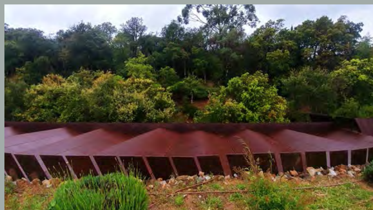
[ Figura 2.56 ] Copertura della cantina ipogea disposta sul margine tra vigna e bosco.
