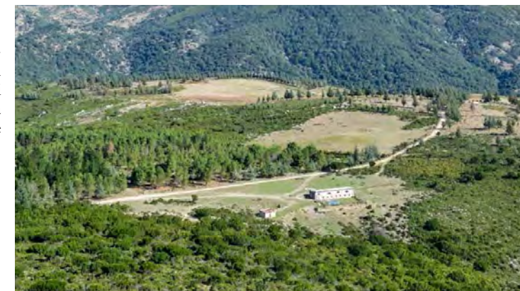
[ Figura 3.72d ] Seulo, Barbagia; Fabbricato a stecca con dispositivi monocellulari adibiti a stalle e ricoveri informali del bestiame brado in una radura pascolata sulle alture del Gennargentu;
