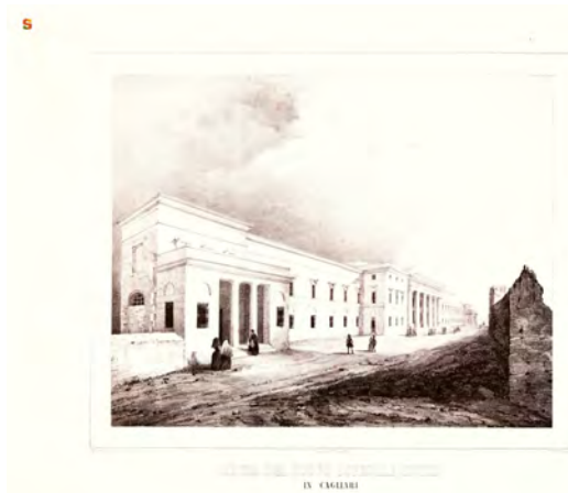
Figura 4.4.5.2. Veduta dell'Ospedale Civile di Cagliari, 1856, Materiale tratto da www.sardegnaigitallibrary.it - E. Gonin, ed. Doyen, Torino. Archivio Storico del Comune di Cagliari, Stampe antiche della città di Cagliari, 1.A.53.
