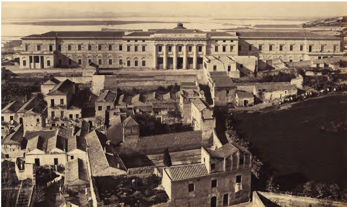
Figura 4.4.5.3. Vista dell'Ospedale Civile San Giovanni di Dio nel 1870. Archivio Storico del Comune di Cagliari, Fondo fotografico, Serie IX Collezioni e album, Collezione Cocco, foto n. 499.
