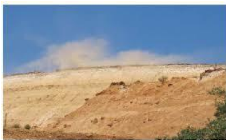
Figura 2.1. Discarica fanghi rossi a Montepioni (Italia). In foto, sono rappresentati i fini asportati dalle superfici dall'azione erosiva del vento (ISPRA, 2014)
