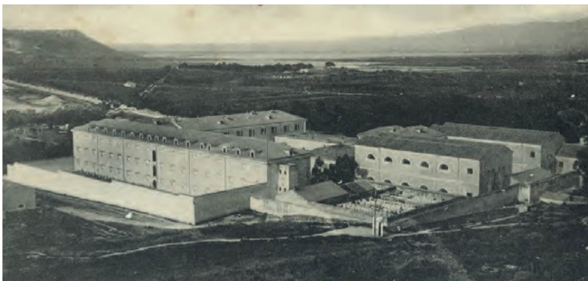
Fig. 108 - Cagliari, Immagine storica della Casa Penale di San Bartolomeo tratta da una cartolina ante 1905. Il penitenziario è inquadrato da sud-ovest. In primo piano, il corpo architettonico dei "Rustici", ormai riadattato a prigione; sullo sfondo, i fabbricati originari del complesso. Le antiche camere di detenzione sono più basse degli edifici di testata. Sulla destra, emergono i due corpi aggiuntivi risultano dell'ampliamento del 1862-1864. (ISRE, collezione Colombini, Nuoro, Sardegna Digital Library).
