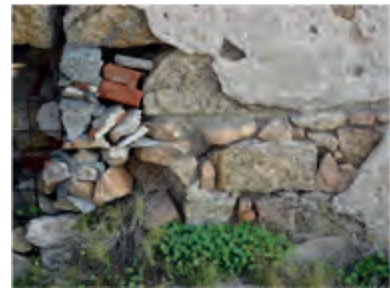
Fig. 126 - La Maddalena, Opera G. Pes, dettaglio di alcuni manufatti e tecniche costruttive: a) Batteria (PG002) con sistema di protezione a gabbia di Faraday; b) dettaglio della muratura in toccotti di granito della Batteria (PG002); c) postazione di vedetta; d) dettaglio della muratura in scapoli di pietrame misto del Corpo di Guardia (PG008) (2018).
