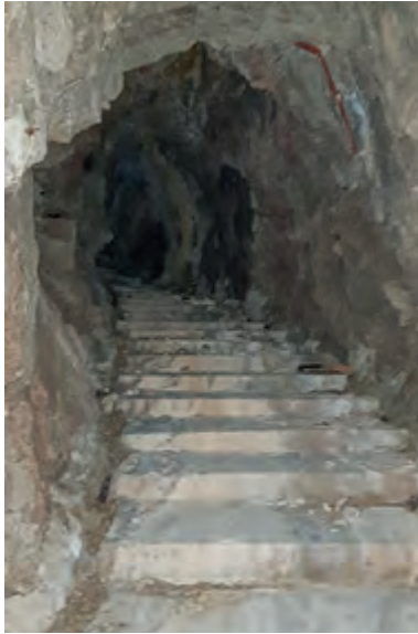
Fig. 129 - La Maddalena, Opera G. Pes, Batteria (PG002) interno dei camminamenti ipogei di collegamento tra la batteria e le postazioni (2019).
