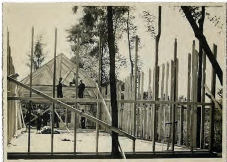
Fig. 90 - Immagine della costruzione di un padiglione di cui non è segnata la località (AUSSMA, fondo Geniodife).
